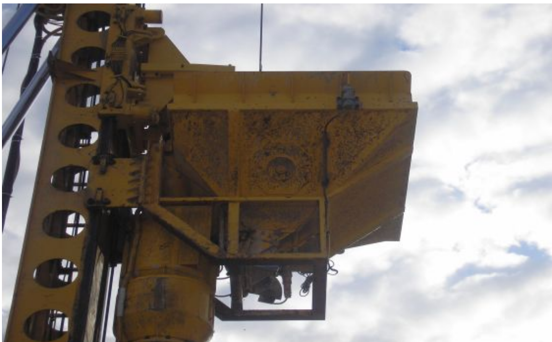
ΕΙΚΟΝΑ 5: Ανέλκυση της χοάνης για την εισαγωγή του χαλικιού στο δονητή
