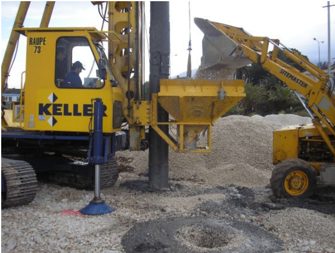
ΕΙΚΟΝΑ 4: Τοποθέτηση χαλικιού στο Vibrocat
