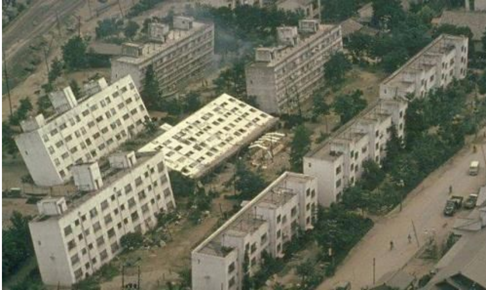
Εικόνα 1.1 Αστοχία θεμελιώσεων κτιρίων λόγω ρευστοποίησης του εδάφους κατά το σεισμό της Niigata, 1964 (Μπουκοβάλας, 2007).
