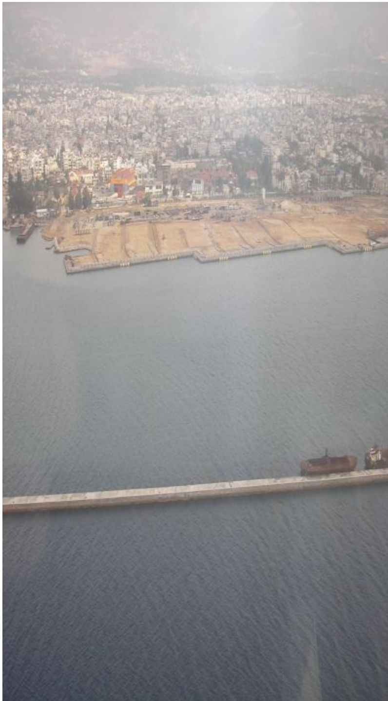
ΕΙΚΟΝΑ 10: Άποψη λιμένα (από ελικόπτερο) μετά την εκκίνηση των κτηριακών εργασιών.
