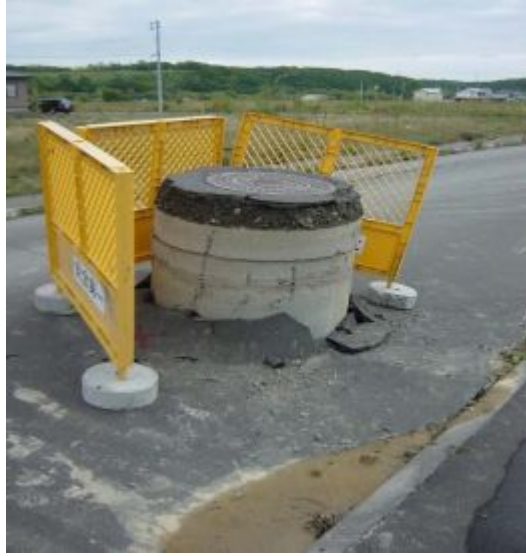
Εικόνα 1.3 Ανάδυση φρεατίου λόγω ρευστοποίησης του εδάφους στην Hokkaido, 2003 (Μπουκοβάλας, 2007).
