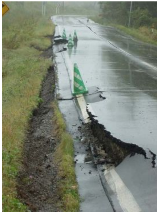
Εικόνα 1.4 Αστοχία πρανούς σε δρόμο λόγο ρευστοποίησης του στην Hokkaido, 2003 (Μπουκοβάλας, 2007).
