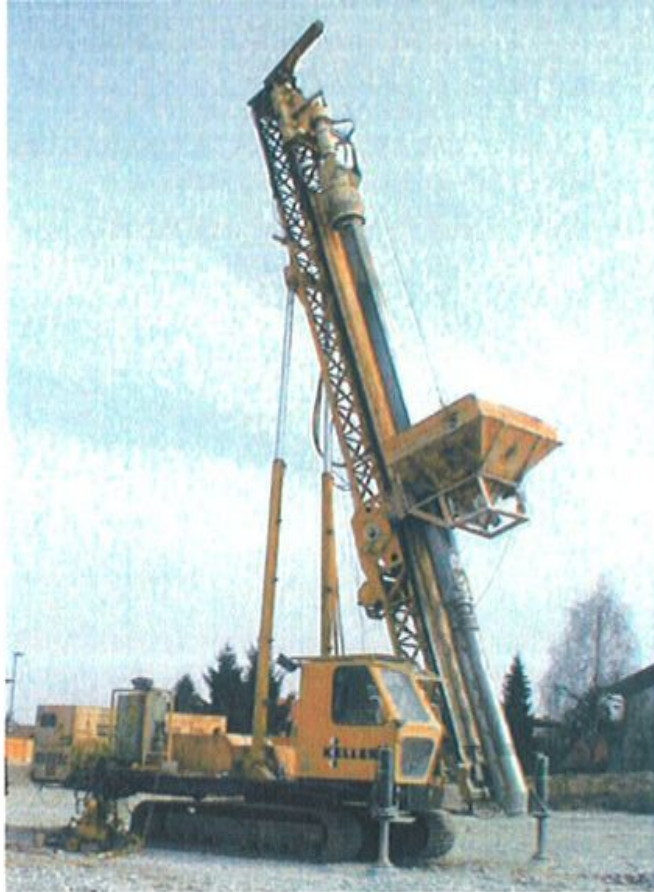
Εικ. 3.4 Το Ειδικό μηχάνημα(Vibrocat) που χρησιμοποιήθηκε για την κατασκευή των χαλικοπασσάλων στο Νέο Λιμένα Πατρών
