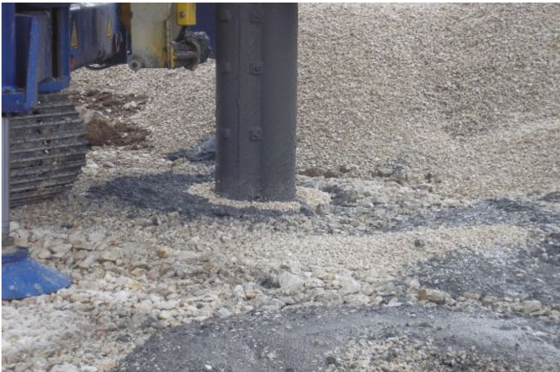
ΕΙΚΟΝΑ 7: Τοποθέτηση χαλικοπασσάλου (έξοδος του δονητή από το έδαφος)
