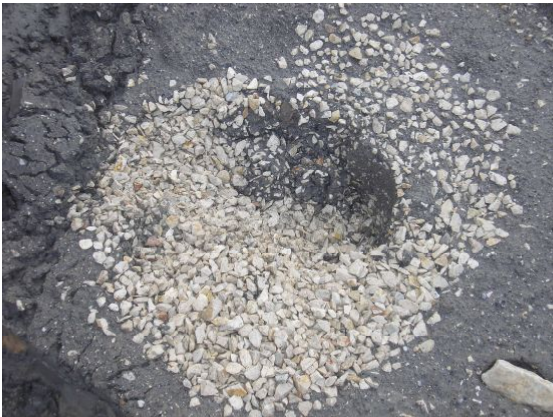
ΕΙΚΟΝΑ 9: Κεφαλή κατασκευασμένου χαλικοπασσάλου.
