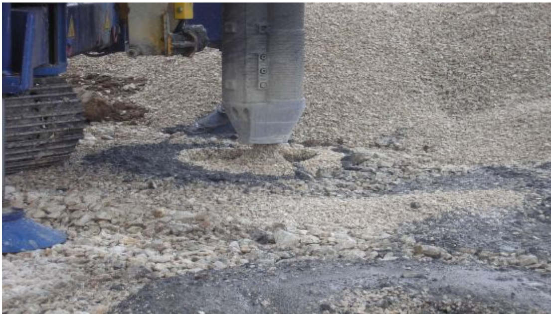
ΕΙΚΟΝΑ 8: Ολοκλήρωση της διαδικασίας τοποθέτησης του χαλικοπασσάλου
