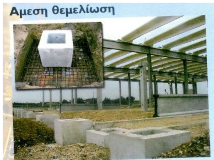
Εικ. 3.3 α) Απλή και άμεση έναρξη της υποδομής των θεμελιώσεων μετά την κατασκευή των χαλικοπασσάλων
