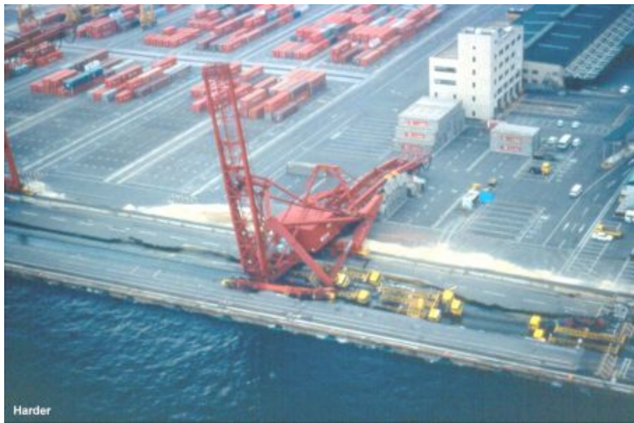
Εικόνα 1.5 Αποτελέσματα της αστοχίας λιμενικού κρηπιδότοιχου λόγω ρευστοποίησης του εδάφους κατά το σεισμό του Kobe, 1995 (Μπουκοβάλας, 2007).
