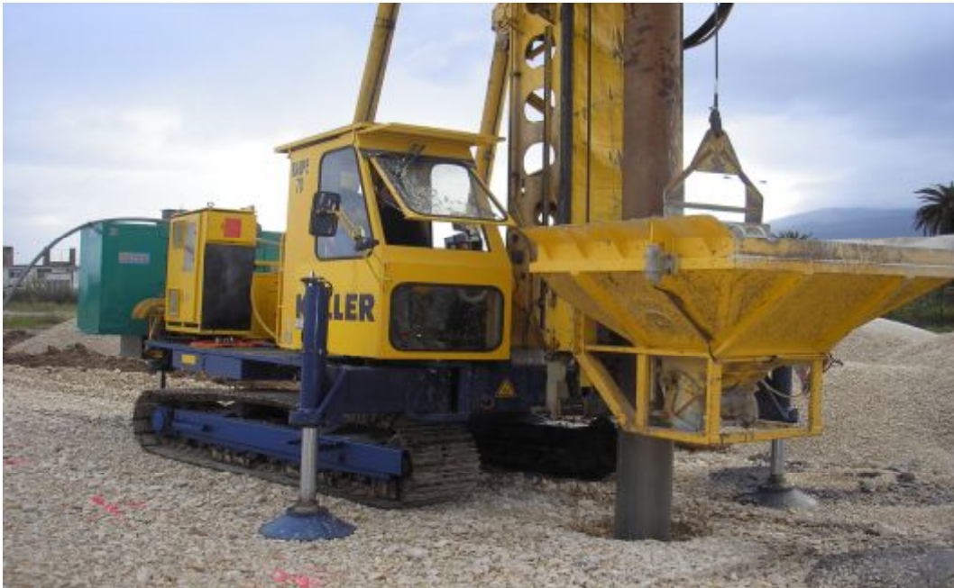
ΕΙΚΟΝΑ 7: Τοποθέτηση χαλικοπασσάλου (έξοδος του δονητή από το έδαφος)
