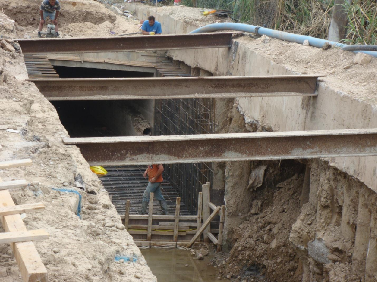
Φωτ.10 Αντιστήριξη πρανών με αντιρίδες και πασσαλομπήξεις από σκυρόδεμα
