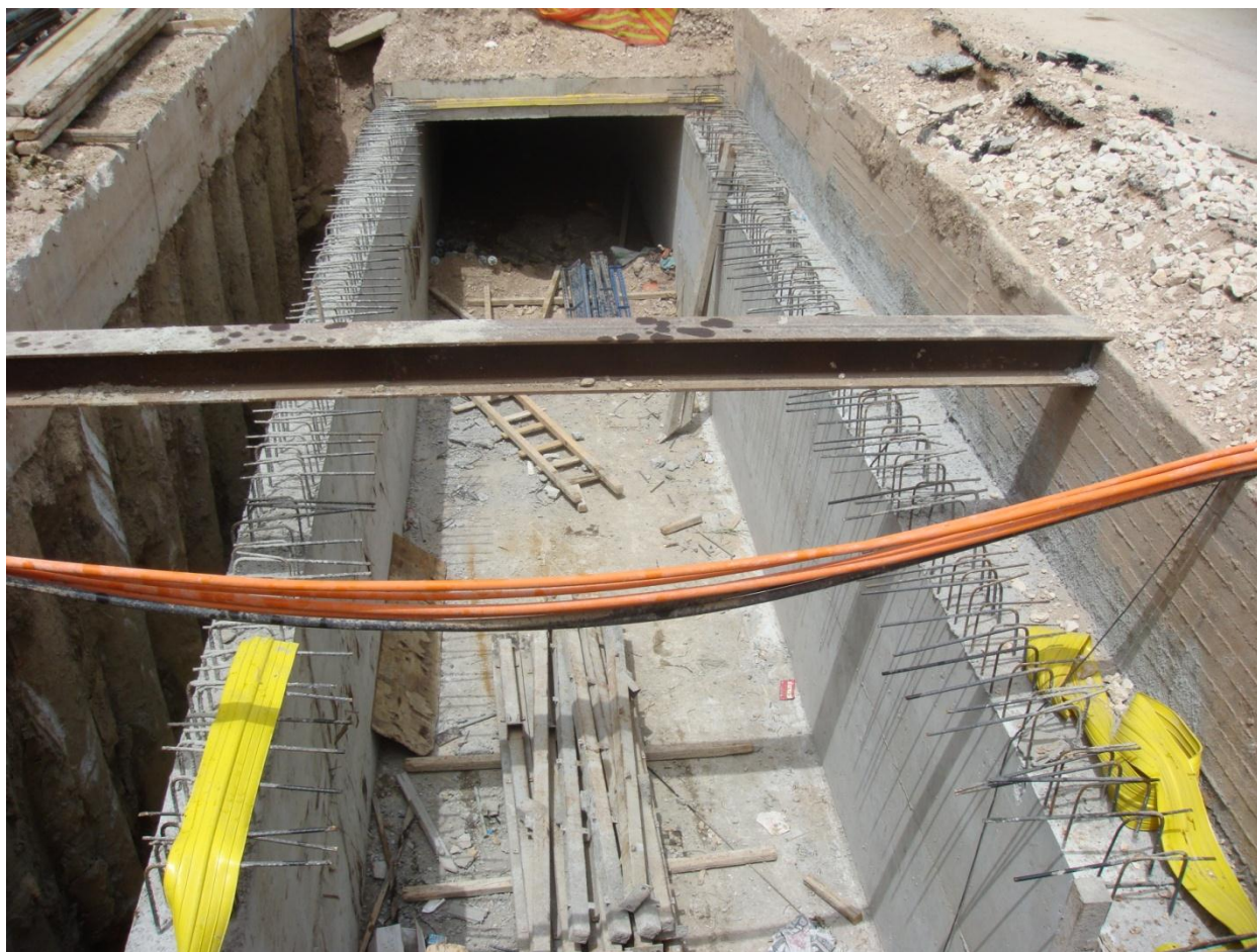
Φωτ.8 Αντιστήριξη πρανών με αντιρίδες και πασσαλομπήξεις από σκυρόδεμα
