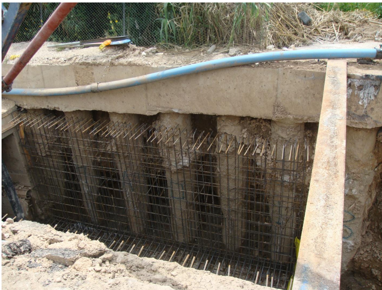
Φωτ.9 Αντιστήριξη πρανών με πασσαλομπήξεις από σκυρόδεμα
