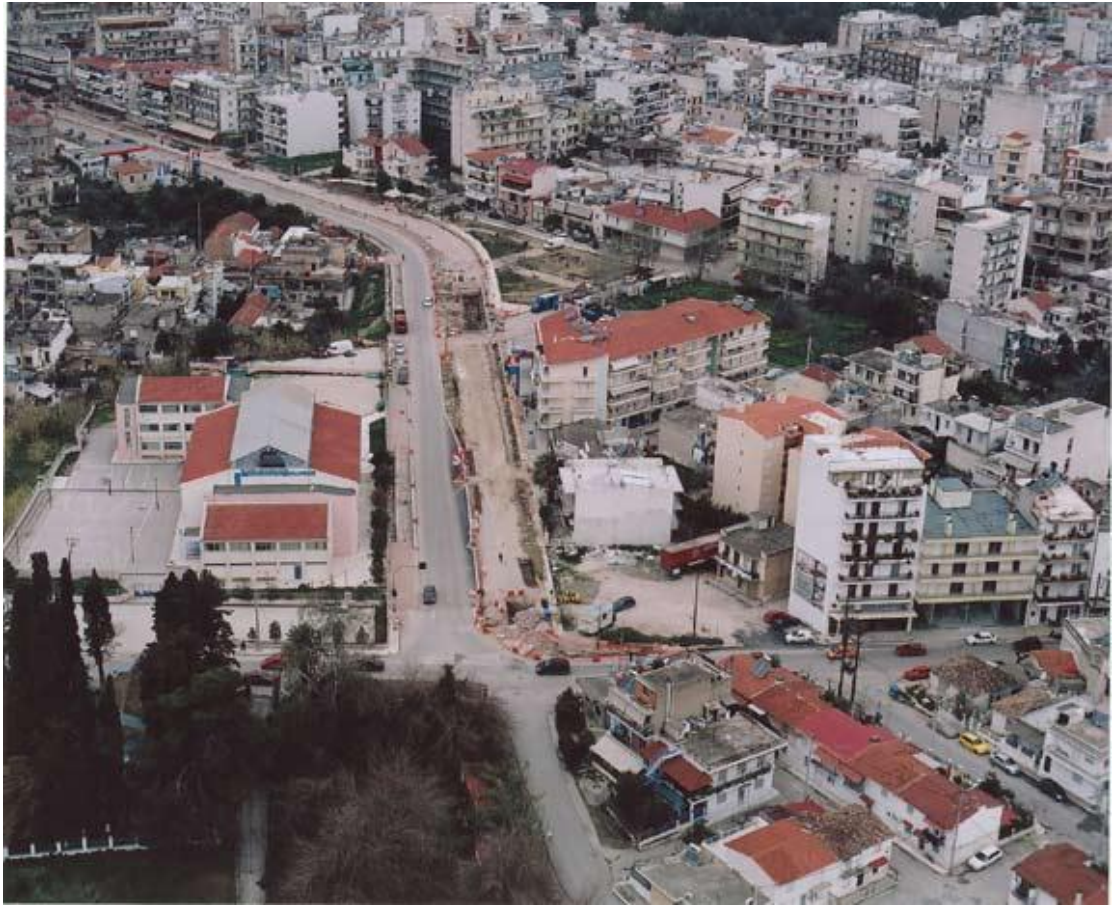
Φωτ. 3 Αεροφωτογραφία – Διασταύρωση οδού Ελ. Βενιζέλου – Αγ. Ιωάννη Πράτσικα ( Χ.Θ. ΕΡΓΟΥ 1+110,00)
