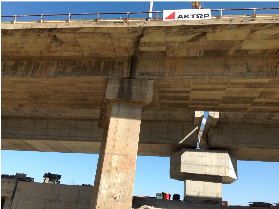
Φωτογραφία 5.2: Κατάστρωμα και μεσόβαθρο παλαιάς και νέας γέφυρας Λαδοποτάμου.
