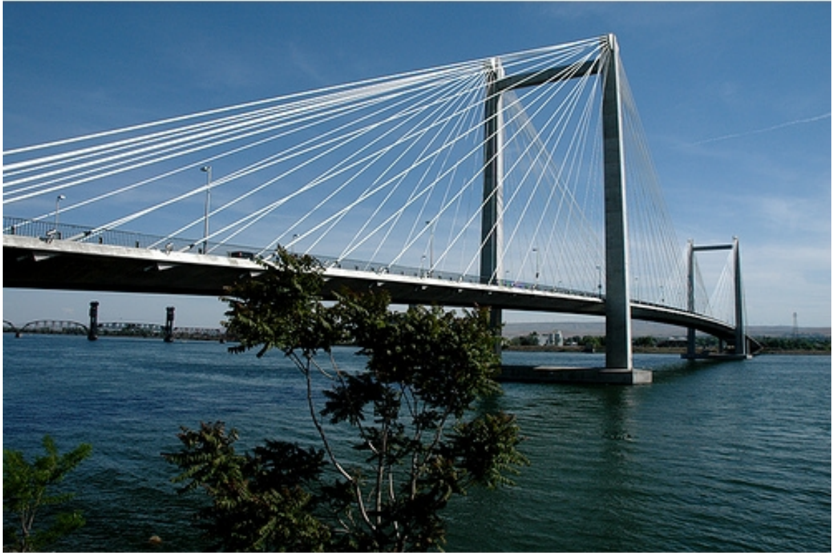
Εικόνα 1.15: Γέφυρα στον ποταμό Columbia στο Pasco – Kennewick [9] .
