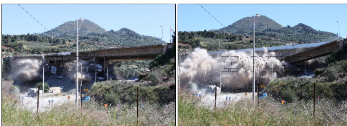
Εικόνα 3.3: Κατεδάφιση της Γέφυρας [2] .
