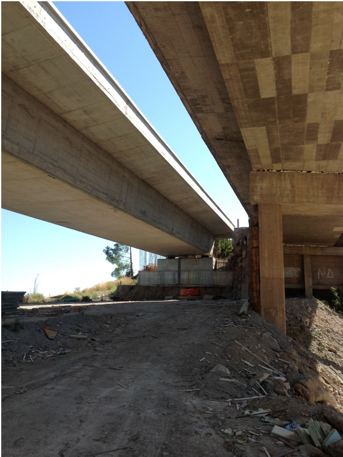
Φωτογραφία 5.4: Όψη του καταστρώματος των κλάδων παλαιάς και νέας γέφυρας.
