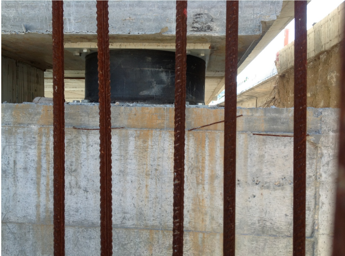
Φωτογραφία 5.9: Όψη εφεδράνου στήριξης του καταστρώματος της νέας γέφυρας στο μεσόβαθρο.
