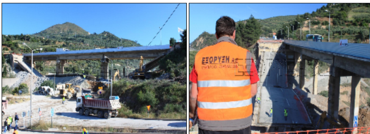
Εικόνα 3.4: Αμέσως μετά την κατεδάφιση της Γέφυρας (αριστερά) και εκτροπή κυκλοφορίας στον παραμένοντα αριστερό κλάδο (δεξιά) [2] .
