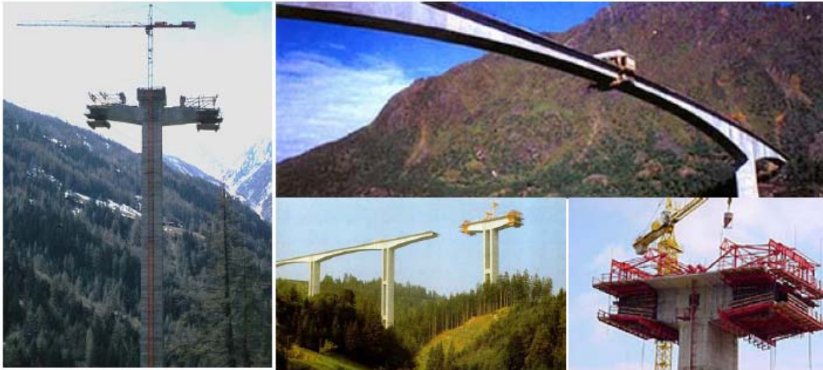
Εικόνα 2.3: Διάφορες γέφυρες με προβολοδόμηση [4] .
