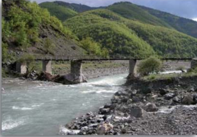
Εικόνα 1.1: Γέφυρα με λίθινα βάθρα και ξύλινο κατάστρωμα. Γέφυρα στον ποταμό Σαραντάπορο (αριστερά) και σκίτσο (δεξιά) [7] .
