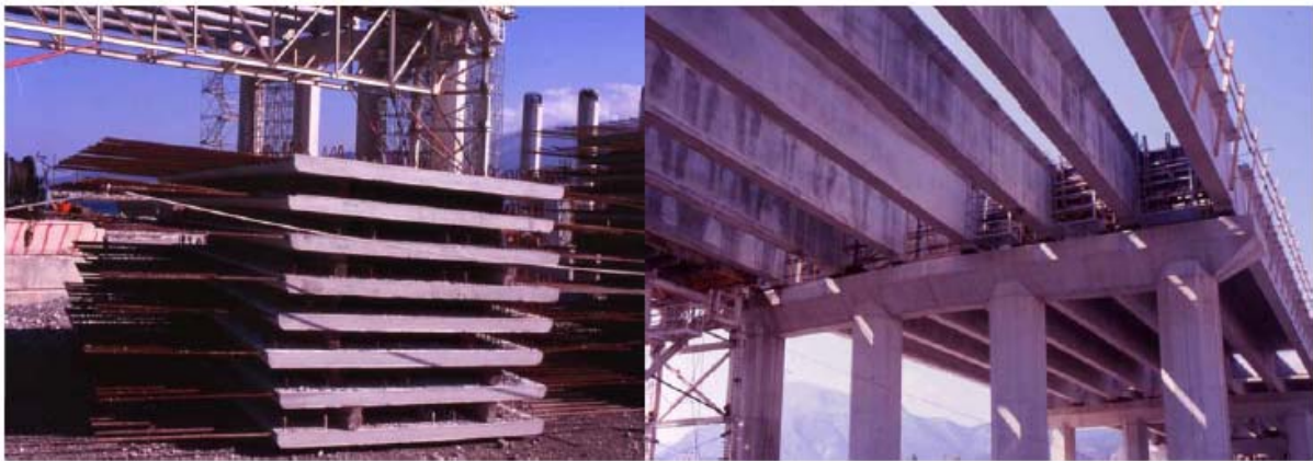
Εικόνα 2.2: Πρόπλακες με ενσωματωμένο στις δοκούς εγκάρσιο κάτω οπλισμό πλάκας καταστρώματος (Γέφυρες πρόσβασης Ρίου Αντιρρίου, Γέφυρα Α.Ε.) [4] .
