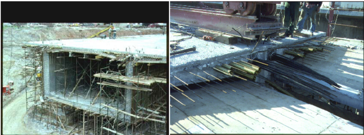
Εικόνα 2.4: Τένοντες προβόλου στην πάνω πλάκα, προβολοδόμηση Γέφυρας Ισθμού (ΠΑΘΕ, Παντεχνική) [4] .
