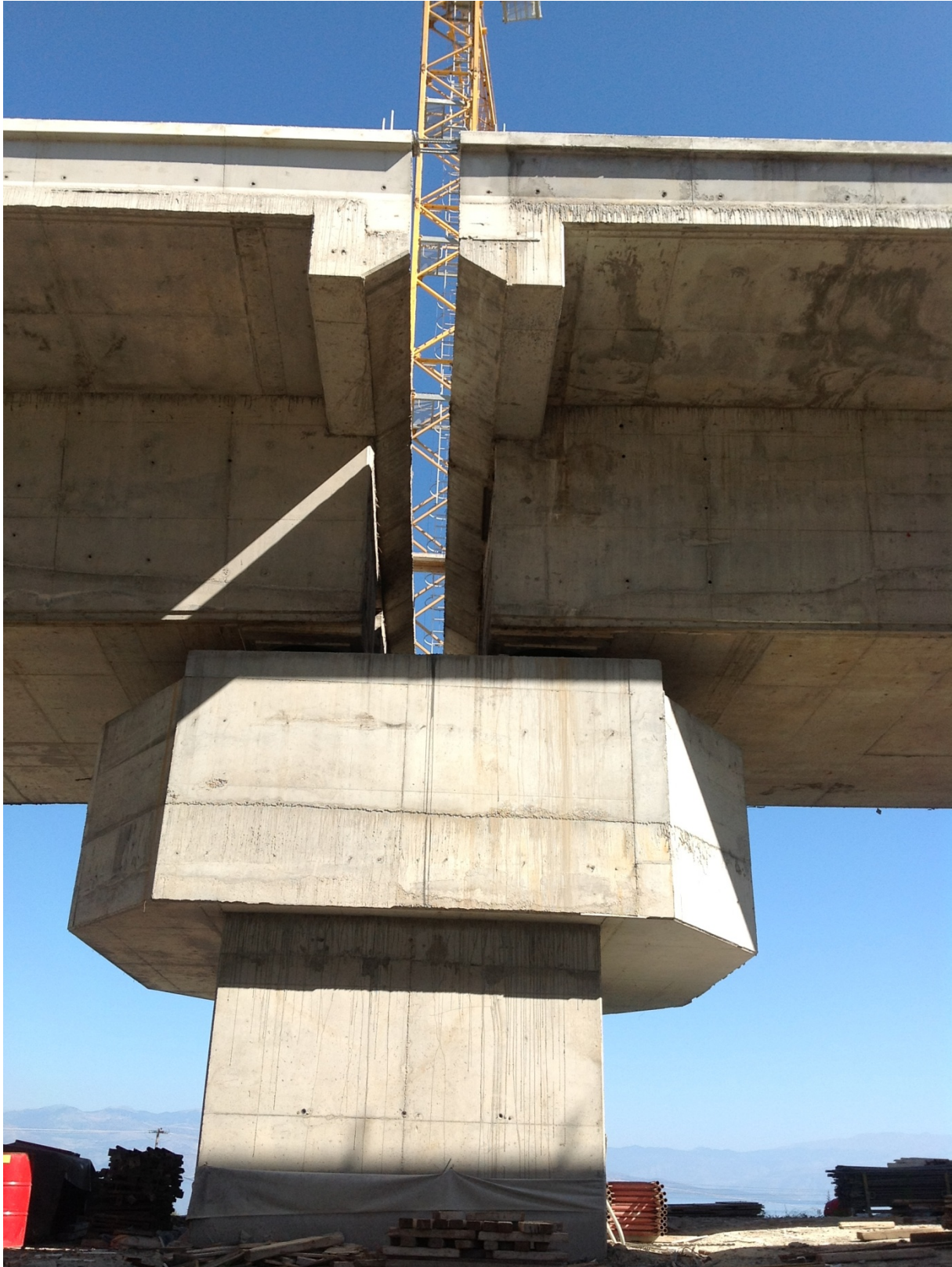
Φωτογραφία 5.5: Λεπτομέρεια της σύνδεσης του κλάδου της νέας γέφυρας στο μεσόβαθρο, και ο σχετικός κατασκευαστικός αρμός.
