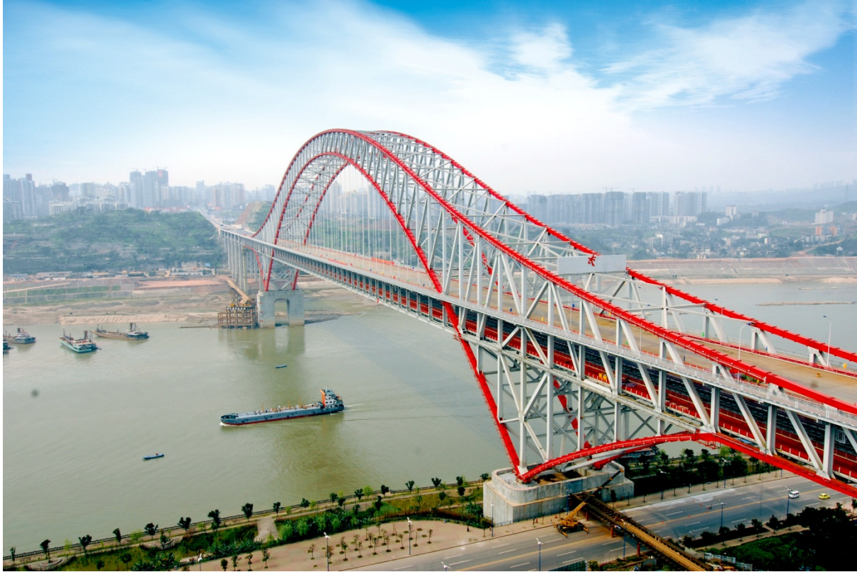
Εικόνα 1.14: Γέφυρα Chaotianmen Bridge στην Κίνα [10] .
