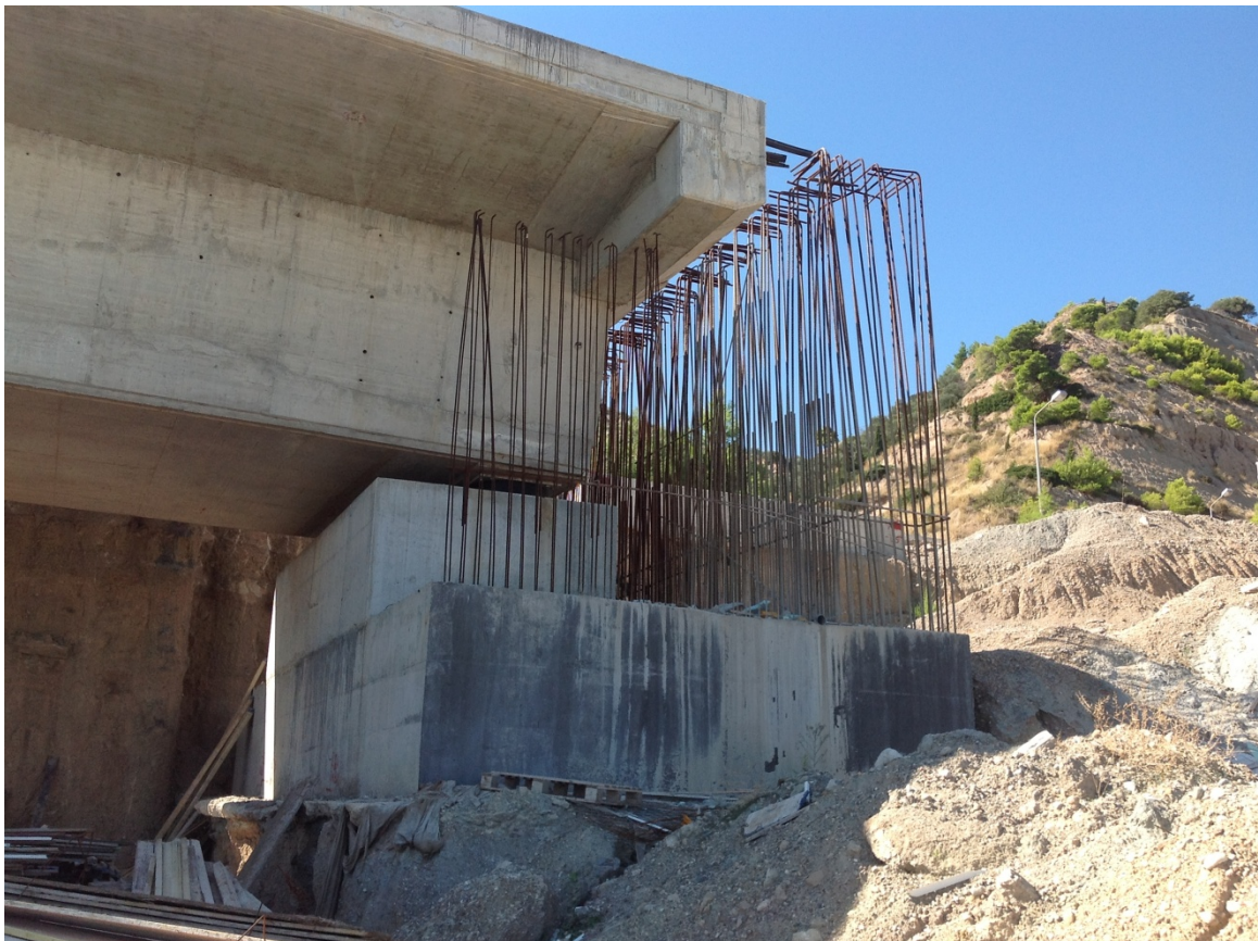
Φωτογραφία 5.7: Οπλισμοί ακρόβαθρου της νέας γέφυρας.
