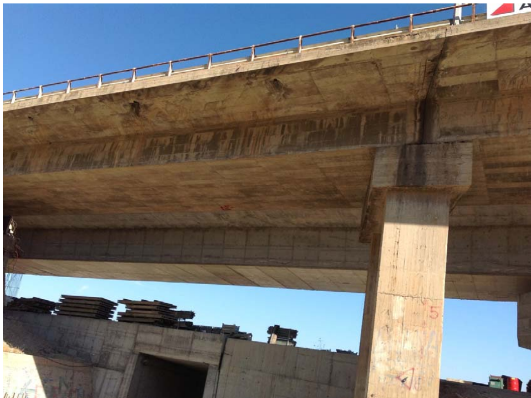
Φωτογραφία 5.3: Κοντινό πλάνο καταστρώματος και μεσόβαθρου παλαιάς γέφυρας. Διακρίνονται οι αγωγοί απορροής υδάτων
