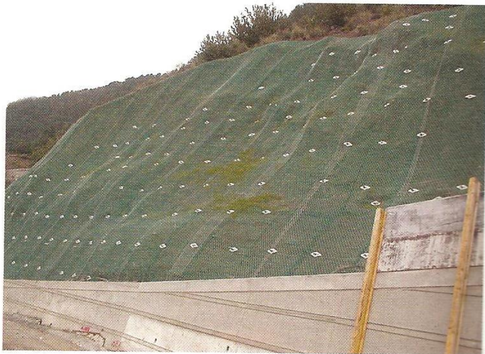
Εικόνα 2.5 Γεωπλέγμα προστασίας πρανών
