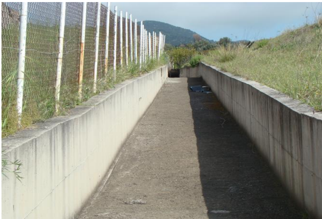
Εικ. 6. Διώρυγα μεταφοράς υδάτων προς τη λιμνοδεξαμενή.
