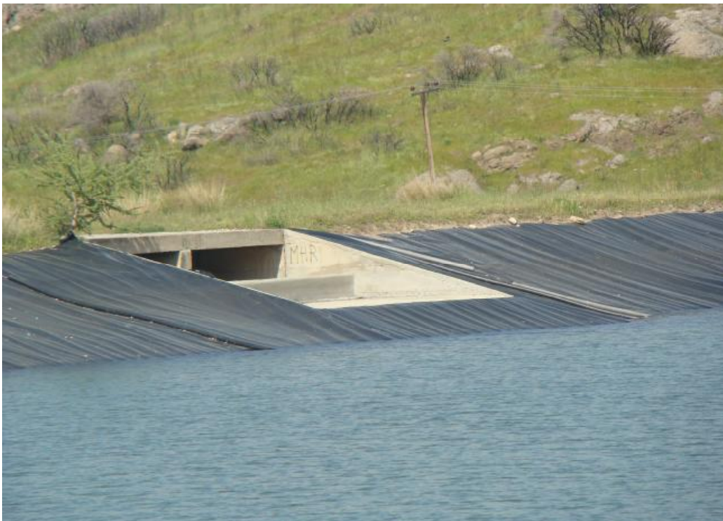
Εικ. 7β. Έργα εισόδου υδάτων στη λιμνοδεξαμενή
