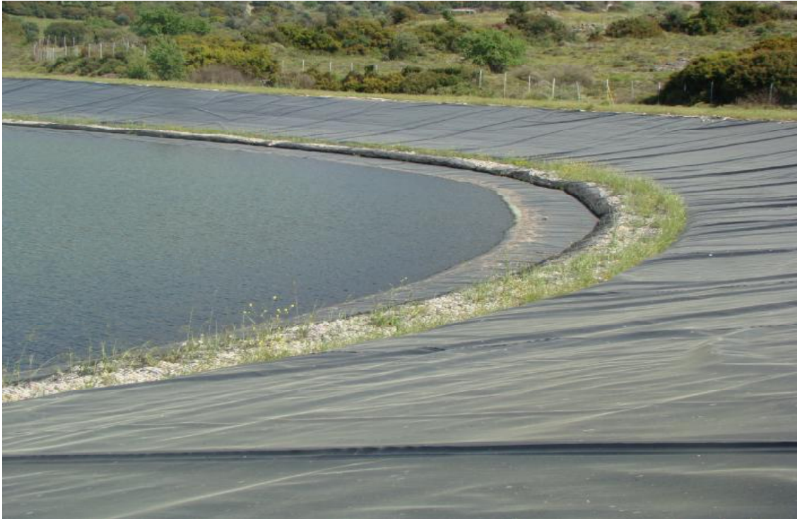
Εικ. 4. Τοποθέτηση μεμβράνης πάνω στο ανάχωμα
