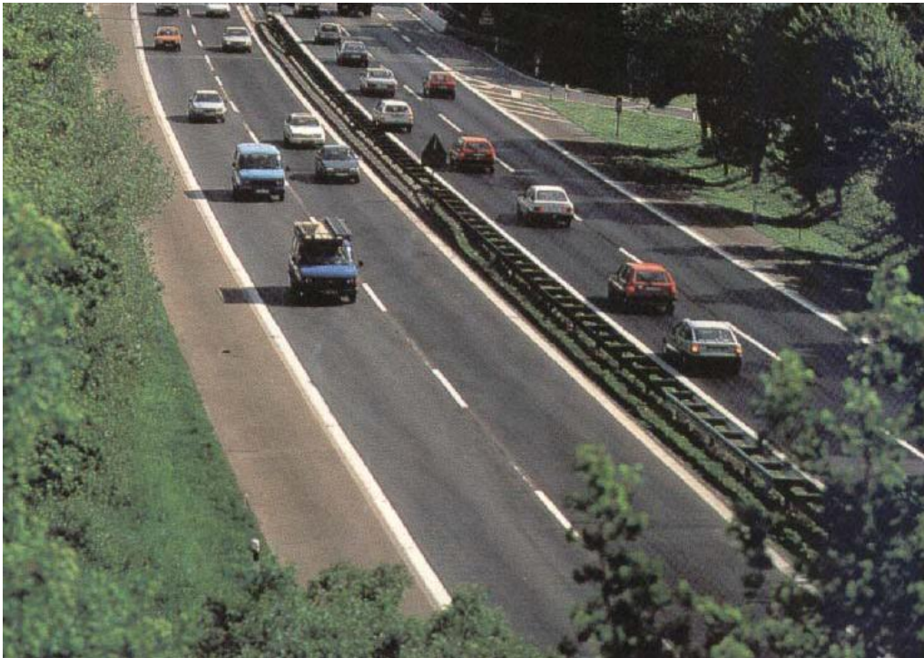
Εικόνα 5.3: Παράδειγμα αμφίπλευρου στηθαίου σε ενδιάμεσο χώρο.
