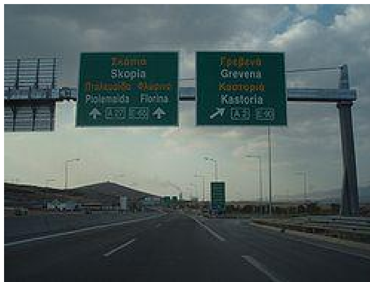
Εικόνα 4.8: Παράδειγμα γέφυρας σήμανσης.
