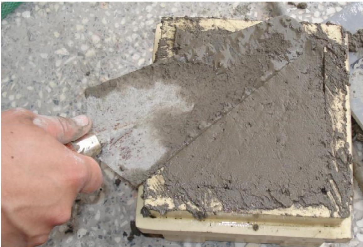
Φωτογραφία: Διαμόρφωση της τελικής επιφάνειας με μυστρί.
