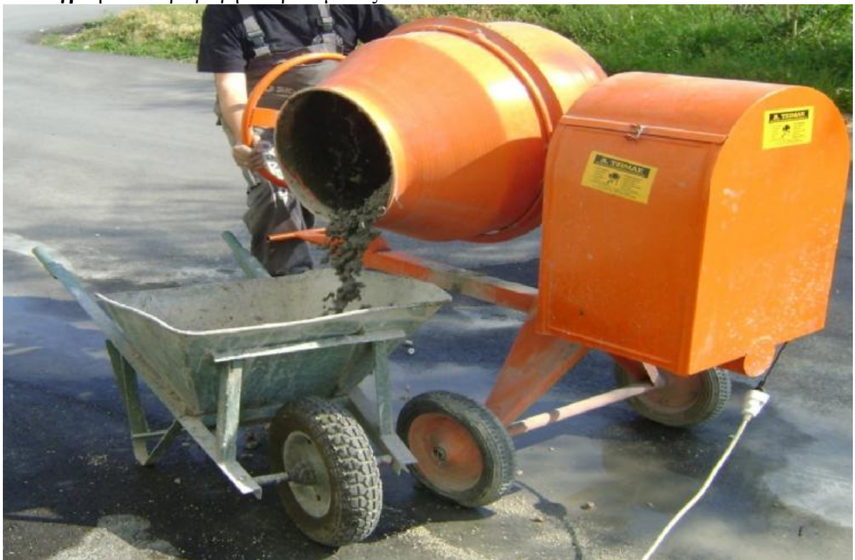
Φωτογραφία: Παραγωγή σκυροδέματος.
