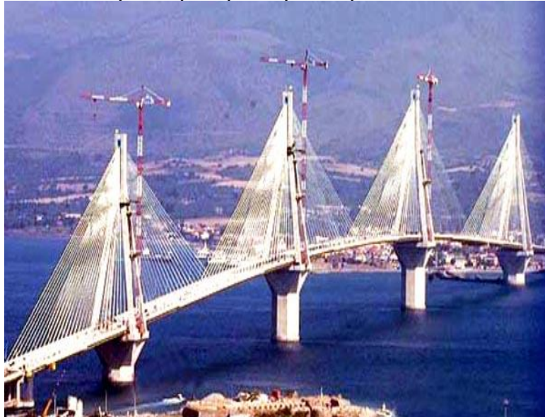
Καλωδιωτή Γέφυρα Ρίου- Αντιρρίου
