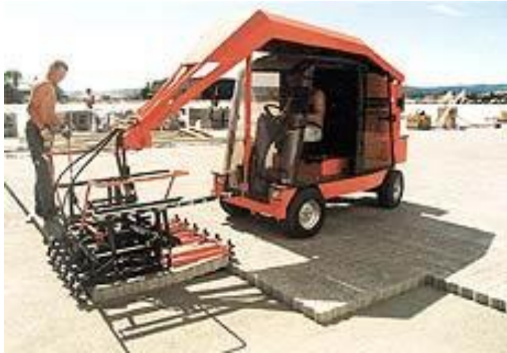
Φωτ. 7 : Μηχανική διάστρωση κυβολίθων
