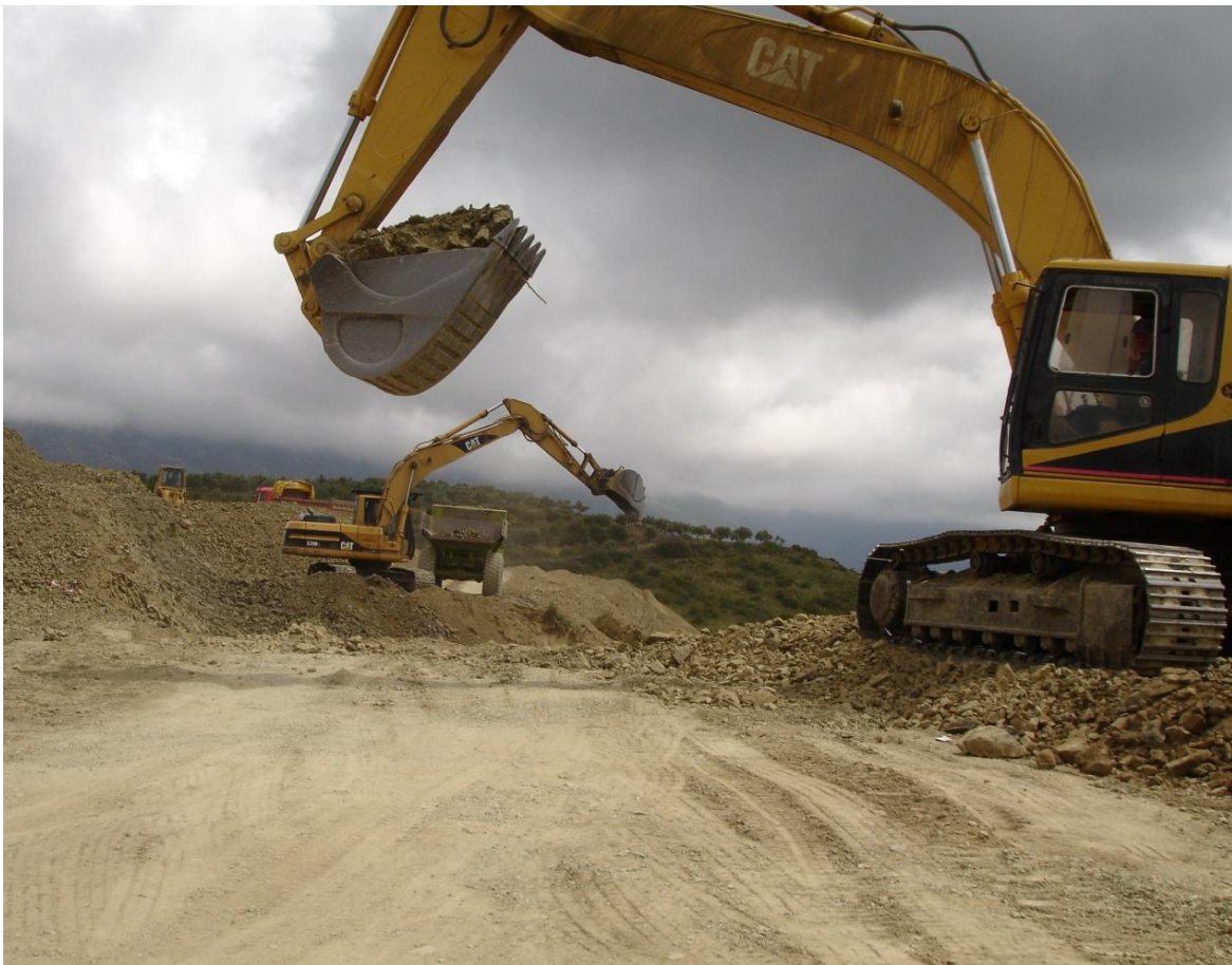
Εικόνα 1 Κατασκευή παράκαμψης επαρχιακής οδού Φιλιατρών – Χριστιανούπολης (Ψηφιακό υλικό, 2012)
