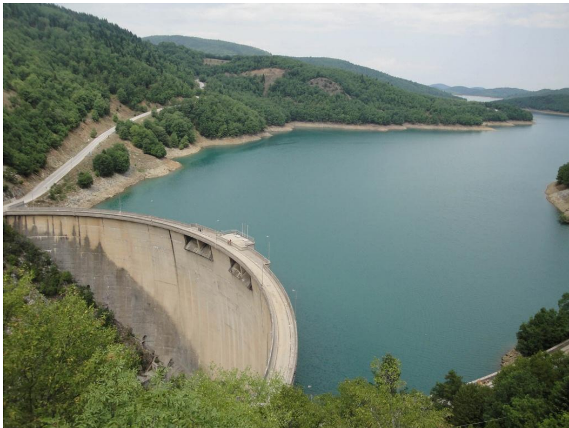
Εικόνα 2.12 Απεικόνιση ταμιευτήρα από το φράγμα λίμνης Πλαστήρα, Ταυρωπού (Διαδίκτυο,2012)
