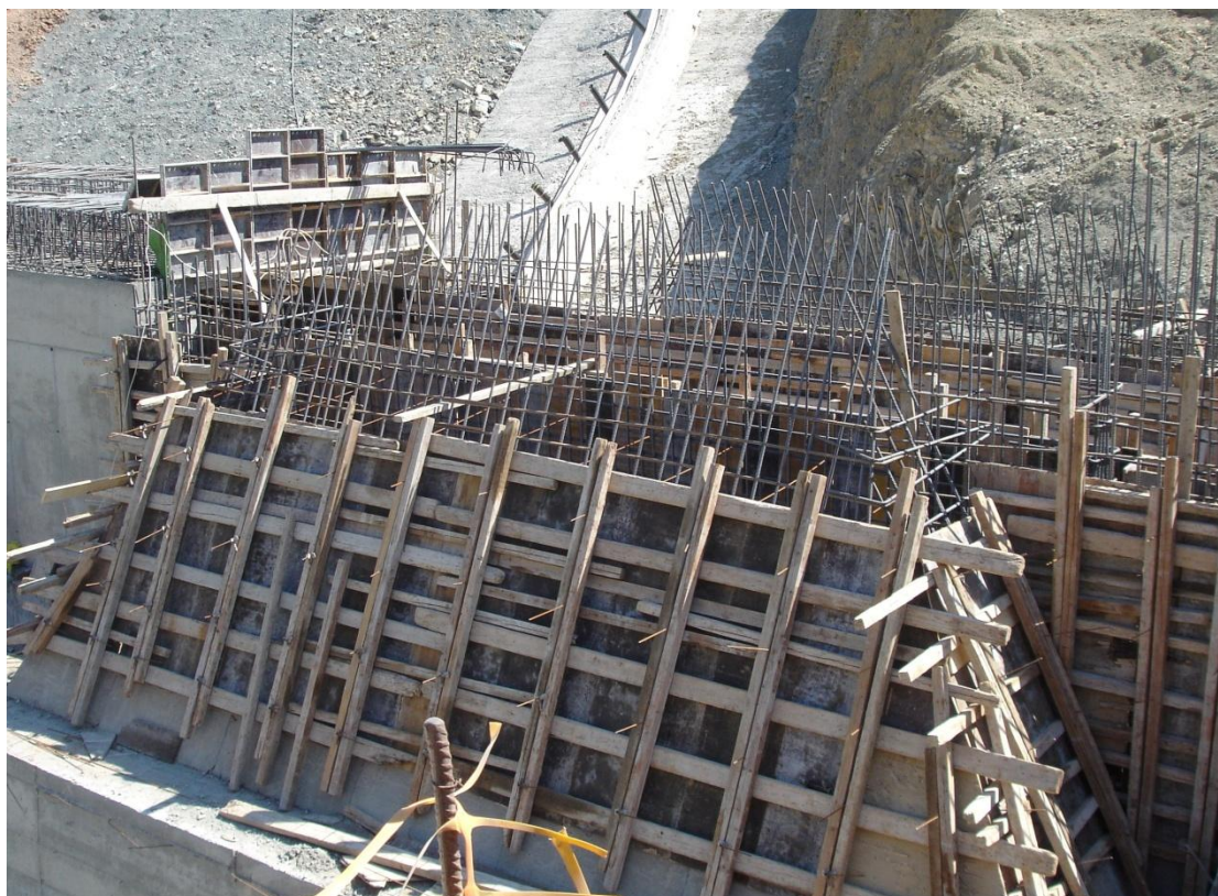
Εικόνα 4.10 Κατασκευή – Όπλιση του πύργου υδροληψίας (Ψηφιακό υλικό, 2012)
