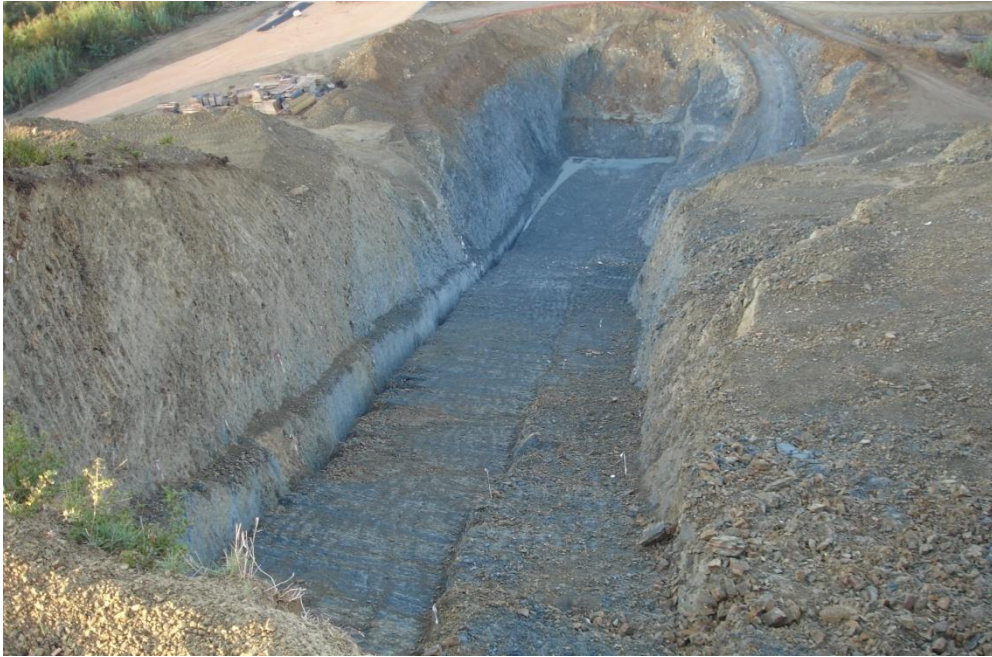
Εικόνα 16 Λεπτομέρεια ενίσχυσης της έδρασης του φράγματος με αρχική εκσκαφή (Ψηφιακό υλικό, 2012)
