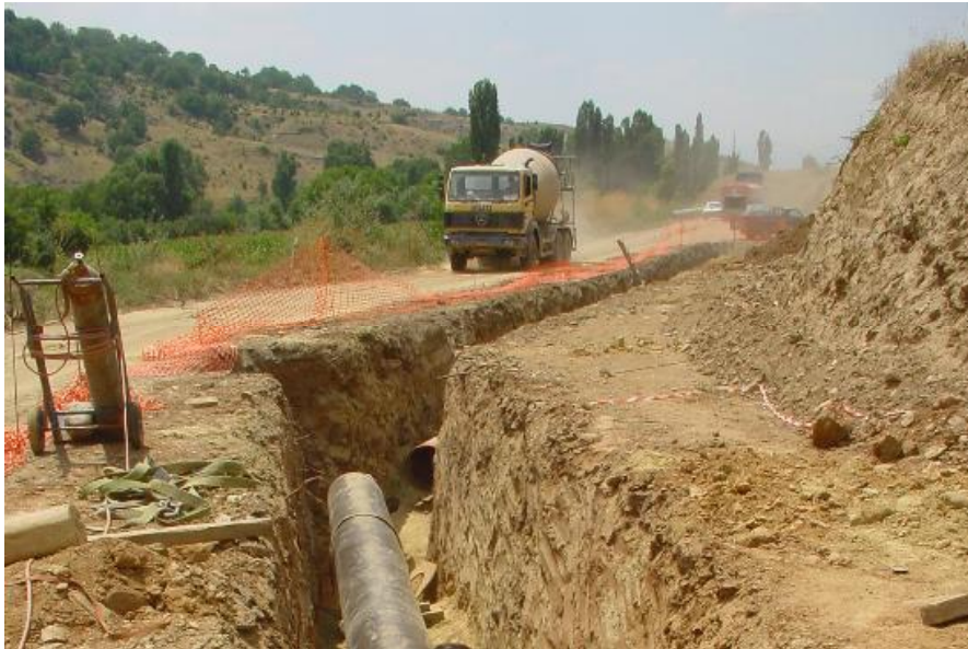
Εικόνα 4.7 Κατασκευή αγωγού μεταφοράς νερού (Διαμορφωμένο από διαδίκτυο, 2012)
