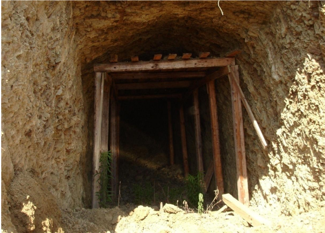
Εικόνα 6 Ερευνητική σήραγγα αριστερού αντερείσματος στο στάδιο της μελέτης (Ψηφιακό υλικό, 2012)
