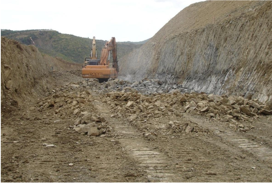
Εικόνα 4 Κατασκευή παράκαμψης επαρχιακής οδού (Ψηφιακό υλικό, 2012).
