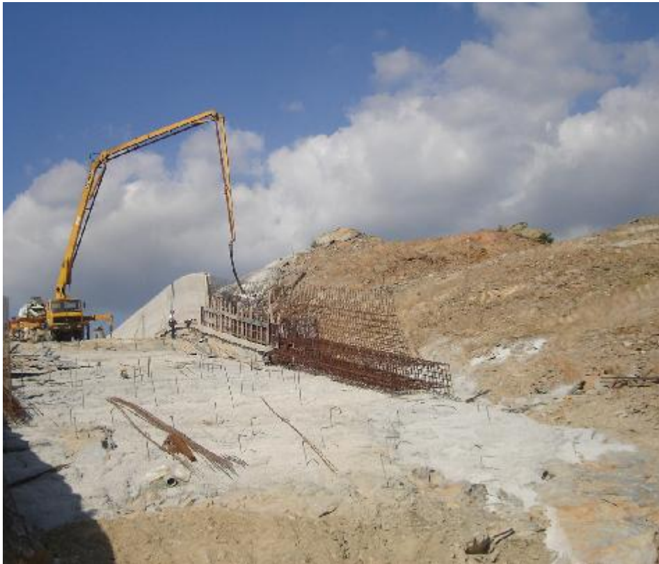
Εικόνα 2.15 Σκυροδέτηση τμήματος υπερχειλιστή του χωμάτινου φράγματος Παπαδιάς στην περιοχή Φλώρινας (Διαδίκτυο, 2012)
