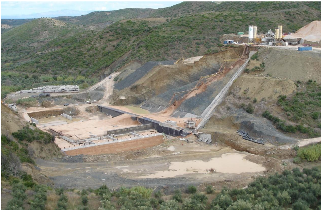
Εικόνα 17 Γενική άποψη του έργου (Ψηφιακό υλικό, 2012)
