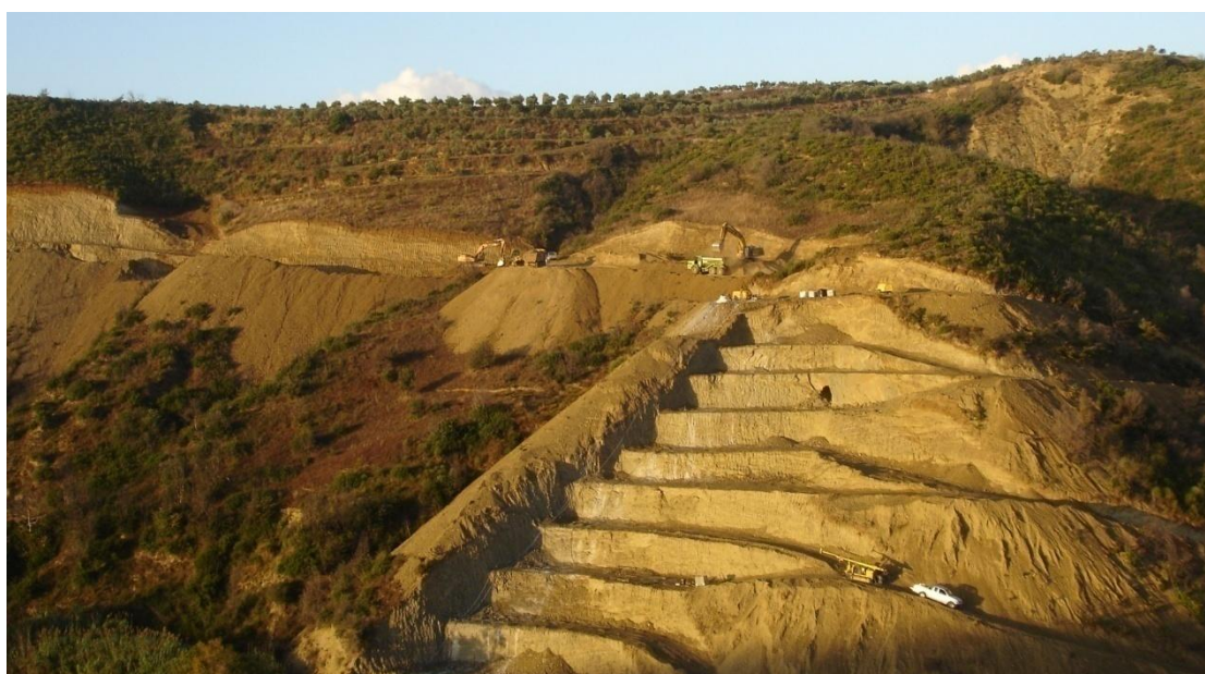
Εικόνα 9 Τσιμεντενέσεις στεγάνωσης στο αριστερό αντέρεισμα (Ψηφιακό υλικό, 2012)
