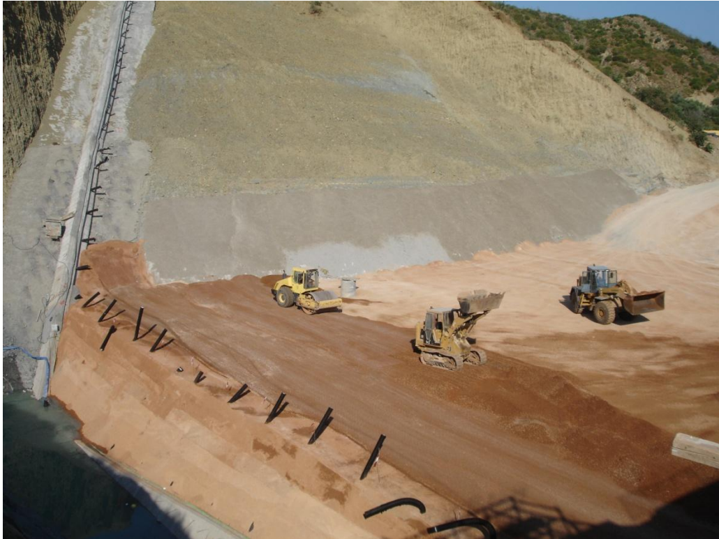
Εικόνα 14 Τοποθέτηση αγωγών για την αποστράγγιση της υγρασίας του εδάφους (Ψηφιακό υλικό, 2012)
