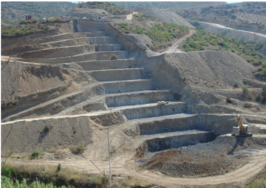
Εικόνα 5 Τσιμεντενέσεις στεγάνωσης στη θέση της πλίνθου (Ψηφιακό υλικό, 2012)
