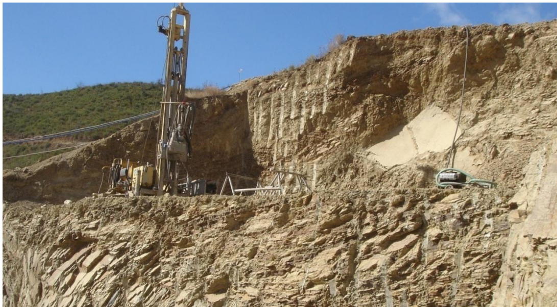
Εικόνα 7 Τσιμεντενέσεις στο αριστερό αντέρεισμα (Ψηφιακό υλικό, 2012)
