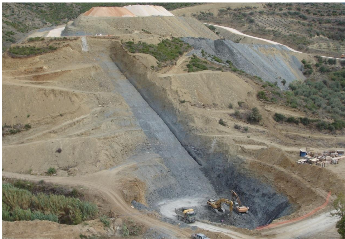
Εικόνα 8 Εκσκαφή πλίνθου δεξιού αντερείσματος (Ψηφιακό υλικό, 2012)
