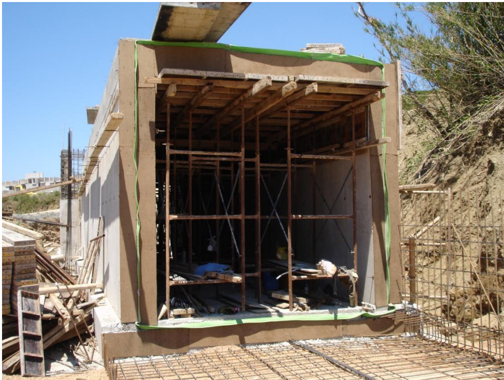
Εικόνα 4.8 Κατασκευή στοάς οριστικής εκτροπής υδάτων (Ψηφιακό υλικό, 2012)
