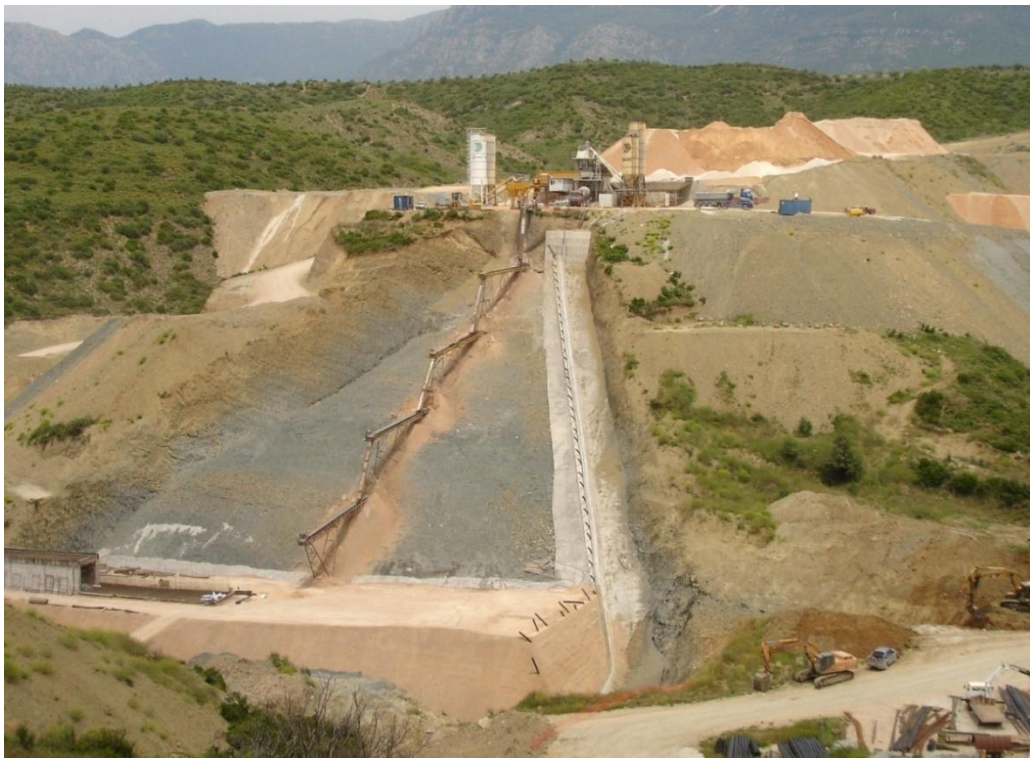
Εικόνα 15 Κατασκευή τμήματος σκληρού επιχώματος για την έδραση των έργων οριστικής εκτροπής υδάτων (Ψηφιακό υλικό, 2012).
