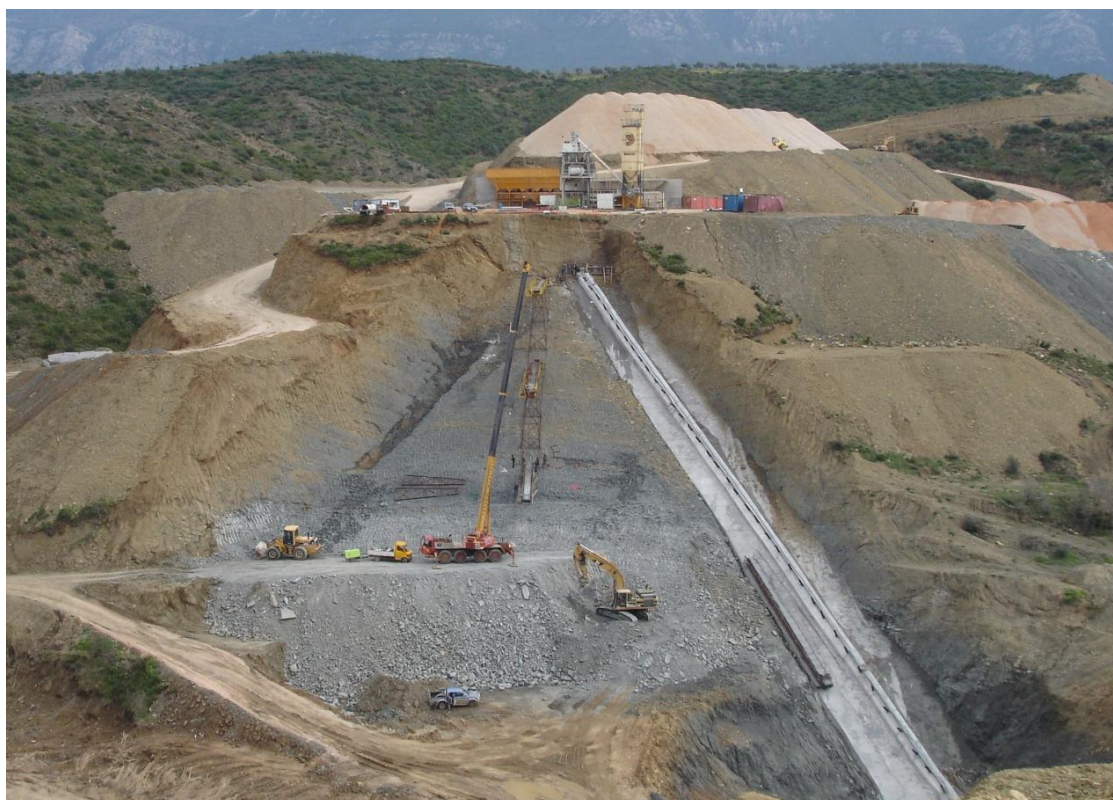
Εικόνα 11 Τοποθέτηση ταινιών μεταφοράς σκληρού επιχώματος (Ψηφιακό υλικό, 2012)
