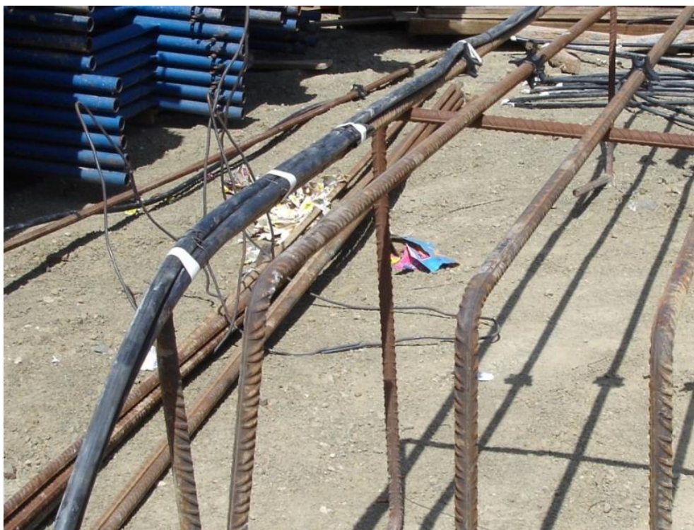
Εικόνα 12 Κατασκευή αγκυρίων για το έργο καταστροφής ενέργειας (Ψηφιακό υλικό, 2012)
