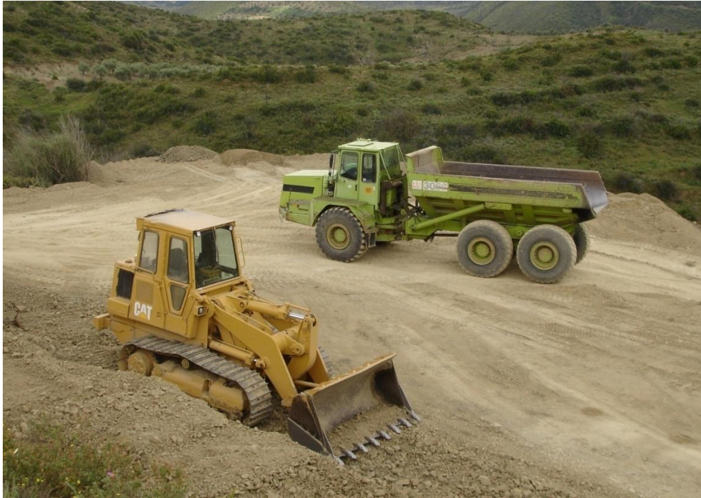
Εικόνα 2 Διαμόρφωση εργοταξιακών χώρων ανάντι του δεξιού αντερείσματος του φράγματος (Ψηφιακό υλικό, 2012)
