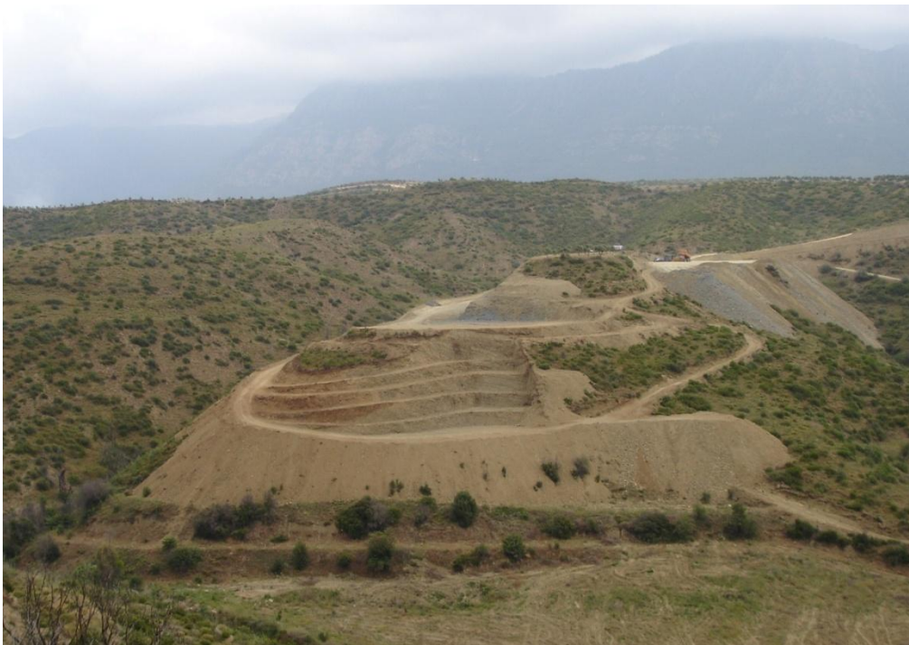
Εικόνα 3 Εκσκαφή δεξιού αντερείσματος σε βαθμίδες για την εκτέλεση τσιμεντενέσεων στη θέση της πλίνθου (Ψηφιακό υλικό, 2012).
