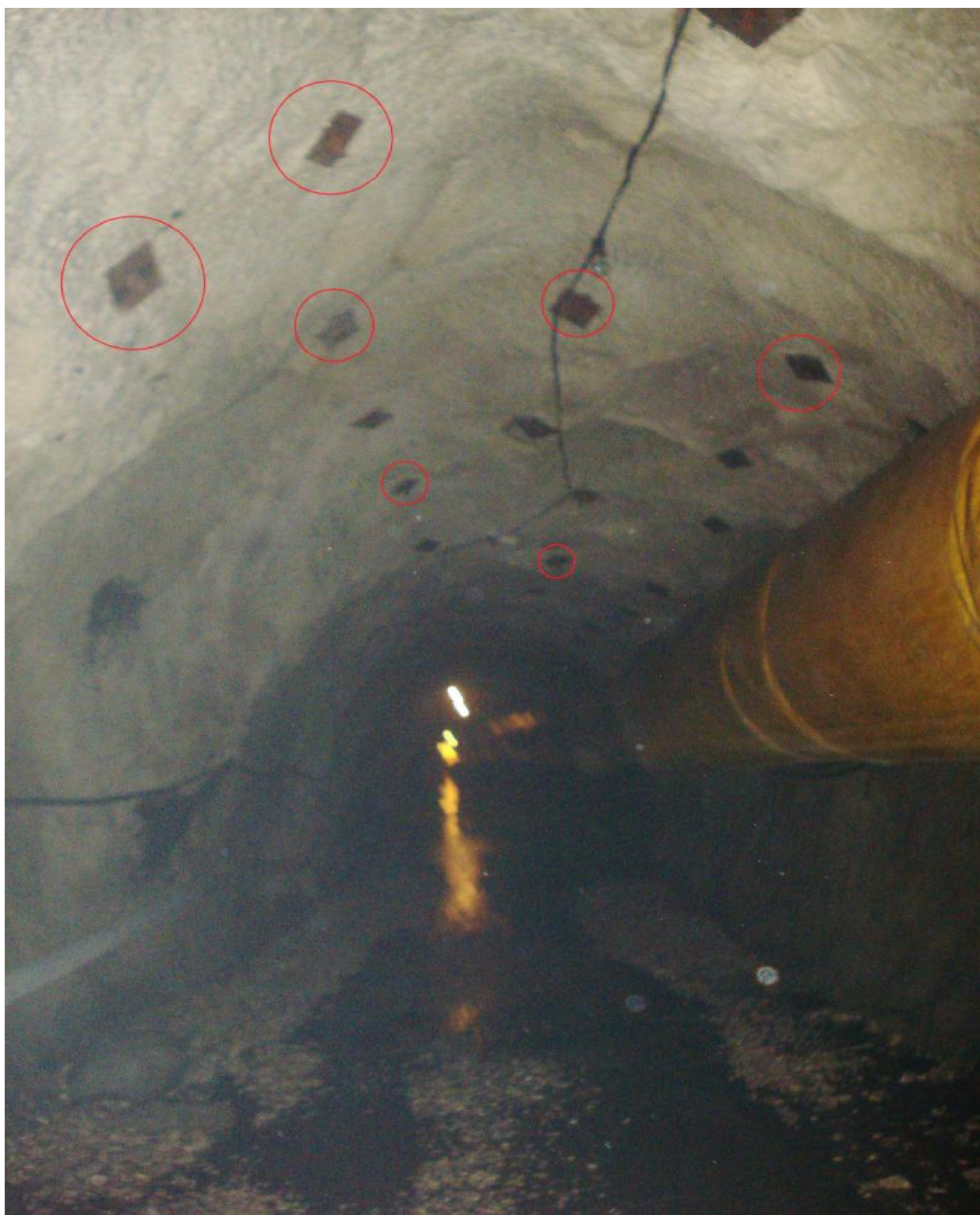
(Αγκύρια βράχου όπως φαίνονται στους κόκκινους κύκλους)
