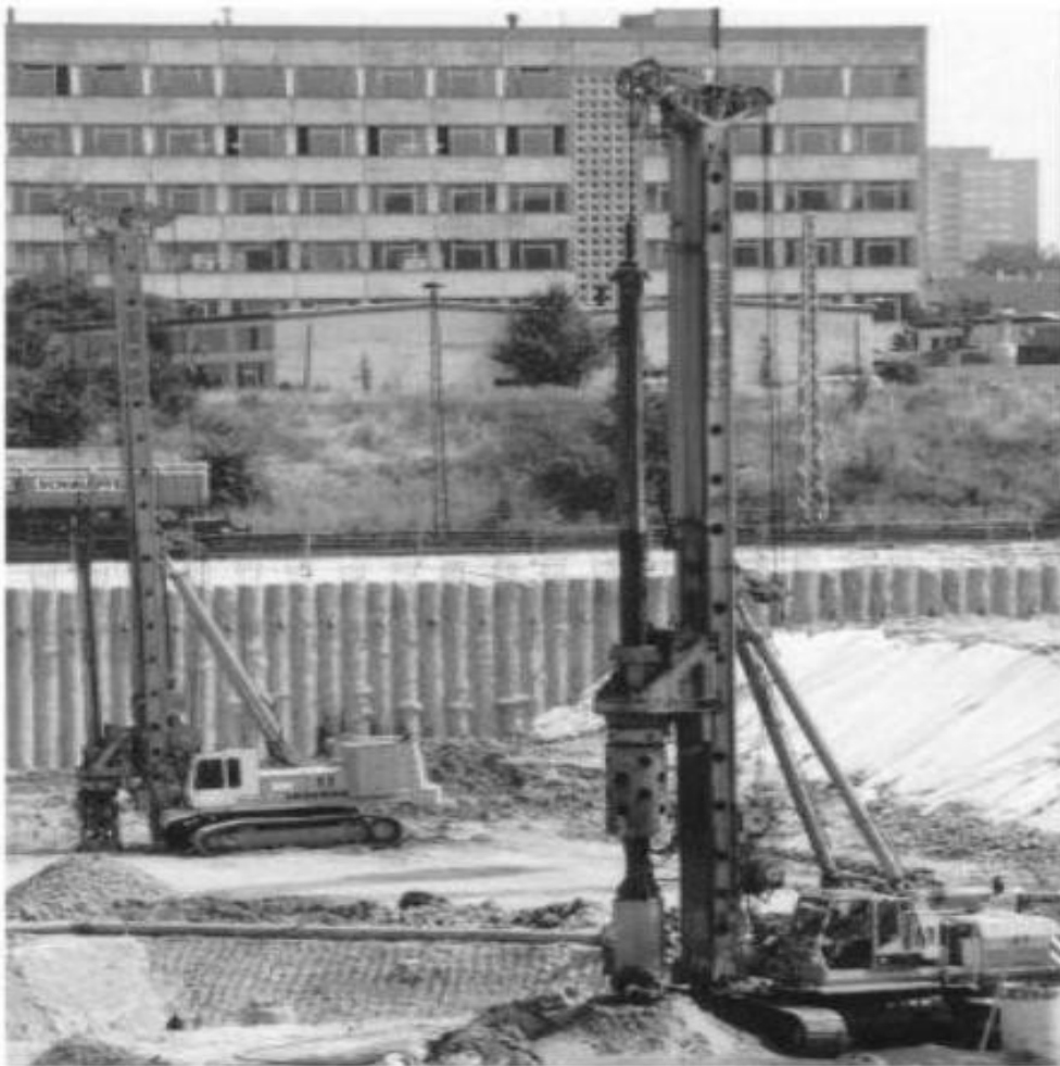
Εικόνα 3.16 Φωτογραφία εργοταξίου κατά τη φάση κατασκευής έγχυτων πασσάλων [1].
