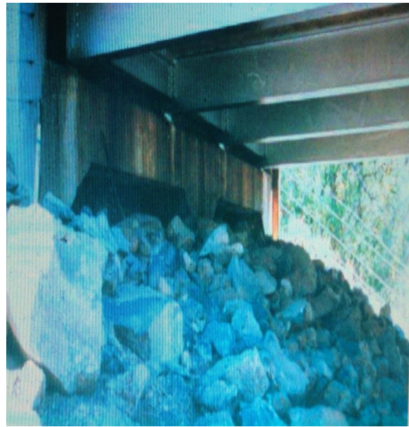
Εικόνα 3.20 ανοιχτό ακρόβαθρο
