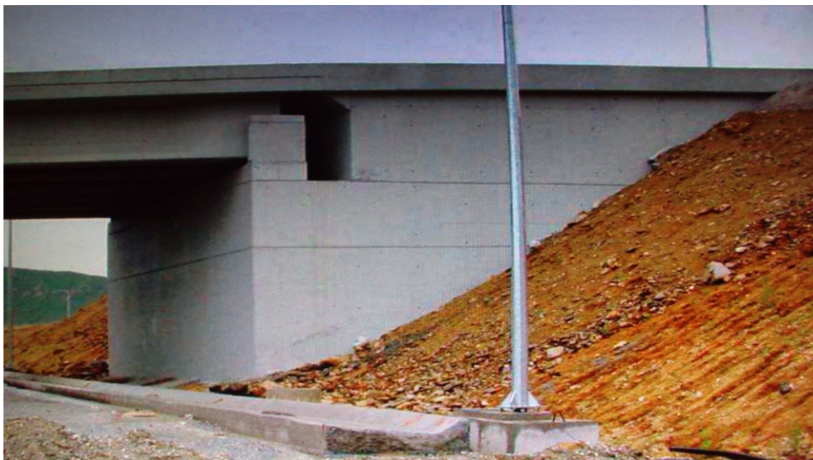
Εικόνα 3.18 κιβωτιόσχημο ακρόβαθρο
