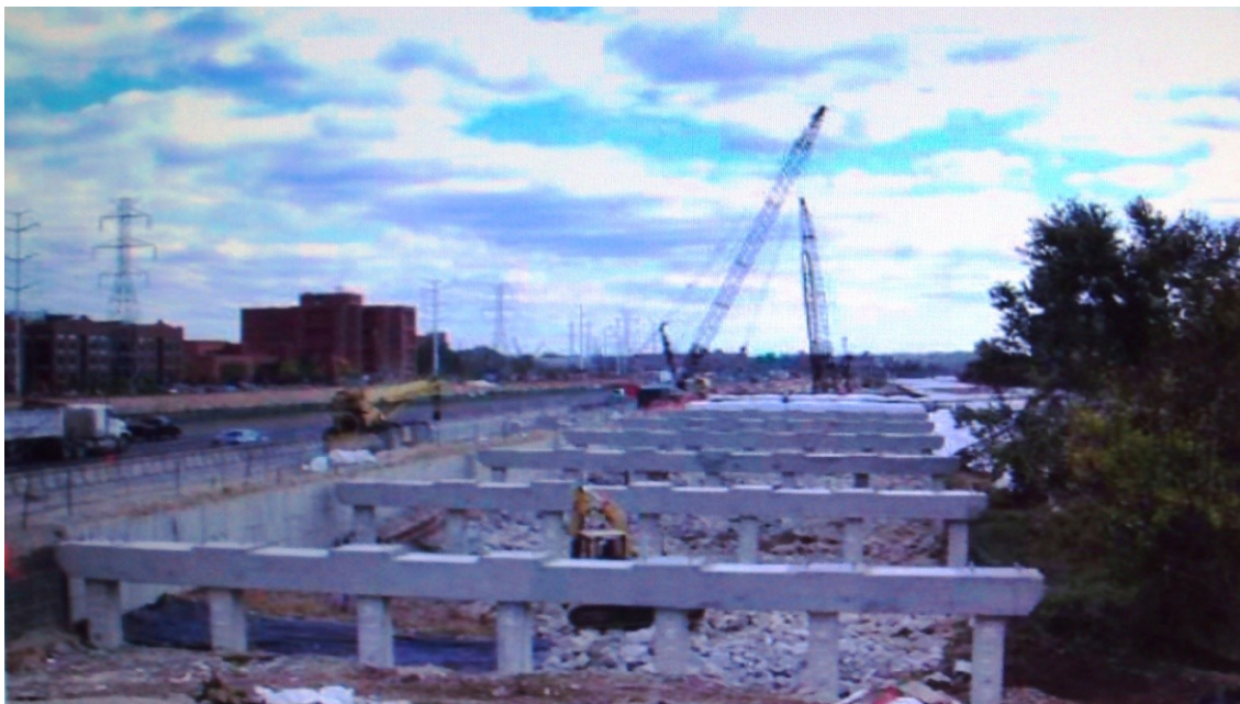
Εικόνα 3.22 μεσόβαθρο – πολύστηλο πλαίσιο
