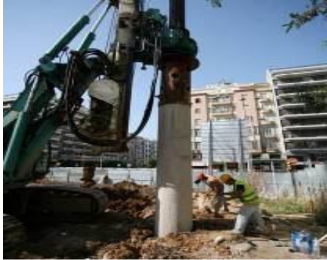
Εικόνα 3.7 Διάτρηση και τοποθέτηση υποστύλωματος κατά την μέθοδο επικάλυψης-εκσκαφής
