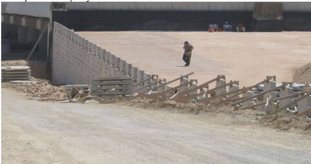
Εικόνα 3.1 Τοίχος οπλισμένου εδάφους.
