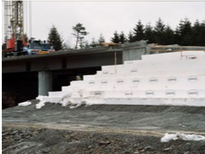
Εικόνα 3.8 Μεταβατικά επιχώματα EPS.
