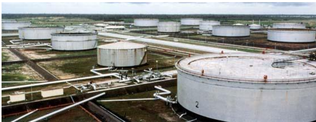
Εικόνα 15. Καθοδική προστασία σε βιομηχανικό χώρο [7].
