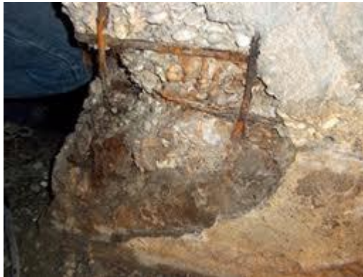
Εικόνα 1. Σκυρόδεμα προσβεβλημένο από χλωριόντα.
