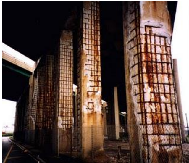
Εικόνα 2. Διάβρωση οπλισμών.
