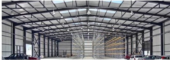
Εικόνα 12. Επιχρίσματα στον χάλυβα.
