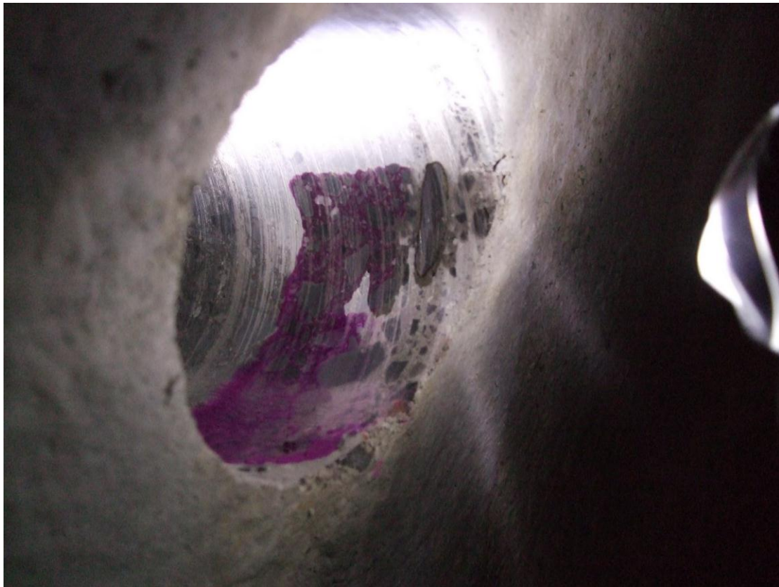
Εικόνα3. Προσδιορισμός βάθους ενανθράκωσης σε πυρήνα σκυροδέματος.
