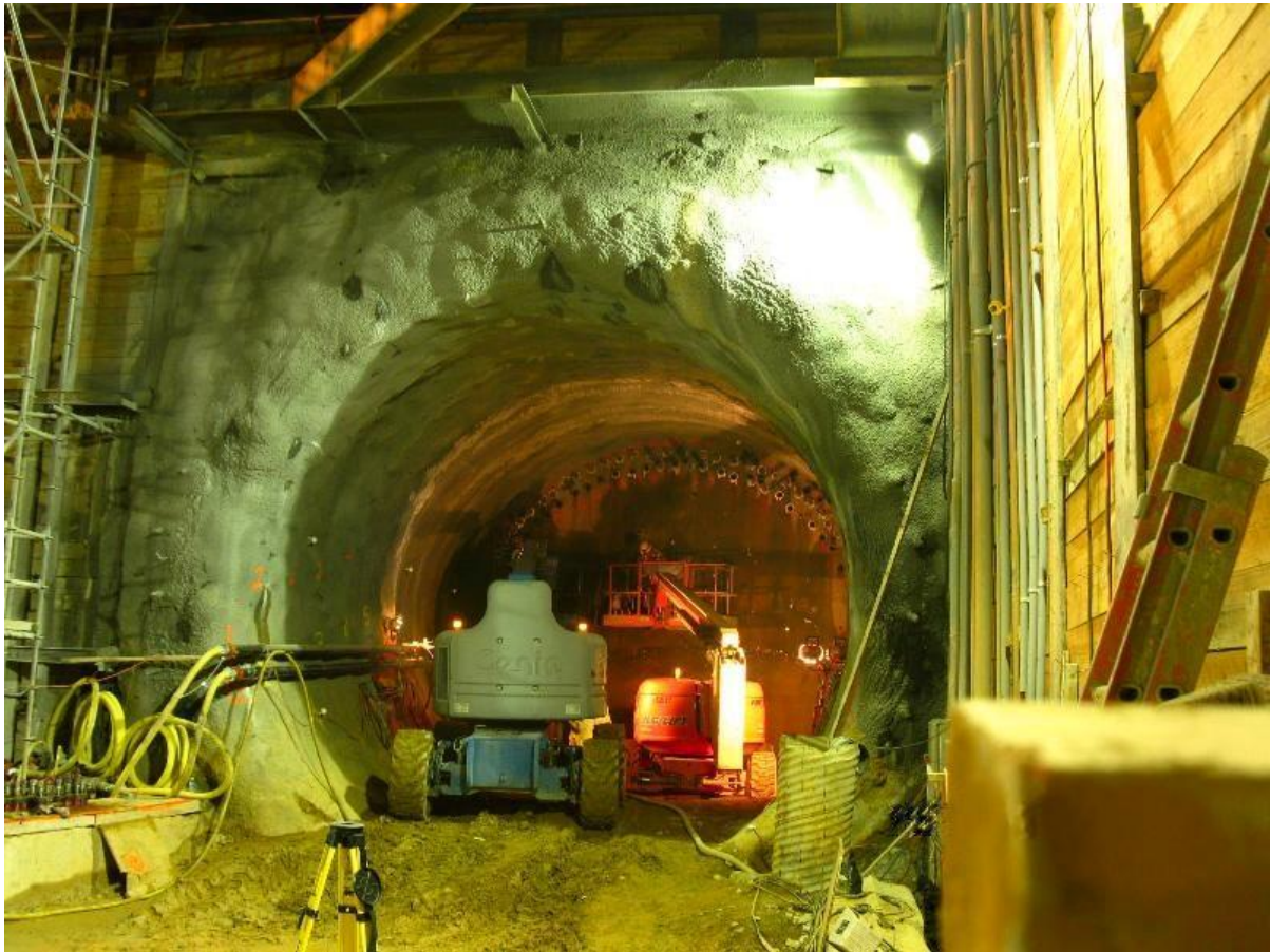
Εικόνα 18. Διάνοιξη σήραγγας με την μέθοδο NATM. Με την μέθοδο αυτή η εκσκαφή της σήραγγας γίνεται με συμβατικά μηχανικά μέσα. Η επένδυση γίνεται με εκτοξευόμενο σκυρόδεμα. Μπορούμε να διακρίνουμε τους δοκούς προπορείας στο θόλο της σήραγγας
