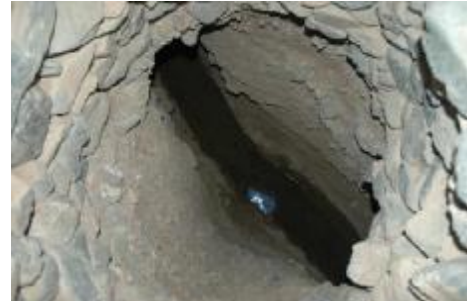
Εικόνα 5. Κοιτώντας από πάνω ένα φρεάτιο ενός qanat διακρίνουμε τη ροή του νερού μέσα στη σήραγγα.
