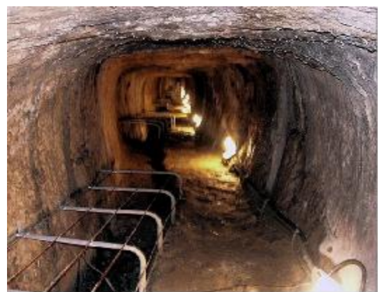
Εικόνα 7. Εσωτερικό Ευπαλίνειας σήραγγας
