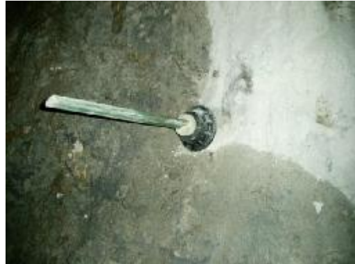
Εικόνα 25. Αγκύριο fiberglass σε στρώμα εκτοξευόμενου σκυροδέματος
