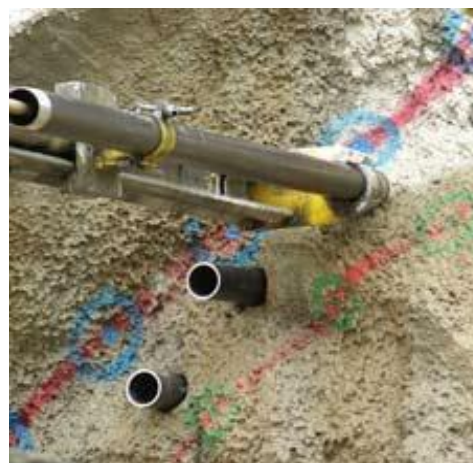
Εικόνα 23. Δοκοί προπορείας οι οποίοι τοποθετούνται με τη μέθοδο pipe-jacking
