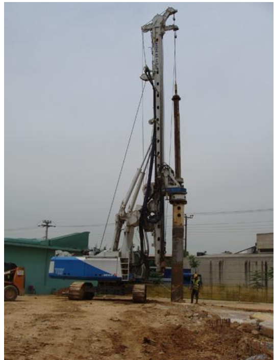
Εικόνα 38. Μηχάνημα διάνοιξης φρεατοπασσάλων
