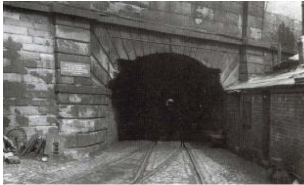
Εικόνα 12. Νότιο άκρο του Crown Street Tunnel
