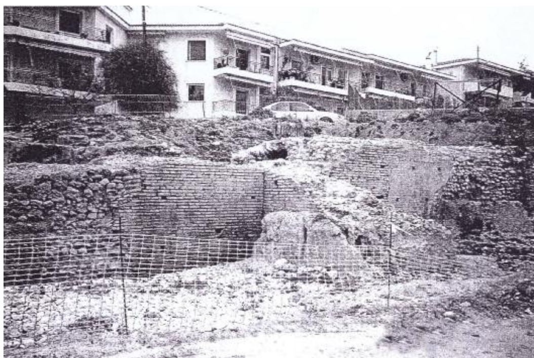
Εικόνα 27. Το υδραγωγείο και οι σωζόμενοι τοίχοι, ο διαμήκης και ο εγκάρσιος (με έντονη πλήρη αποκόλληση)
