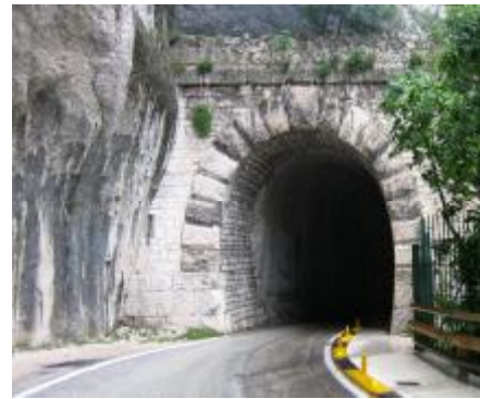
Εικόνα 9. Εξοδος της σήραγγας στο πέρασμα Furlo
