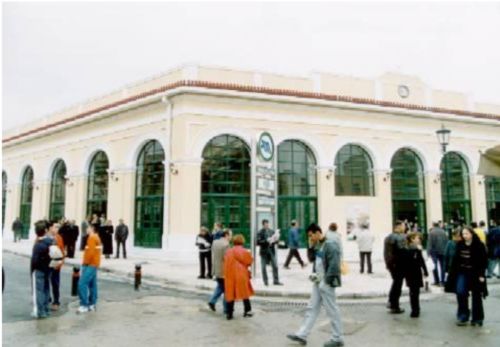
Φωτογραφία 145 Το εξωτερικό του σταθμού στο Μοναστηράκι .
