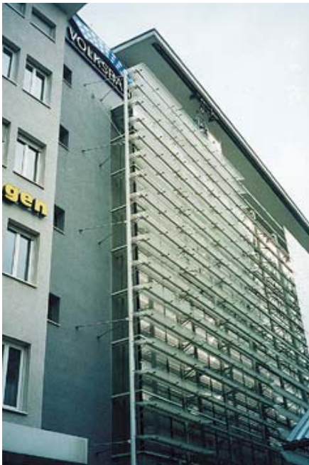
Εικόνα 15 : σκίαστρα σε όψη
