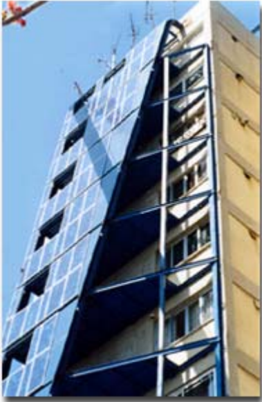
Εικόνα 17: φωτοβολταϊκά στην πρόσοψη
