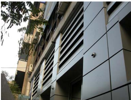
Εικόνα 14 : σκίαστρα σε όψη
