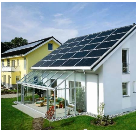
Εικόνα 18 : φωτοβολταϊκά στη στέγη
