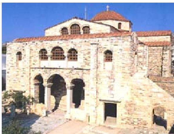
Εικόνα 2 - 3 Η εκκλησία της Καταπολιανής, στην Πάρο (6ος αιώνας)
