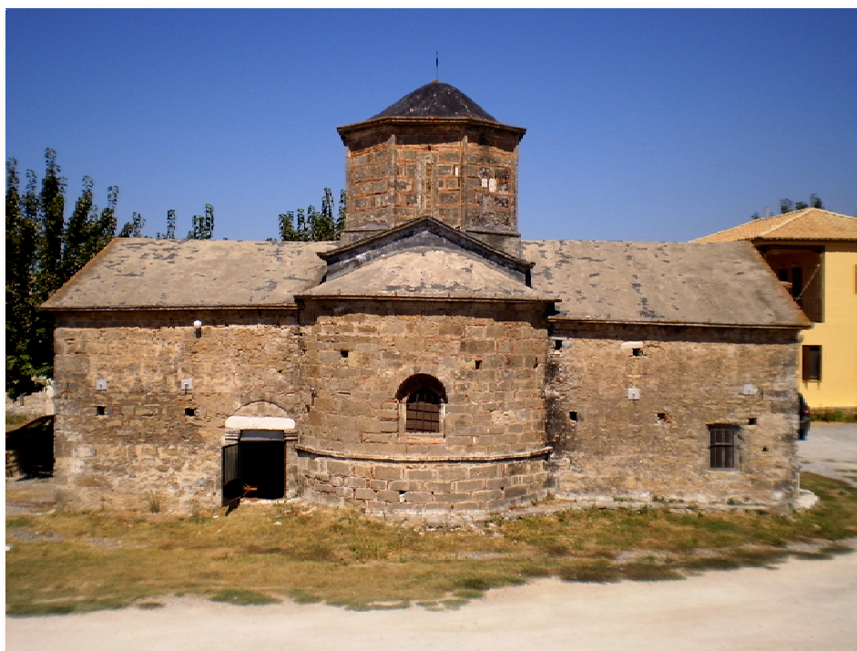
Εικόνα 3 - 3 Νότια όψη του ναού
