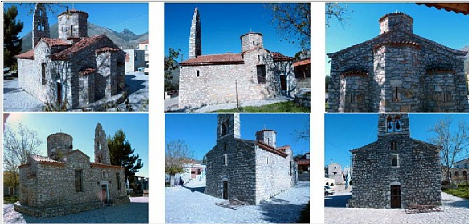
Εικόνα 4 - 5 Φωτογραμμετρικές λήψεις για την εφαρμογή συγκλίνουσας μη στερεοσκοπικής επεξεργασίας
