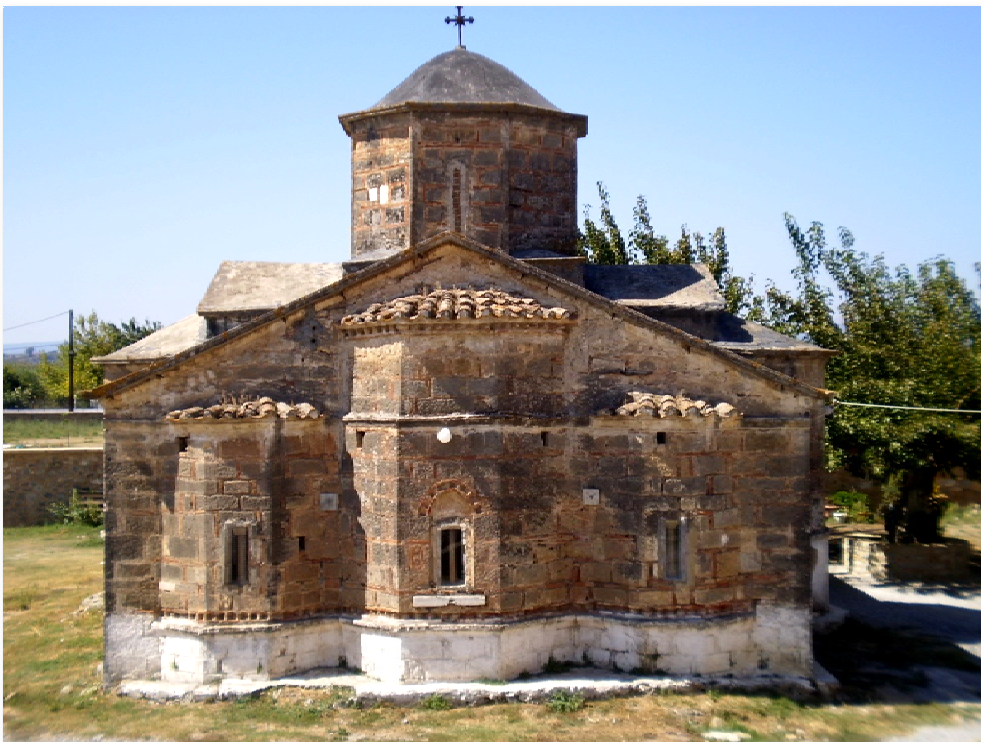
Εικόνα 3 - 1 Ανατολική άποψη του ναού
