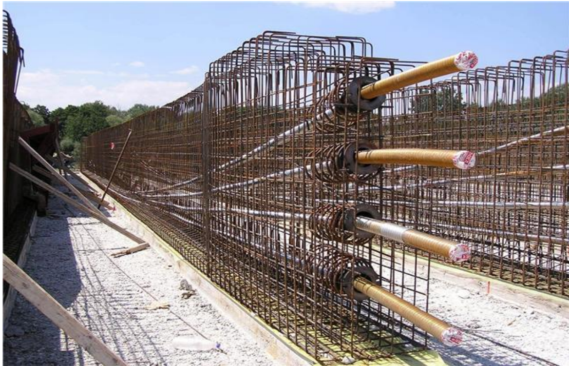
Εικόνα 7: Τοποθέτηση χάλυβα προέντασης με τη μέθοδο εσωτερικής προέντασης μέσω τεθλασμένου χάλυβα .
