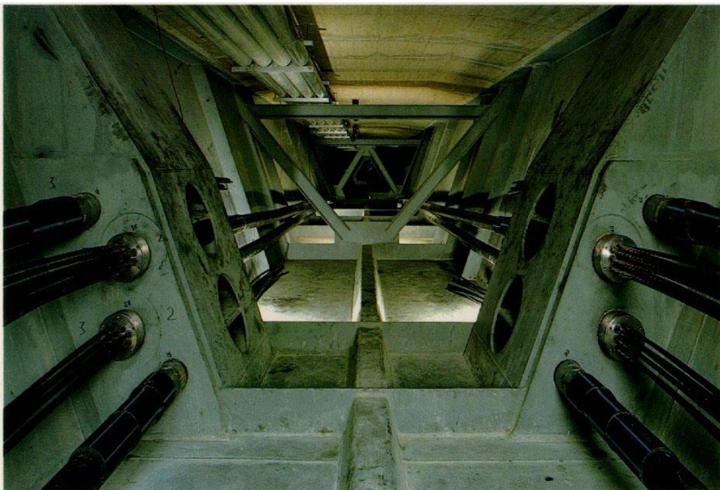
Εικόνα 14: Εφαρμογή ευθύγραμμης προέντασης σε γέφυρα.
