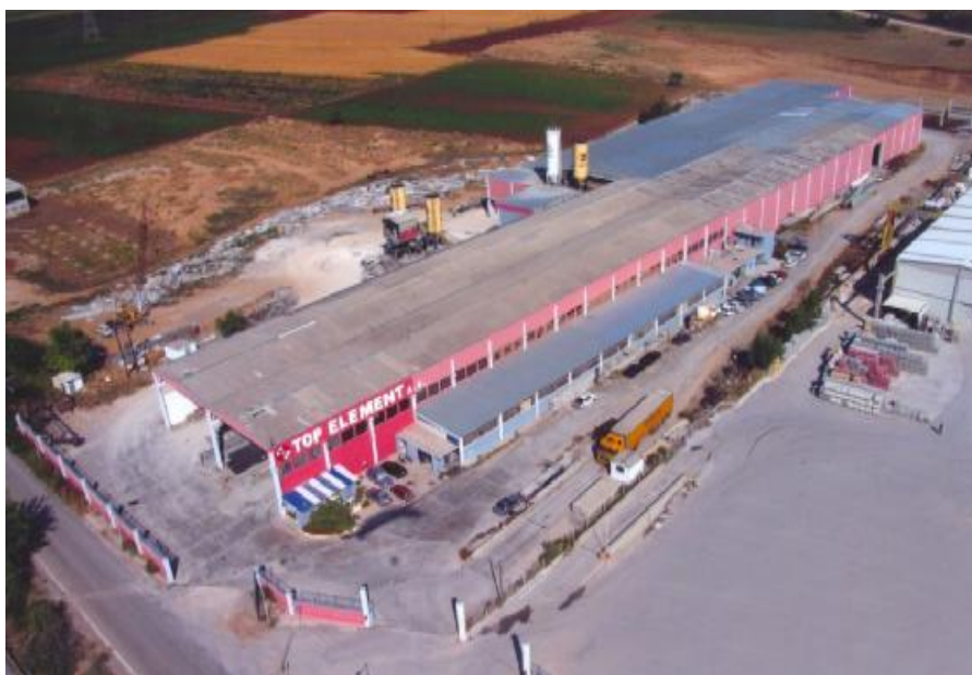
Εικόνα 2.1 : Το εργοστάσιο παραγωγής προεντεταμένων προκατασκευασμένων στοιχείων της εταιρείας Top Element στο 71 ο χιλιόμετρο Αθηνών - Λαμίας
