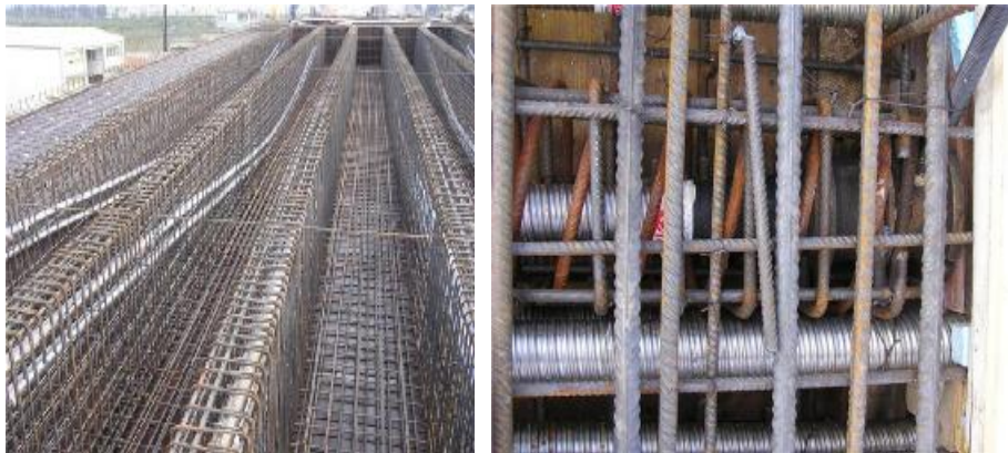
Εικόνα 8 : Τοποθετημένος χαλαρός οπλισμός και οπλισμός προέντασης σε πλακοδοκό γέφυρας
