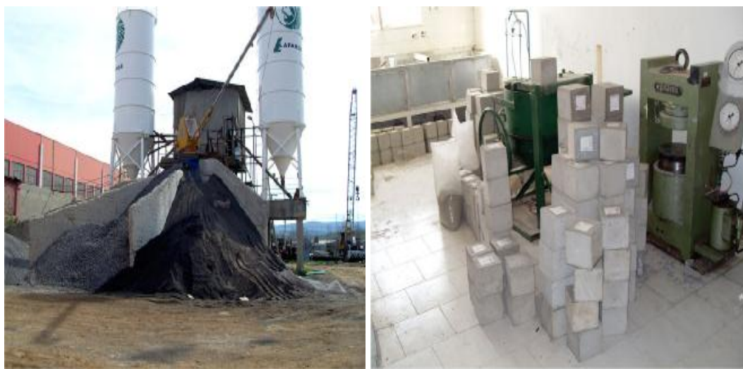
Εικόνα 18 : Μονάδα παραγωγής σκυροδέματος – Εργαστήριο ποιοτικού ελέγχου
