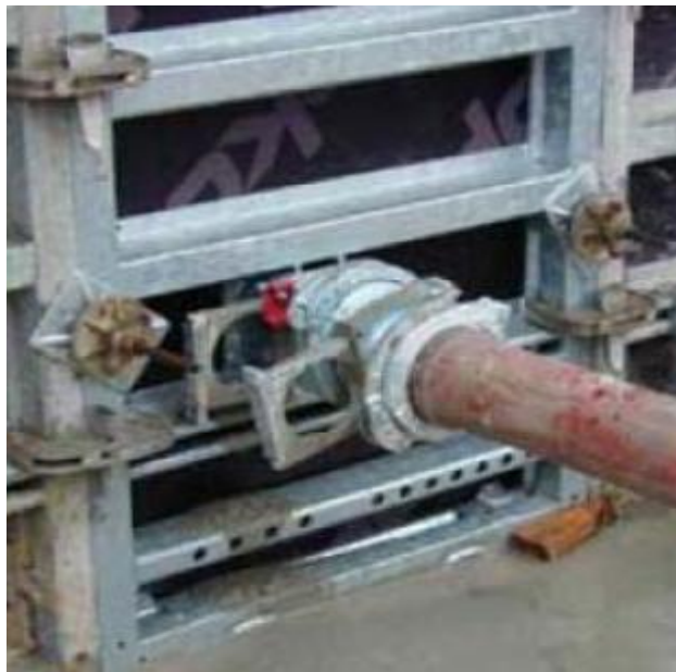
Εικ.4.2 - Λεπτομέρεια σκυροδέτησης μέσω εισπίεσης
