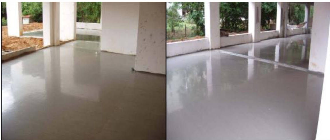
Φωτογραφία 11.16-11.17. Σκυροδέτηση δαπέδου πυλωτής
