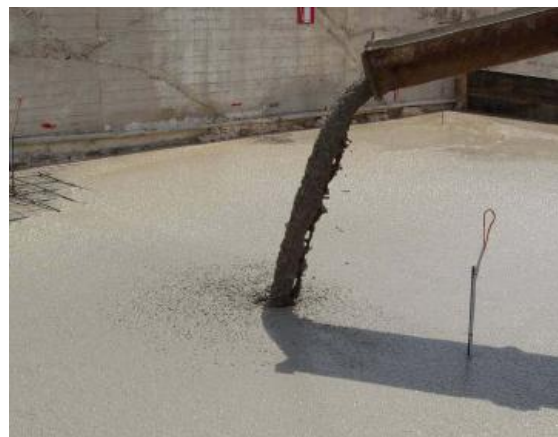
Φωτογραφία 11.13. Βάση γεφυροπλάστιγγας ( εδαφόπλακα )
