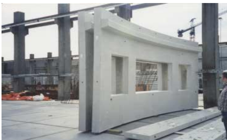
Φωτογραφία 11.6. Προκατασκευασμένο στοιχείο από Αυτοσυμπυκνούμενο Σκυρόδεμα
