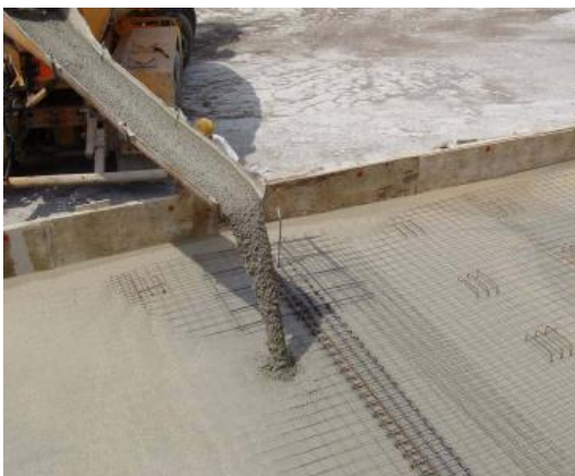
Φωτογραφία 11.13. Βάση γεφυροπλάστιγγας ( εδαφόπλακα )
