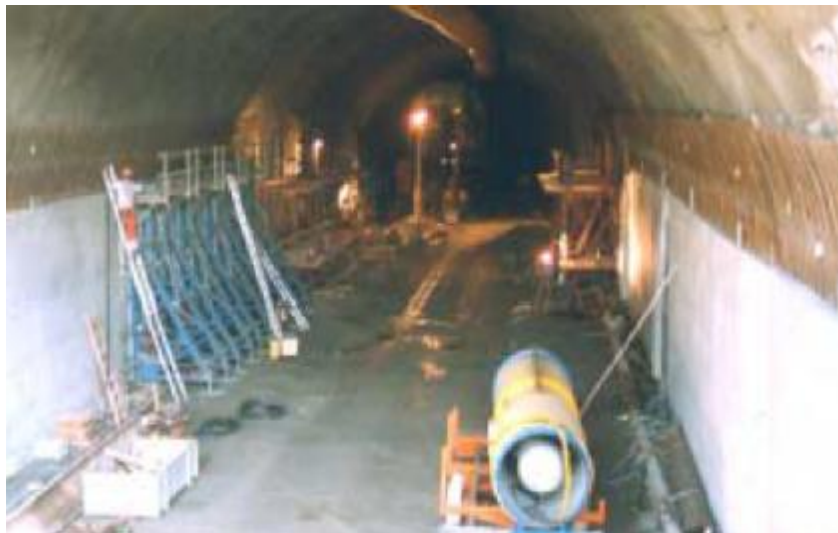
Φωτογραφία 11.4. Επένδυση σήραγγας με προκατασκευασμένους τομείς από Αυτοσυμπυκνούμενο Σκυρόδεμα
