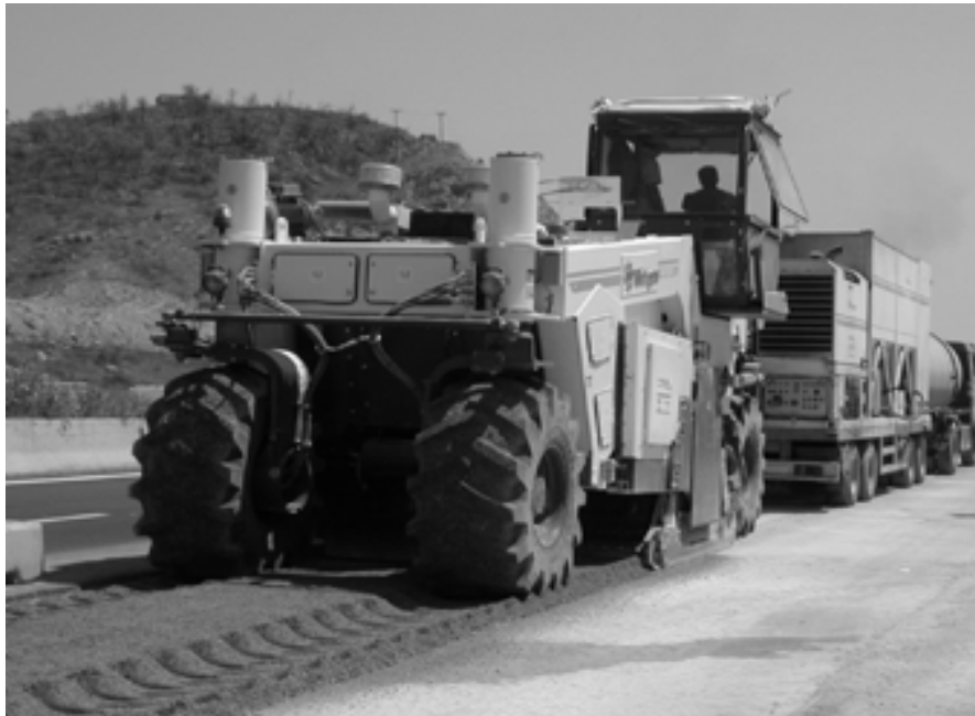
Εικόνα 17: Εφαρμογή τεχνικής ψυχρής ανακύκλωσης με αφρώδη άσφαλτο
