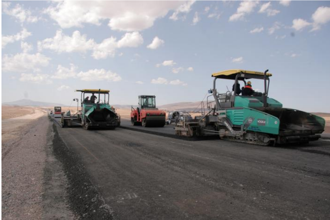
Εικ. 6: Επίστρωση οδοστρώματος με ασφαλτικό υλικό
