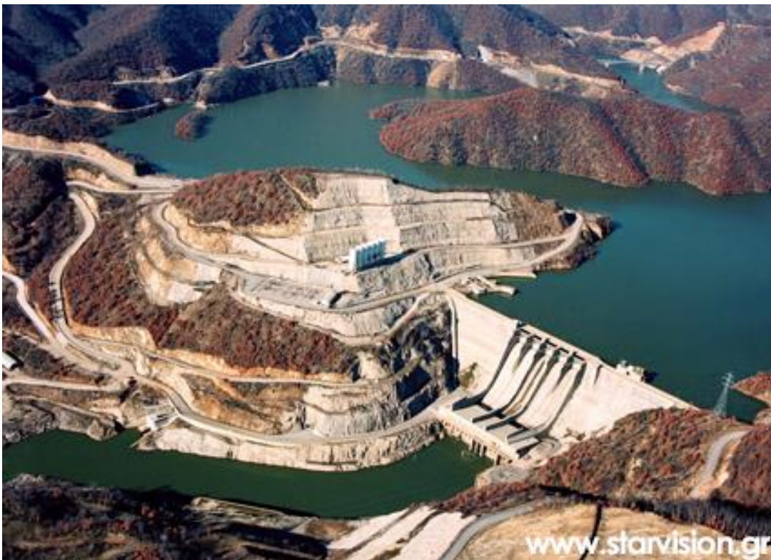
Εικόνες 24 : Φράγμα Πλατανόβρυσης ποταμού Νέστου.
