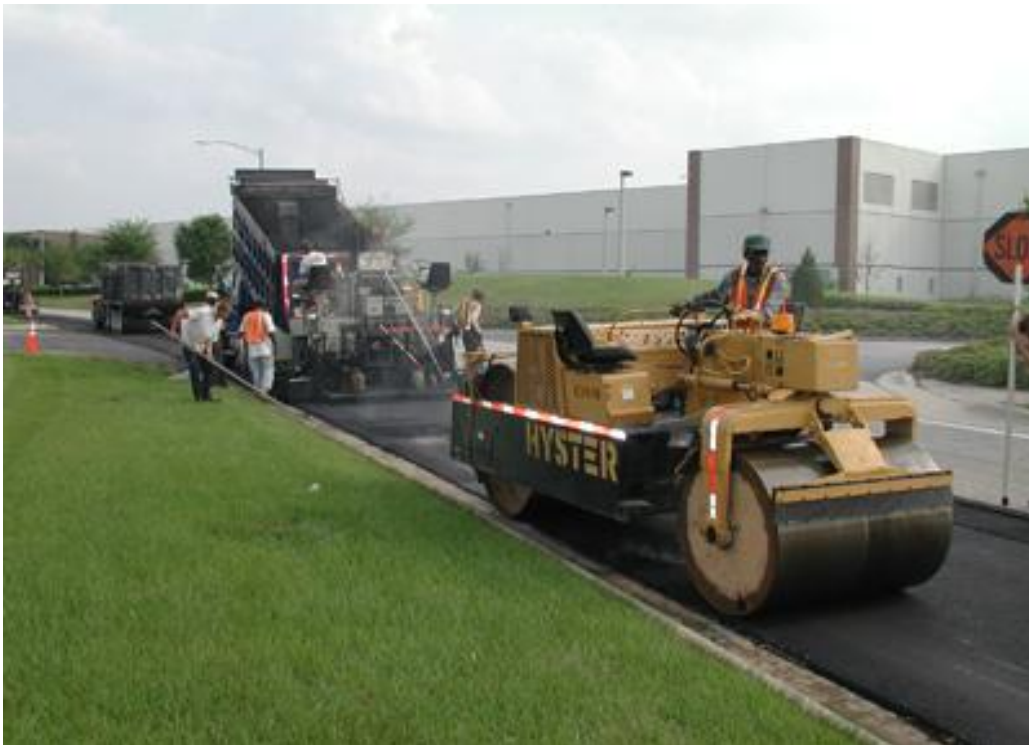
Εικ. 20: Διεργασίες κατά την ανακύκλωση του οδοστρώματος
