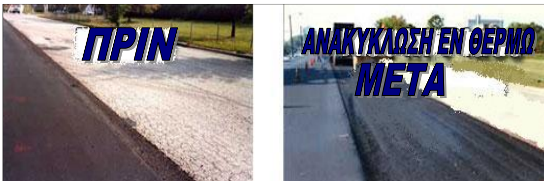
Εικ.7: Πρίν και μετά την εφαρμογή της εν -θερμώ ανακύκλωσης
