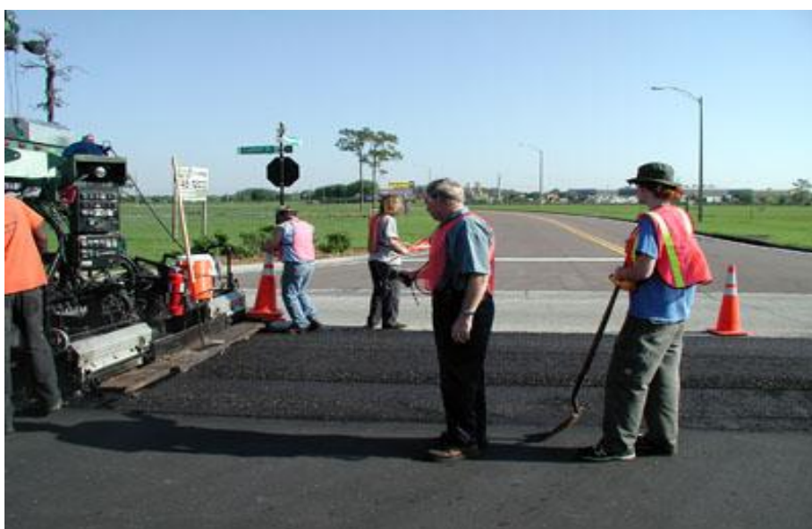
Εικ 9: Επαναδιάστρωση παλαιού οδοστρώματος με νέο ασφαλτικό υλικό (REPAIRE)
