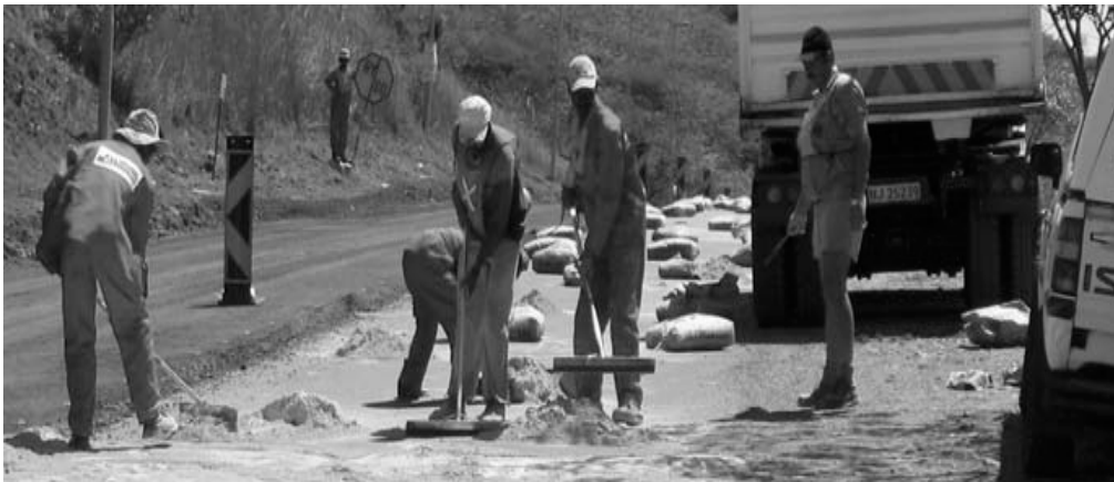
Εικ. 23: Εργασίες επί του οδοστρώματος
