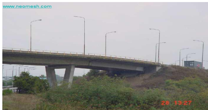
Επιθεώρηση για στρωφική μετακίνηση ακροβάθρου
