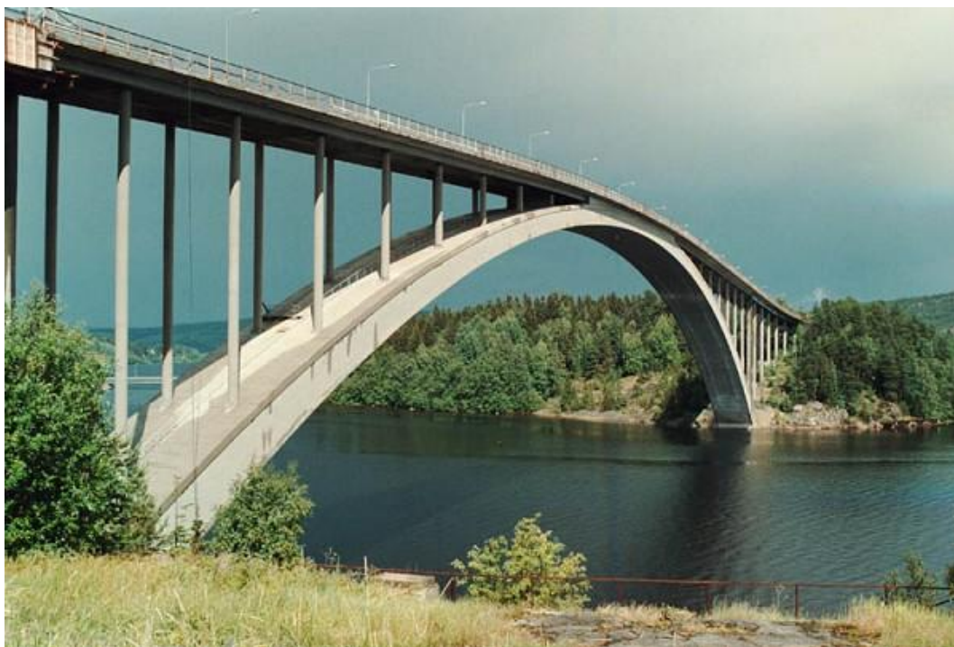
Εικ.1.11 Γέφυρα του Sando στη Σουηδία που κατασκευάστηκε μεταξύ 1941-1945 έχει άνοιγμα τόξου 280.00 m.
