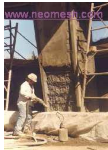
Αποκατάσταση διαβρωμένου σκυροδέματος σε μεσόβαθρα με την βοήθεια εκτοξευμένων κονιαμάτων
