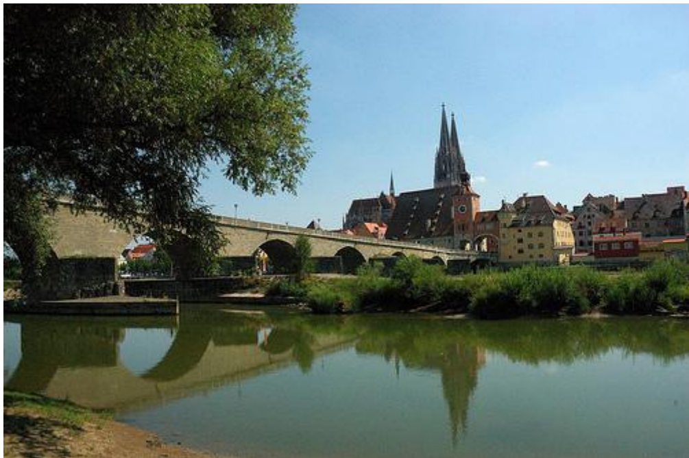
Εικ.1.6 Γέφυρα του Δούναβη στο Regensburg
