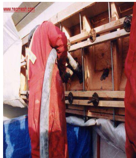
Επανασκυροδέτηση δοκού
