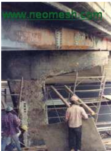
Αποκατάσταση διαβρωμένου σκυροδέματος σε μεσόβαθρα με την βοήθεια εκτοξευμένων κονιαμάτων
