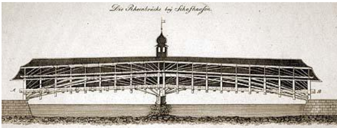
Εικ.1.1 Γέφυρα Ρήνου περιοχή Schaffhausen στην Ελβετία l=118.00 m, J. U. Grubenmann 1758.
