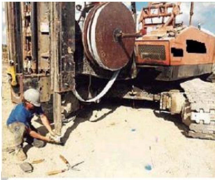
Σχ. 1.6 Εξοπλισμός τοποθέτησης κατακόρυφων στραγγιστηρίων.
