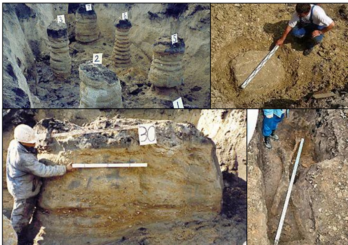
Σχήμα 2.13 Στήλες ενισχυμένου εδάφους (εδαφοπάσσαλοι)
