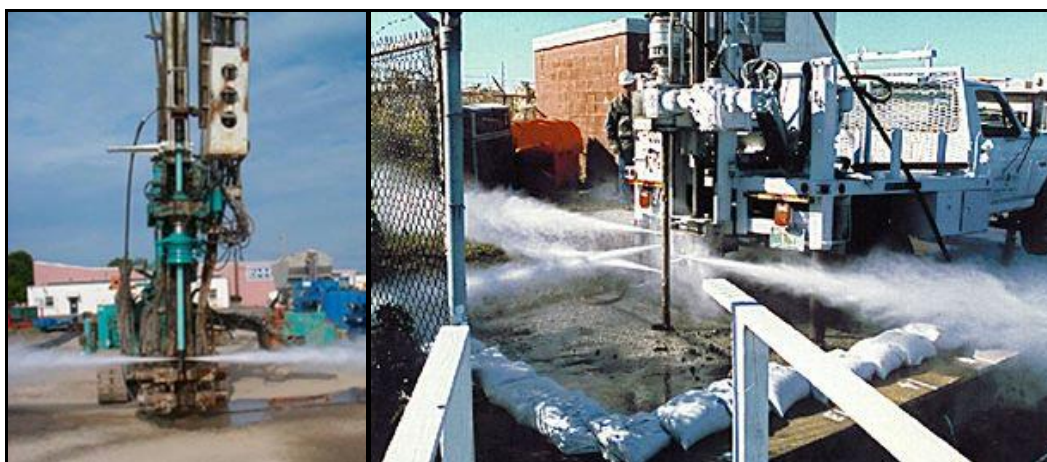
Σχήμα 4.11 Στέλεχος ενεμάτωσης με ακροφύσια υψηλής πίεσης
