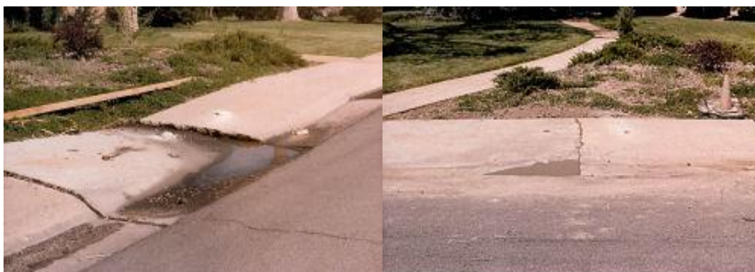
Σχήμα 2.6 Ανύψωση οδοστρώματος με ενέσεις συμπύκνωσης
