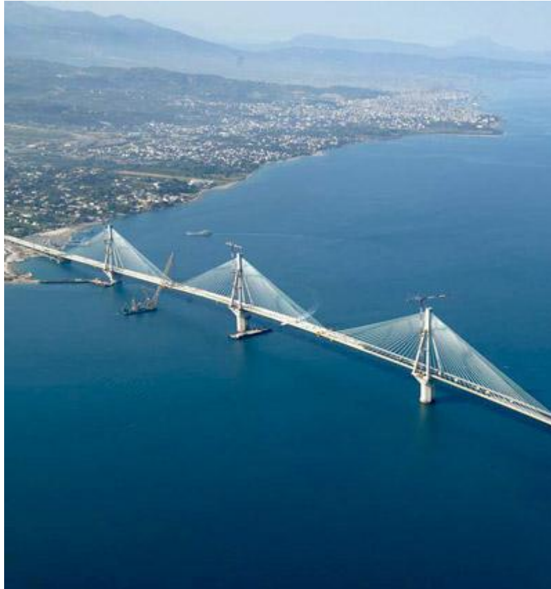
Εικ.6.11 Γέφυρα Ρίου-Αντιρρίου
