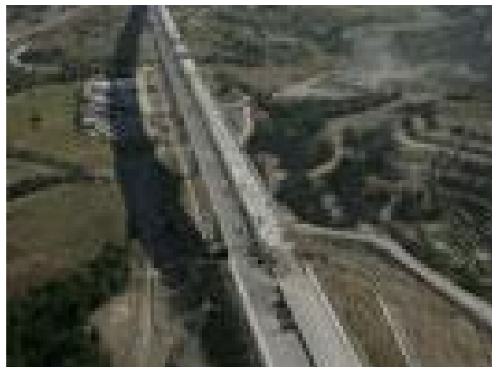
Εικ. 6.2 Εγνατία οδός, Γέφυρα Δυτ. Μακεδονίας
