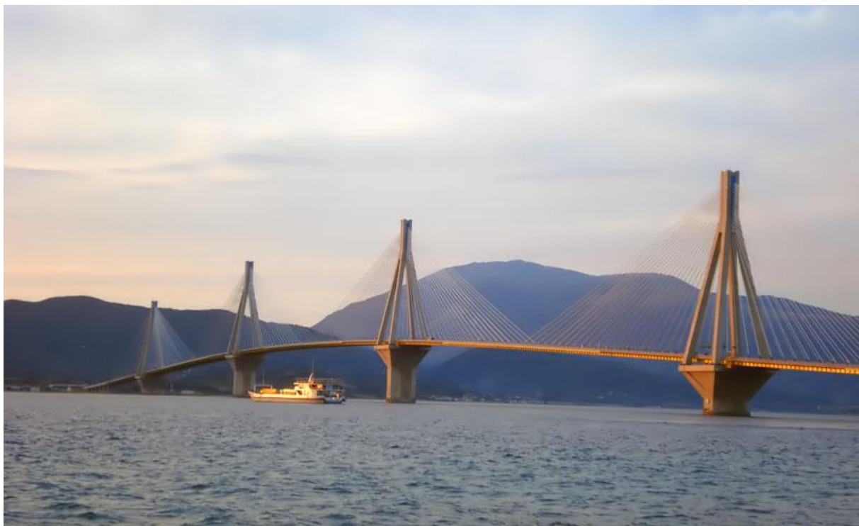
Εικ. 6.12 Γέφυρα Ρίου-Αντιρρίου
