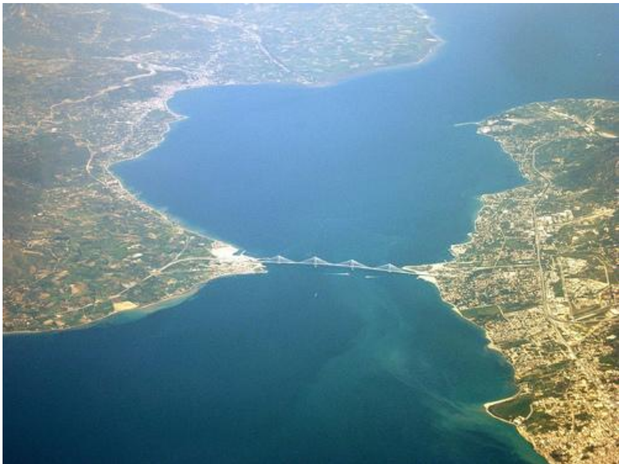
Εικ. 6.10 Ζεύξη Ρίου Αντιρρίου
