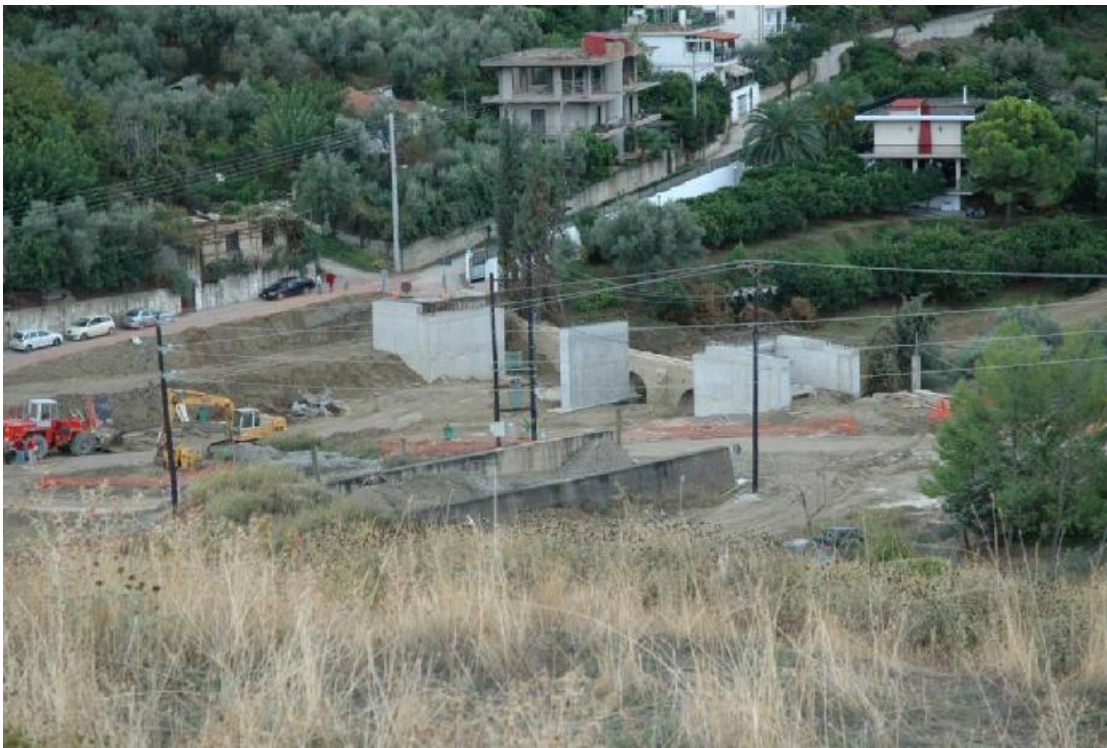
Σχήμα 4.2 Εργασίες αποκάλυψης και προστασίας αρχαιοτήτων
