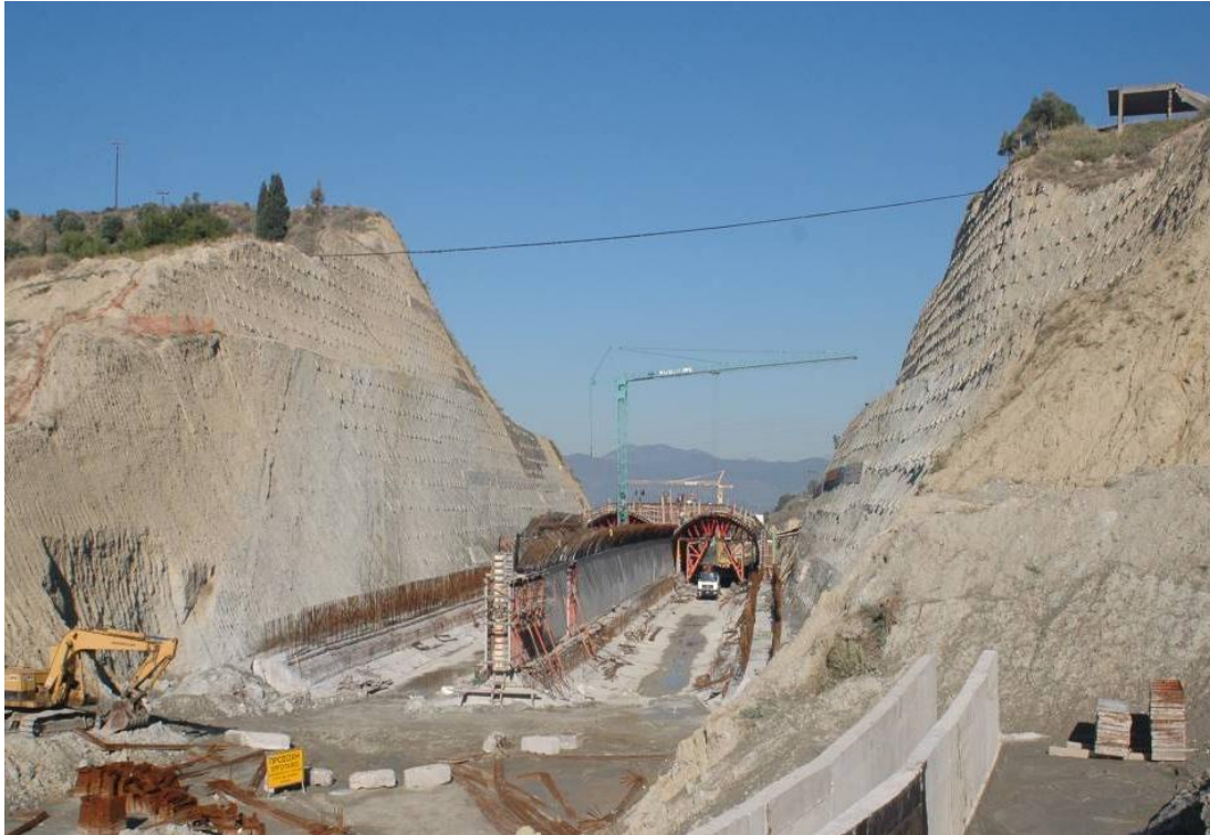
Σχήμα 1.2 Η εφαρμογή της μεθόδου cut & cover στο υπό εξέταση έργο (Μικρή περιμετρική οδό Πάτρας)
