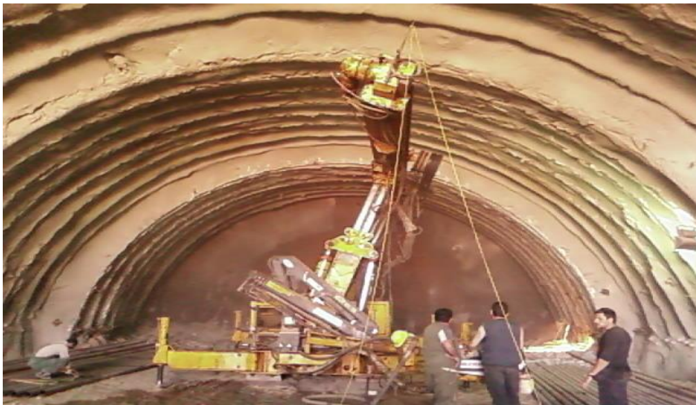
Σχήμα 1. 8 Κατασκευή σήραγγας με τη μέθοδο NATM
