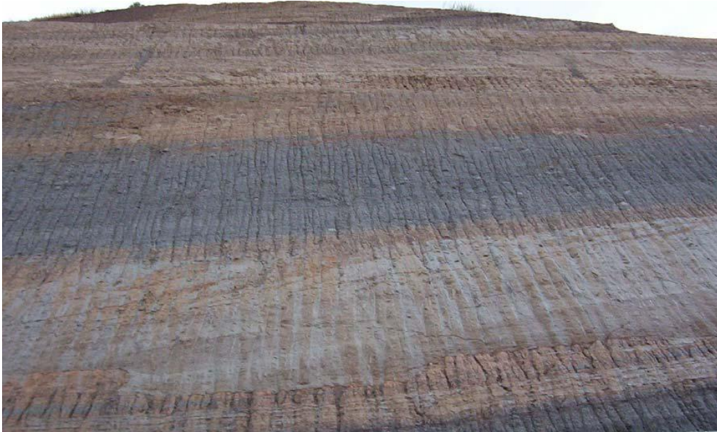
Σχήμα 3.19 Διακρίνεται ο ανώτερος μαργαϊκός ορίζοντας σε ανοικτή διατομή. Παρατηρούνται οι εναλλαγές καστανόχρωμων και γκρι στρωμάτων ιλυωδών αργίλων με μικρό ποσοστό άμμου. Εικόνα νότιου πρσανούς. Χ.Θ. 0+950Μ.Π.Π.
