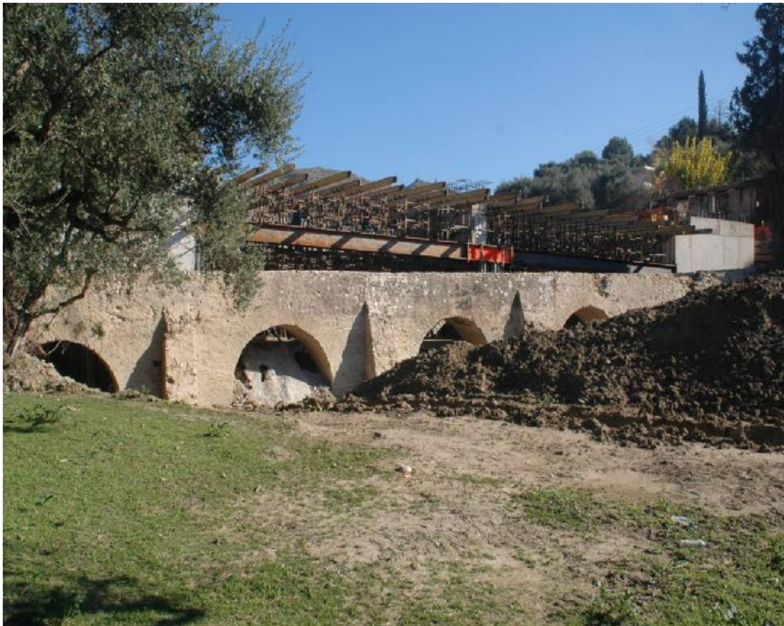
Σχήμα 2.2 Τμήμα του αρχαίου υδραγωγείου
