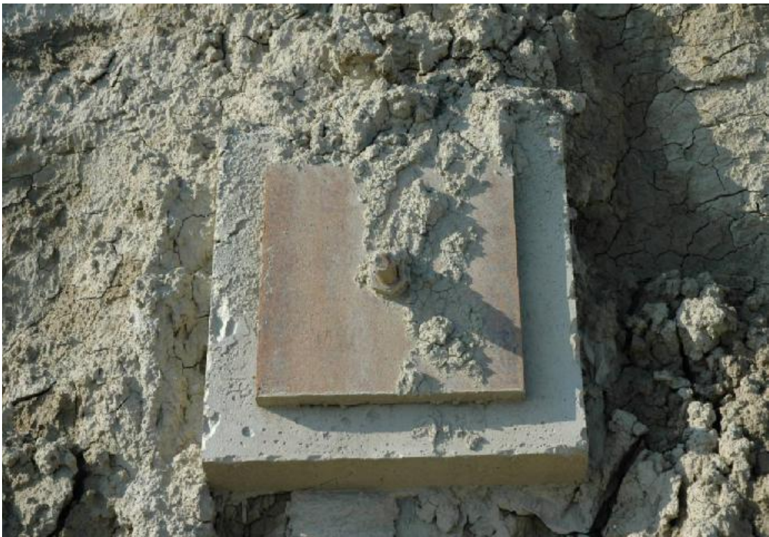
Σχήμα 4.5 α) Προεντεταμένα και β) Παθητικά αγκύρια
