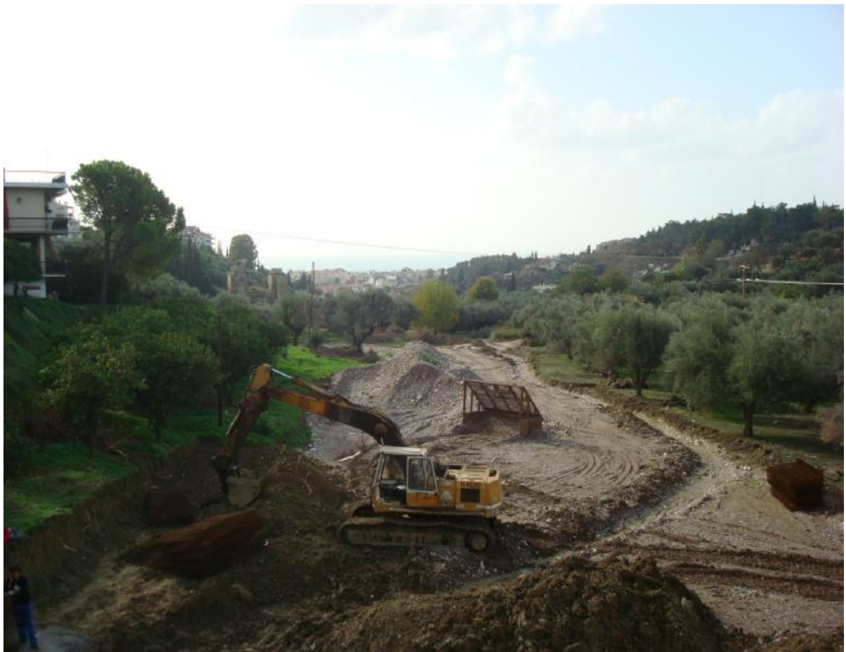
Χωματουργικές εργασίες διάνοιξης – εργολαβία ΑΚΑΜΑΣ
