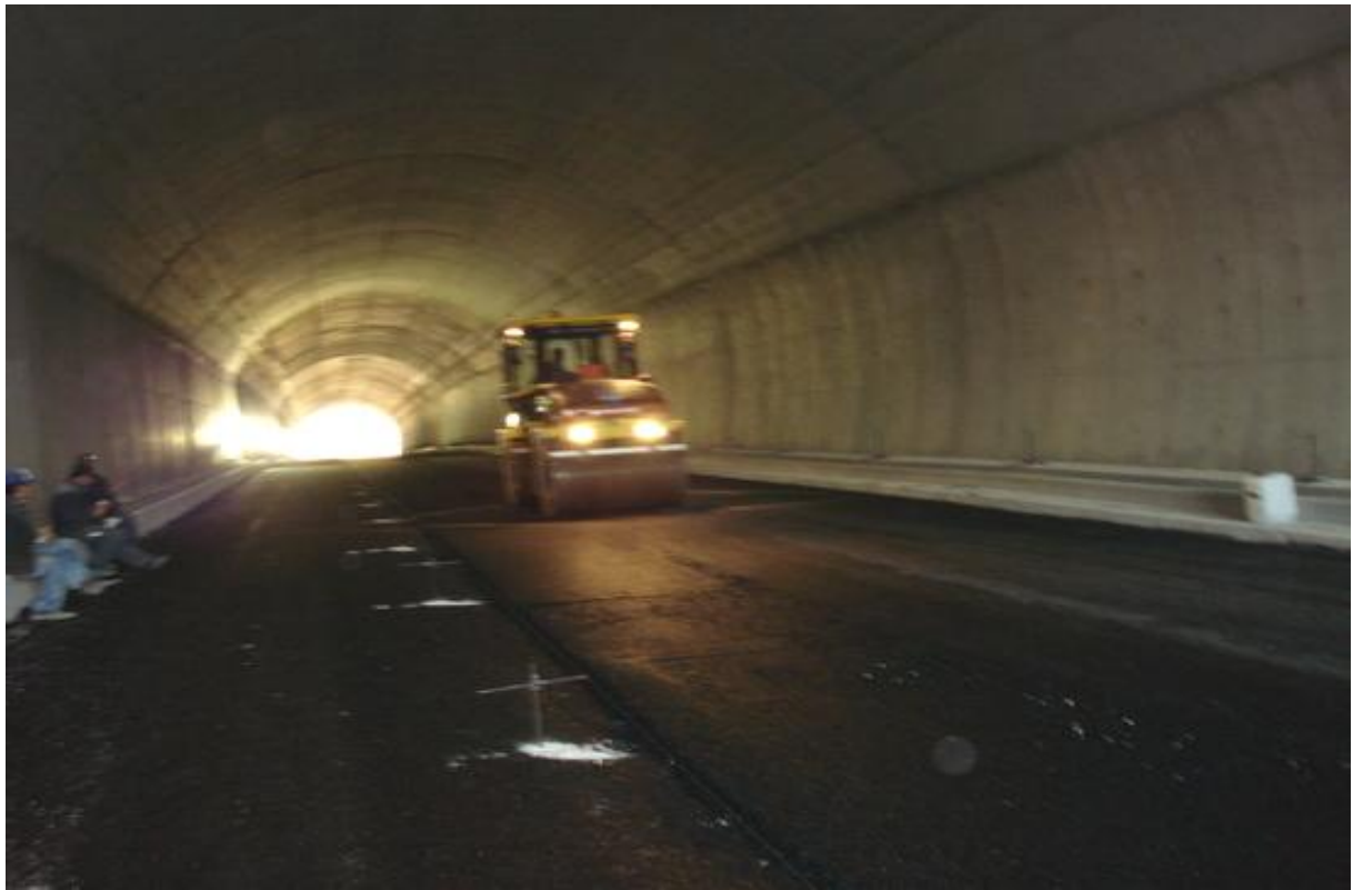
Ασφαλτόστρωση και οδοστρωσία σήραγγας (Εργολαβία Έδραση)
