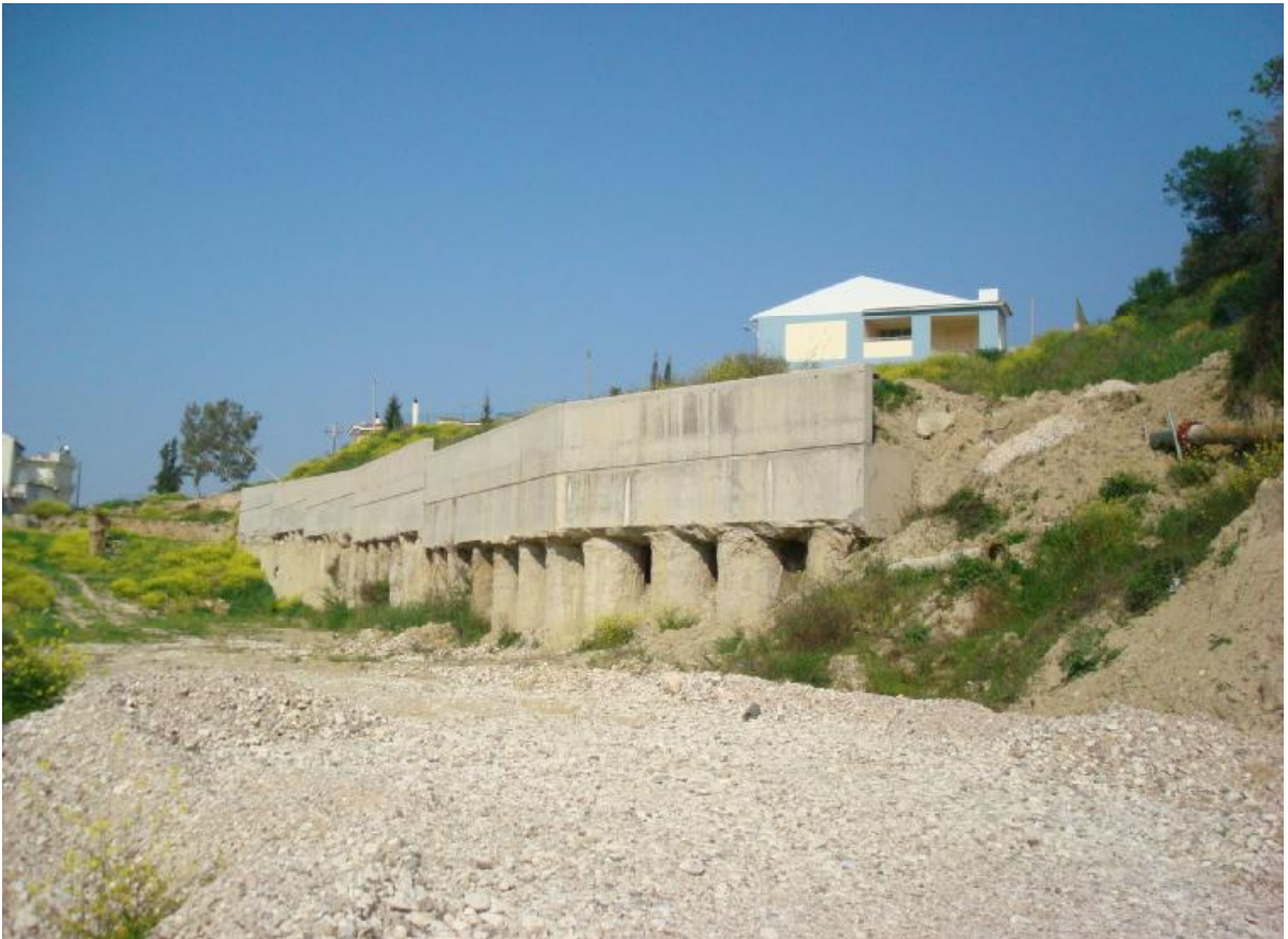
Τοίχος αντιστήριξης – πασσαλότοιχος
