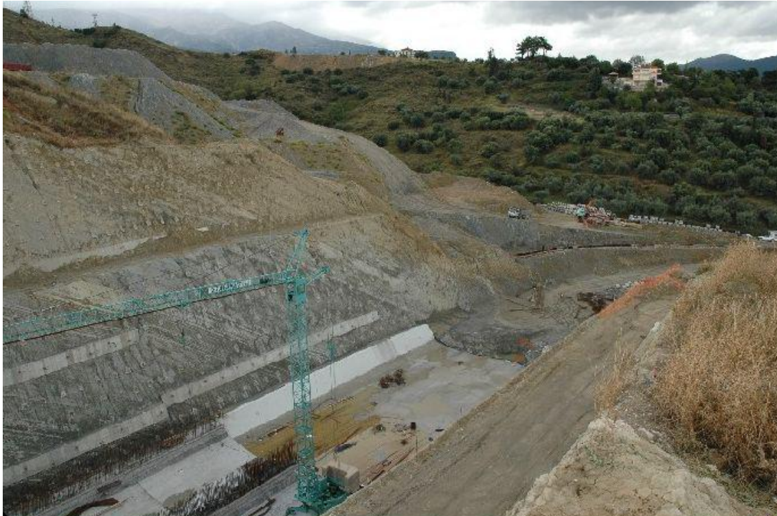
Εικόνα 4.7: Αρχική διάνοιξη της οδού
