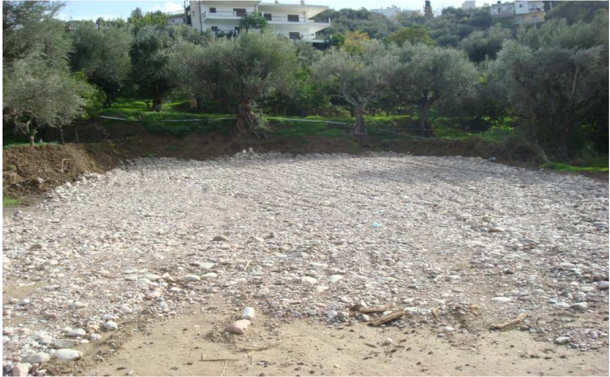
Εξομάλυνση επιφάνειας και διαμόρφωση του χώρου για να μεταφερθεί το μεσαιωνικό υδραγωγείο
