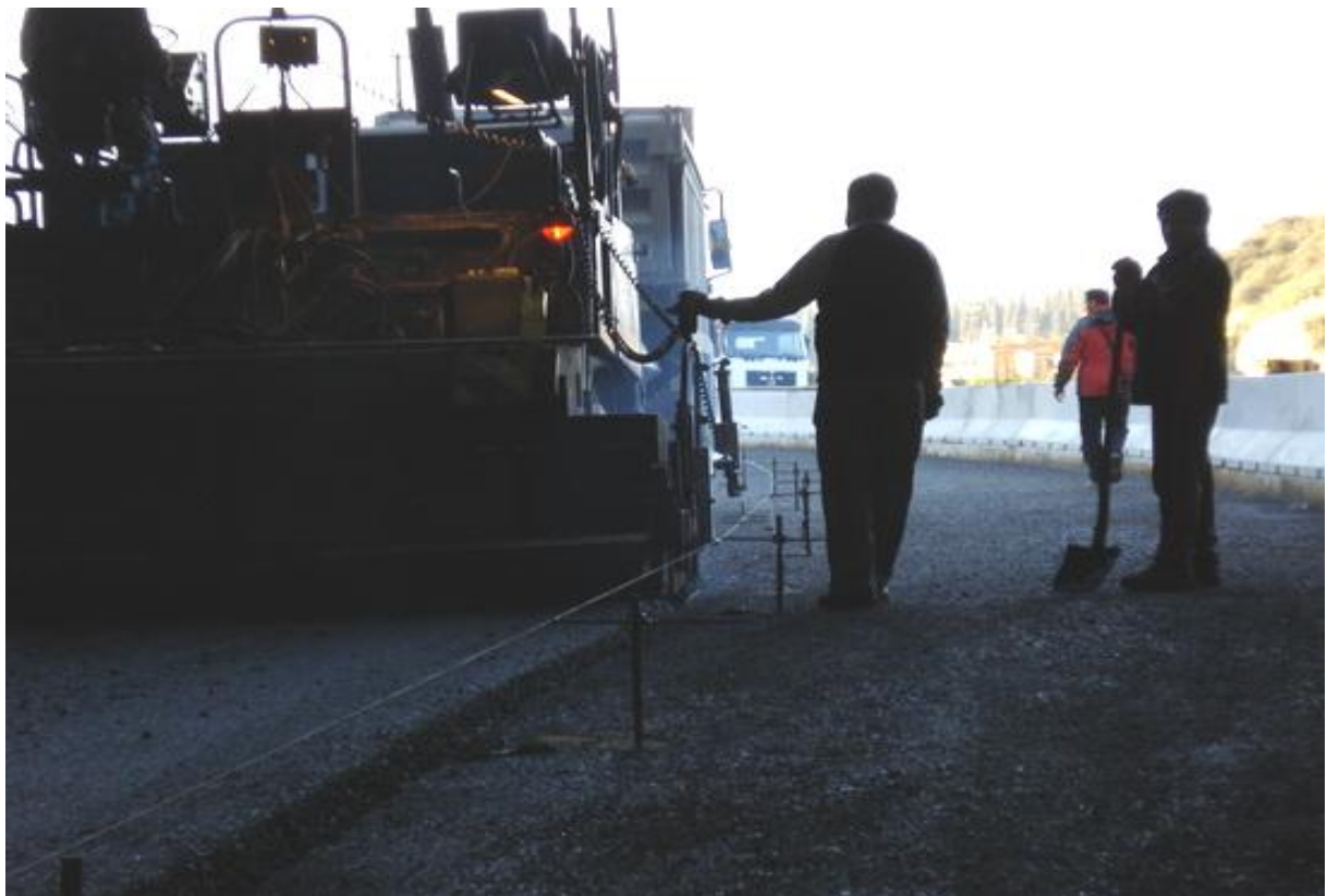
Ασφαλτόστρωση και οδοστρωσία σήραγγας (Εργολαβία Έδραση)
