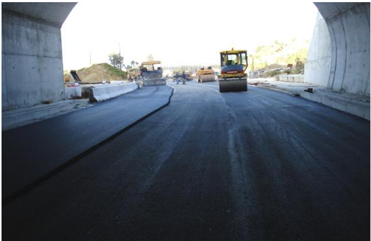
Ασφαλτόστρωση και οδοστρωσία σήραγγας (Εργολαβία Έδραση)
