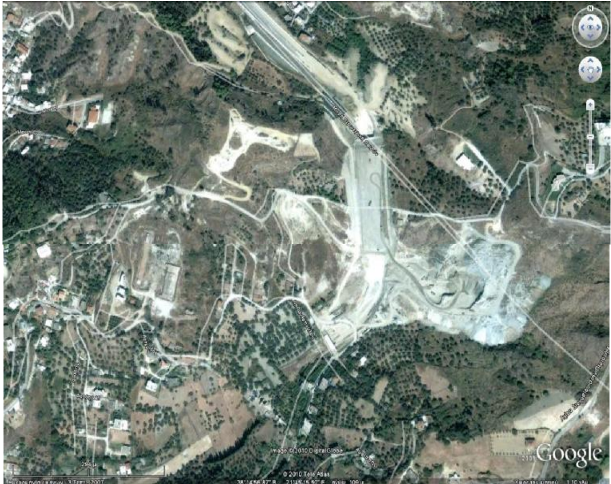
Εικόνα 4.9: Κατασκευή ΜΠΠ από Χ.Θ. 0+840 έως Χ.Θ. 0+925 και από Χ.Θ. 1+230 έως Χ.Θ. 1+650.
