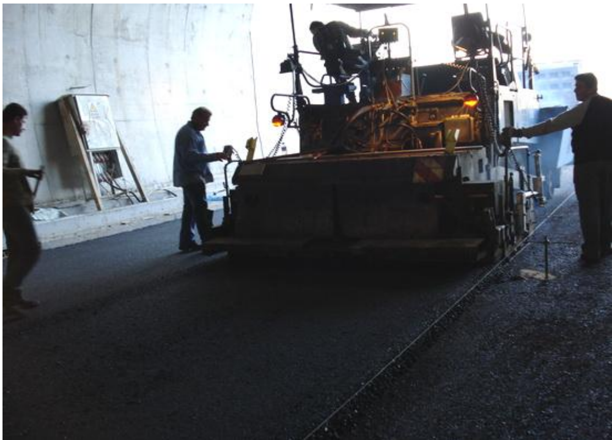
Ασφαλτόστρωση και οδοστρωσία σήραγγας (Εργολαβία Έδραση)
