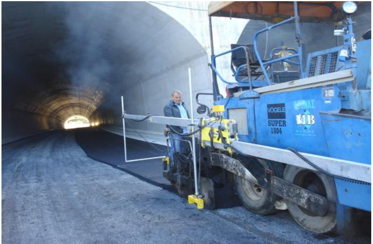
Ασφαλτόστρωση σήραγγας (Εργολαβία Έδραση)
