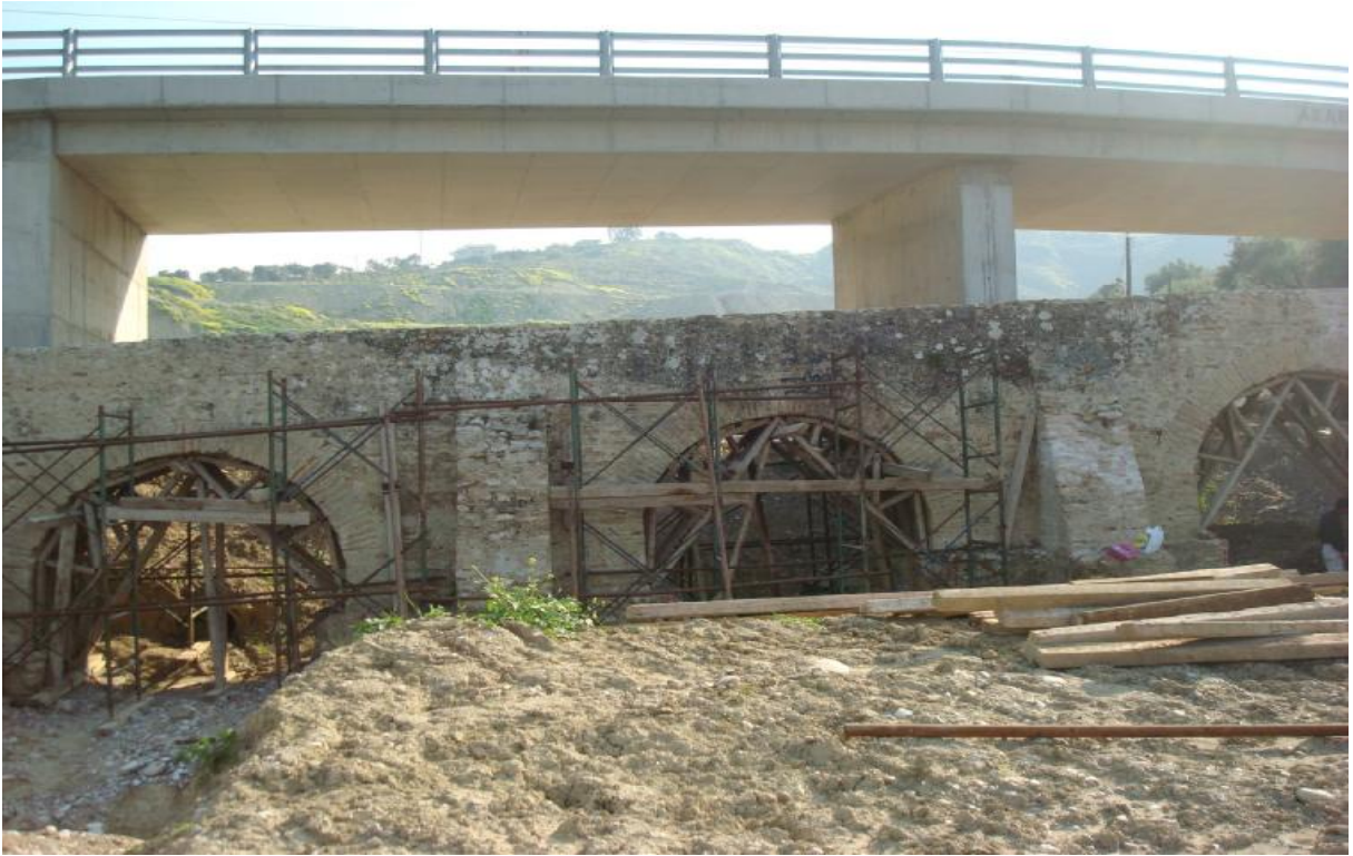
Υποστύλωση του μεσαιωνικού υδραγωγείου
