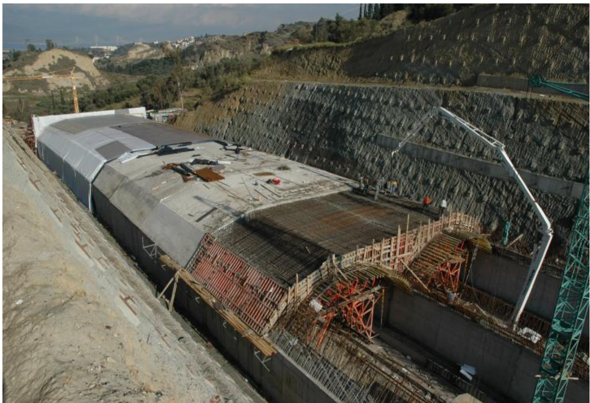
Εικόνα 3.4: Κατασκευή της σήραγγας με τη μέθοδο Cut & Cover
