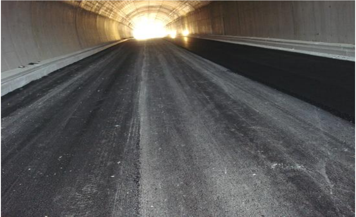
Ασφαλτόστρωση και οδοστρωσία σήραγγας (Εργολαβία Έδραση)
