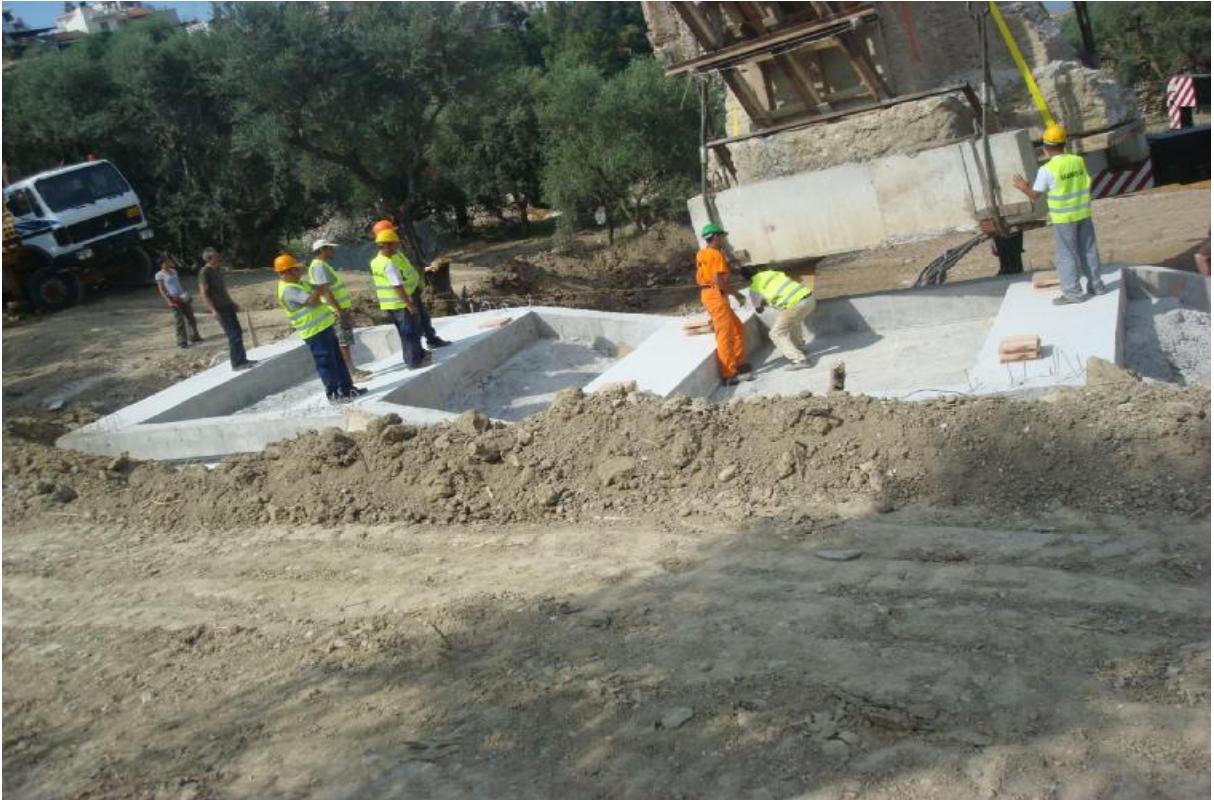
Τοποθέτηση τμήματος μεσαιωνικού υδραγωγείου
