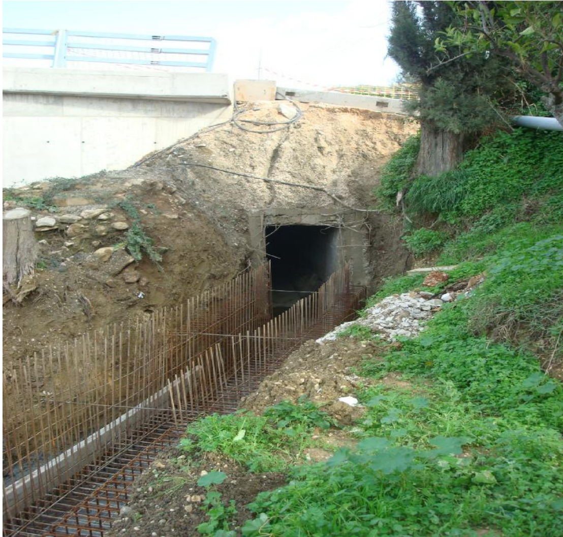
Εικόνα 3.12: Αγωγός προς σκυροδέτηση πλάγια της γέφυρας Ασυρμάτου
