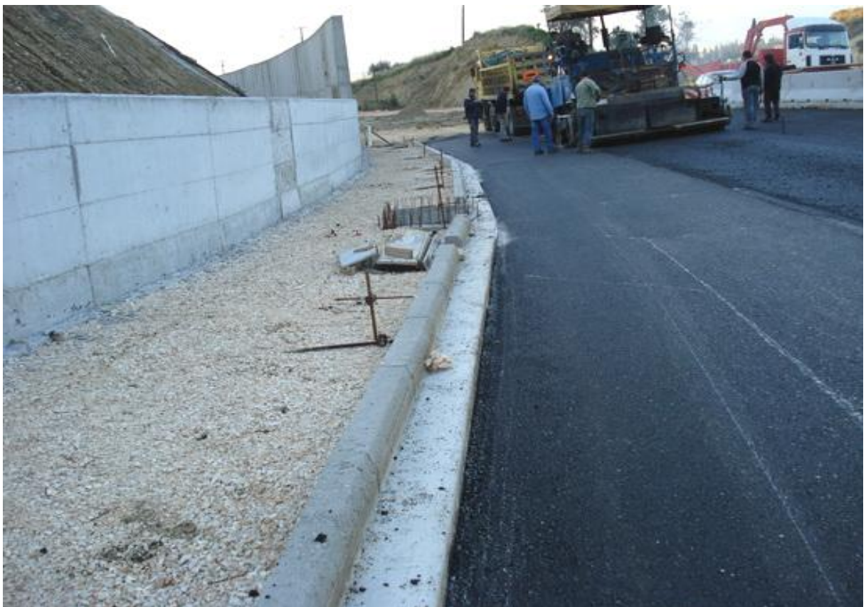
Με τη χρήση φελτέρας ασφαλτοστρώνεται ο δρόμος (Εργολαβία Έδραση)
