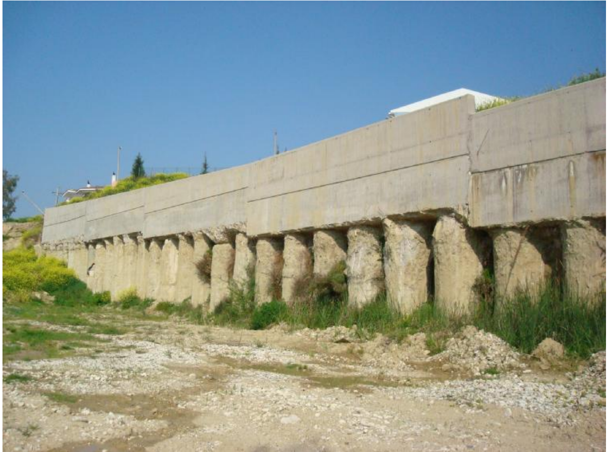
Εικόνα 3.6: Τοίχος αντιστήριξης - Πασσαλότοιχος
