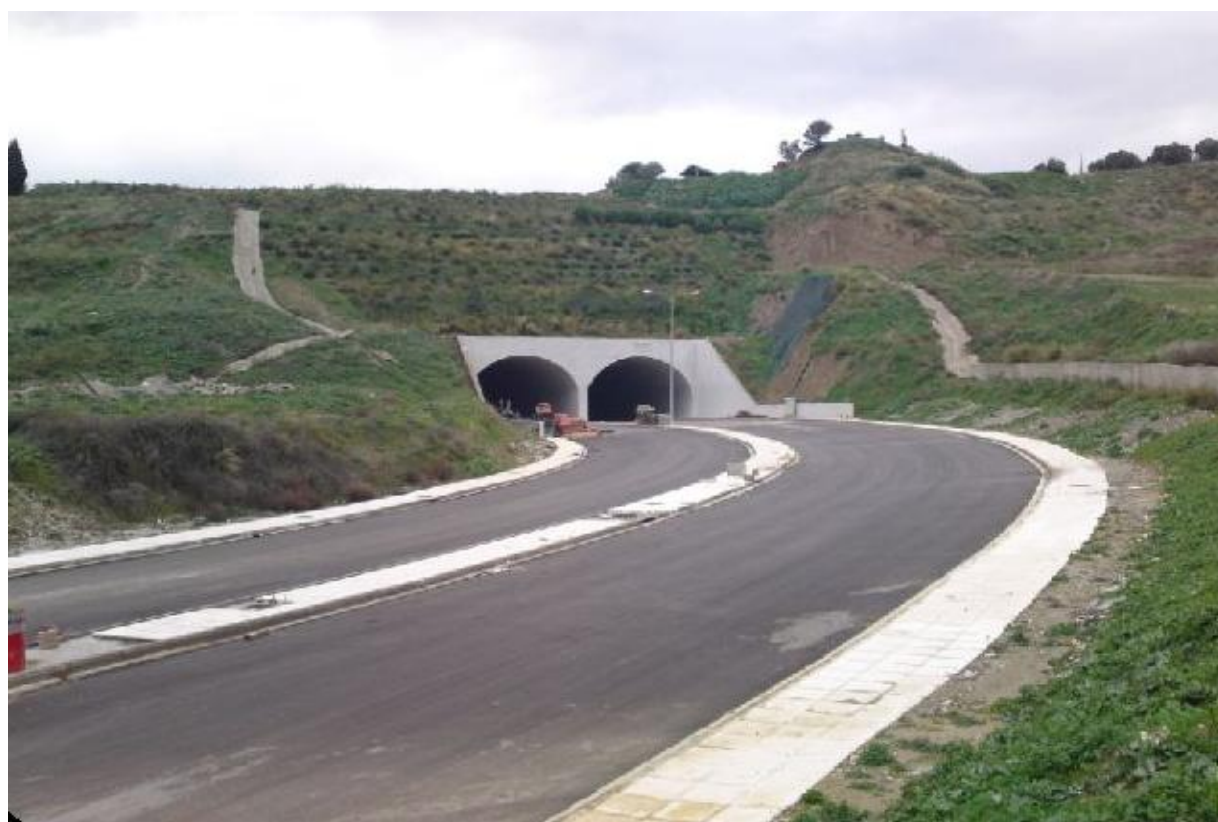
Εικόνα 4.6: Κατασκευή Μεγάλου Τεχνητού τύπου CUT & COVER,
