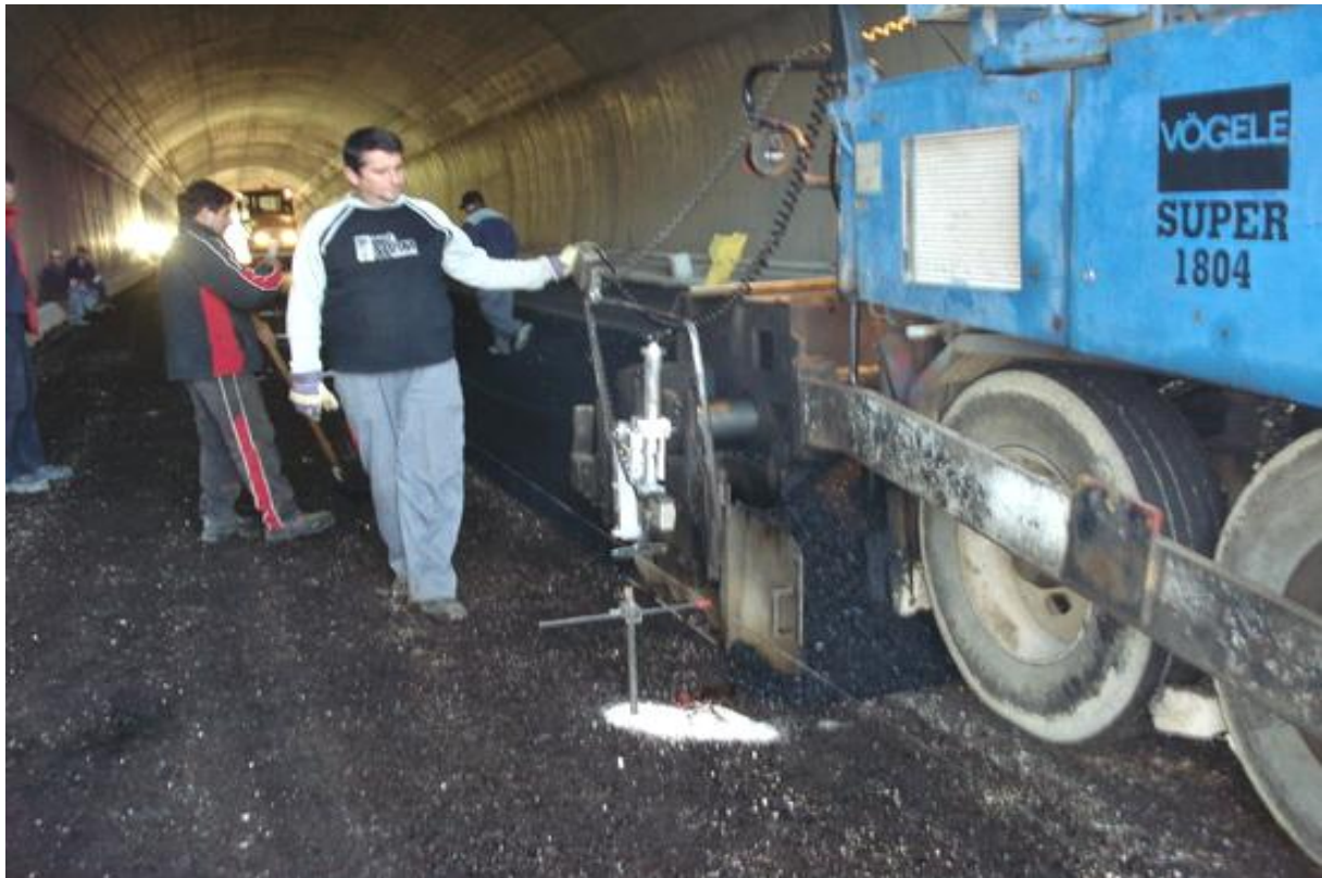
Ασφαλτόστρωση και οδοστρωσία σήραγγας (Εργολαβία Έδραση)
