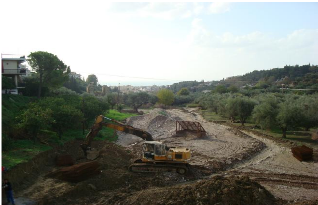
Εικόνα 3.9: Χωματουργικές εργασίες διάνοιξης – Εργολαβία ΑΚΑΜΑΣ
