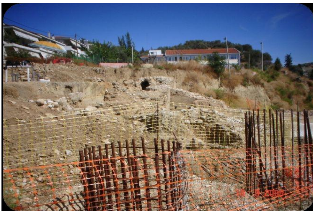
Εικόνα 4.2: Εργασίες προσαρμογής και βελτίωσης στην περιοχή του κόμβου εισόδου (Κουρτέση)
