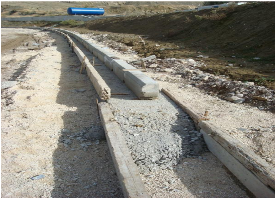
Εικόνα 3.10: Κατασκευή κρασπεδόρειθρων στην περιοχή Ασύρματος
