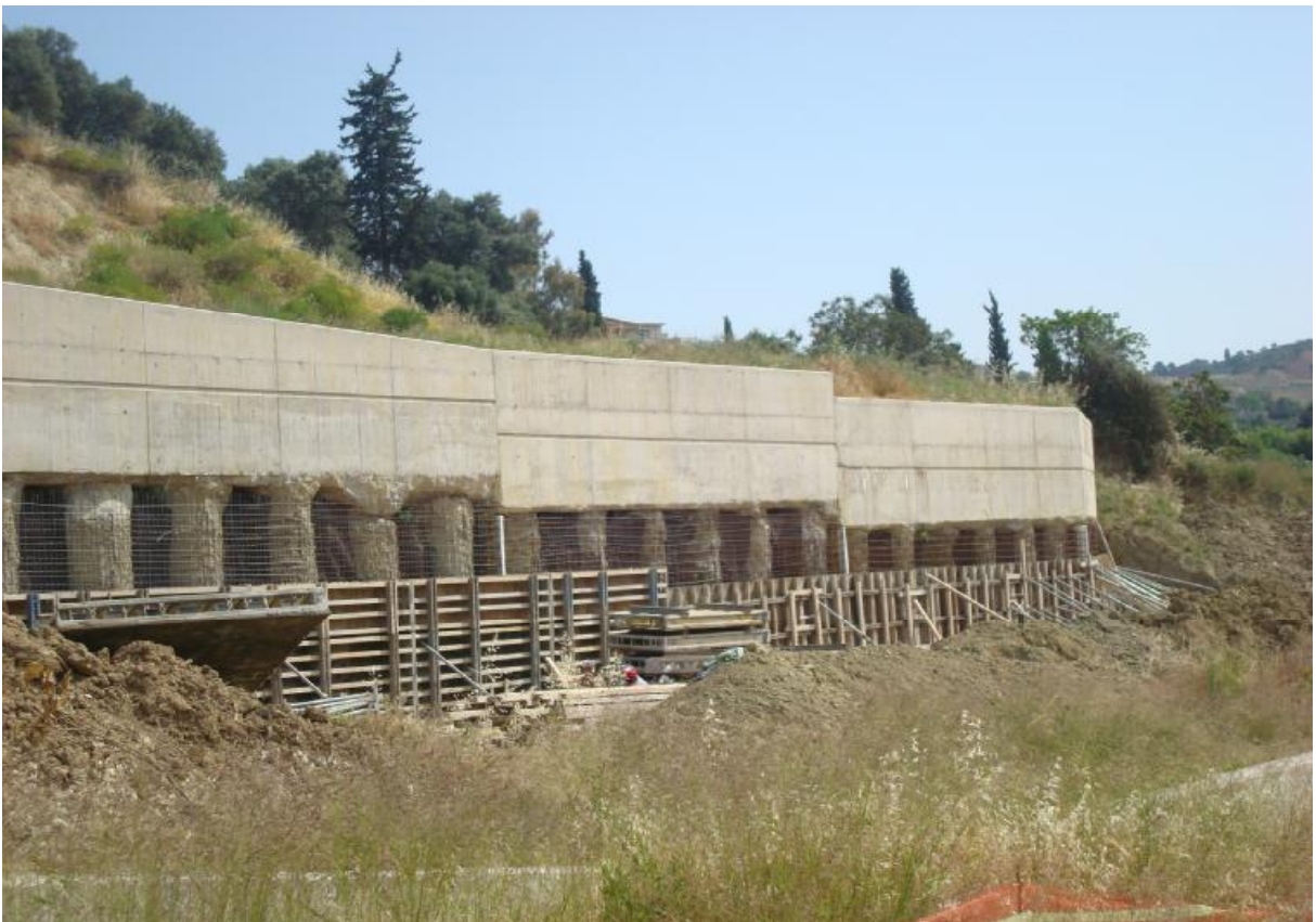
Εργασίες σκυροδέτησης του τοίχου αντιστήριξης - πασσαλότοιχος
