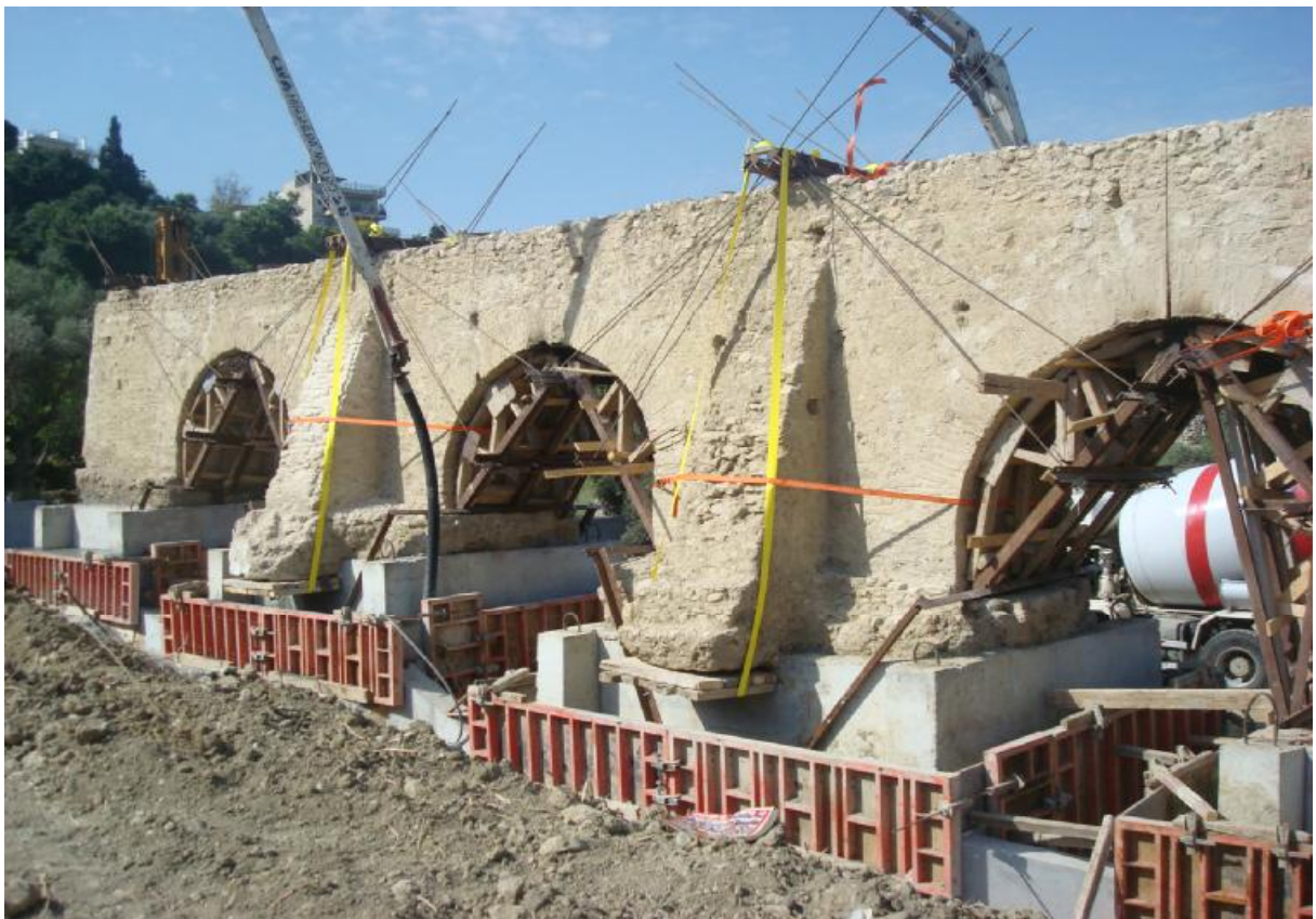
Εργασίες πριν την σκυροδέτηση του μεσαιωνικού υδραγωγείου στην τελική του θέση
