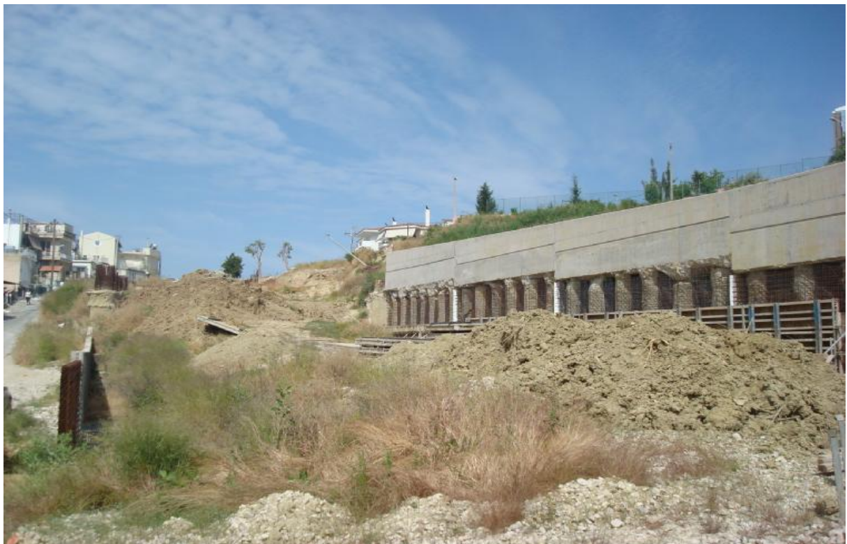
Εργασίες σκυροδέτησης του τοίχου αντιστήριξης - πασσαλότοιχος
