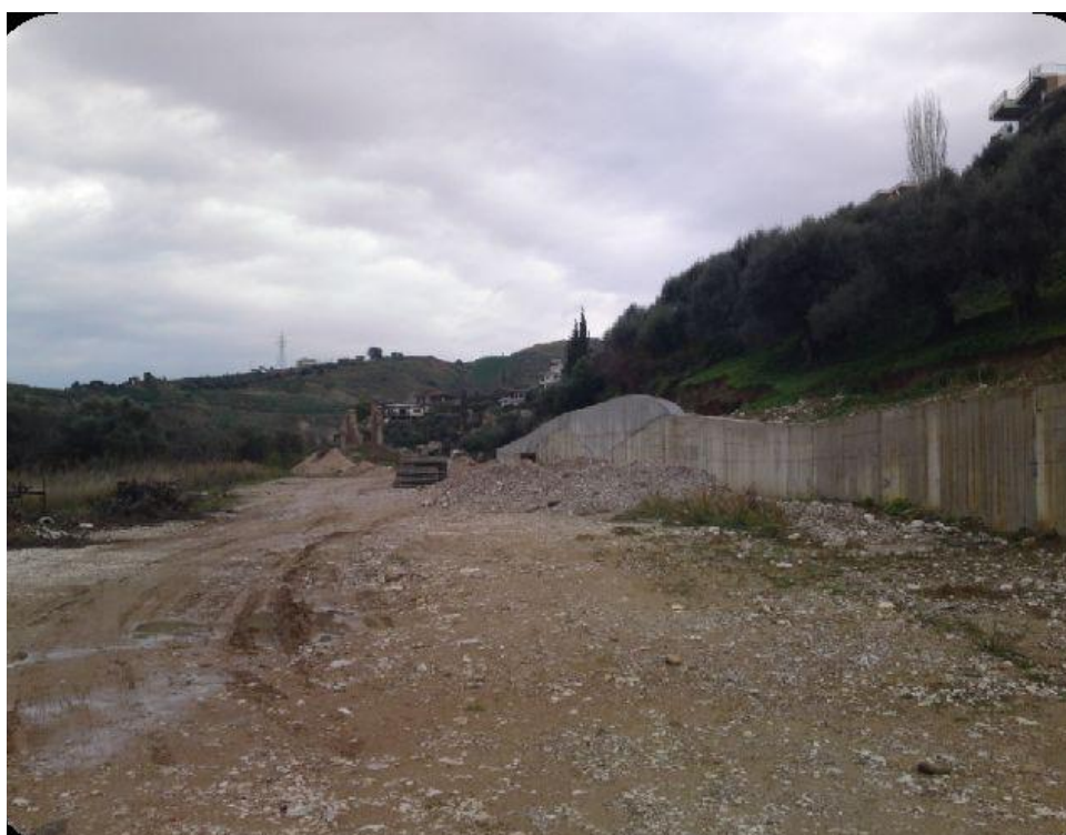
Εικόνα 4.3: Εργασίες προσαρμογής και βελτίωσης στην περιοχή του κόμβου εισόδου (Κουρτέση).
