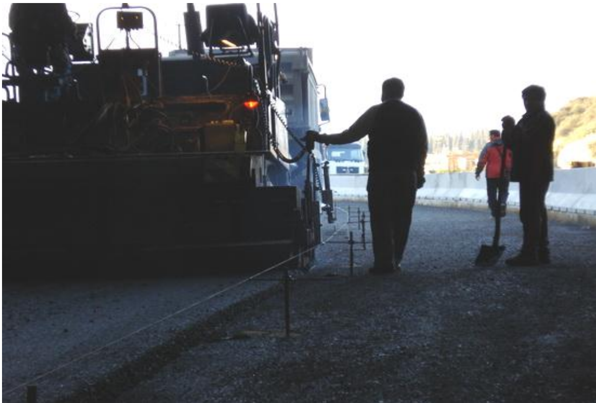
Εικόνα 4.8: Ασφαλτόστρωση και οδοστρωσία της σήραγγας (Εργαλαβία Έδραση)
