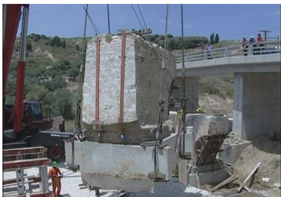
Εικόνα 5.4, 5.5, 5.6, 5.7, 5.8, 5.9, 5.10, 5.11: Μεταφορά Ρωμαϊκού Υδραγωγείου - Βίντεο κοπής
