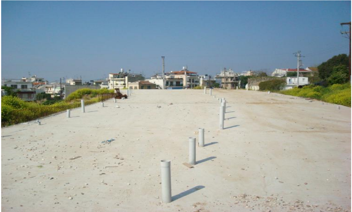
Σήραγγα με εκσκαφή και επικάλυψη (cut & cover)
