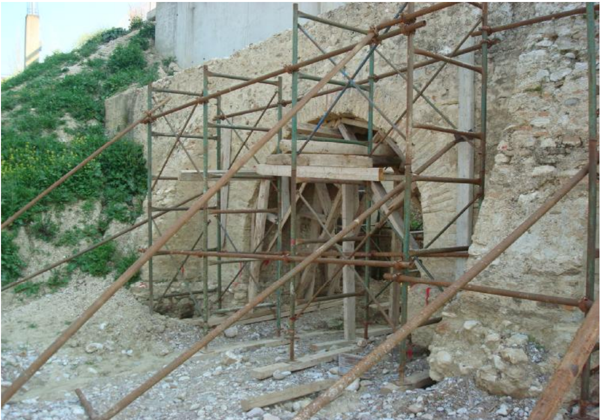
Υποστύλωση του μεσαιωνικού υδραγωγείου
