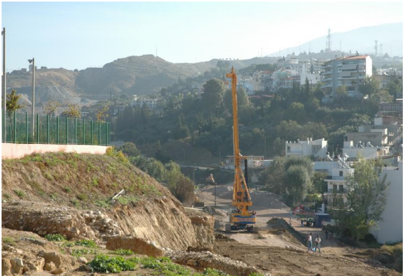
Εικόνα 3.3: Έμψη φρεατοπασσάλων κατά την μέθοδο Top - Down
