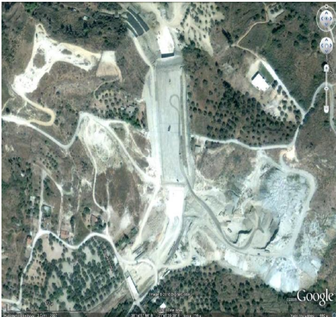
Εικόνα 4.4: Κατασκευή Μικρής Περιμετρικής Πατρών από ΧΘ 0+900 έως ΧΘ 1+230
