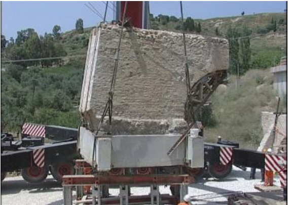
Εικόνα 5.4, 5.5, 5.6, 5.7, 5.8, 5.9, 5.10, 5.11: Μεταφορά Ρωμαϊκού Υδραγωγείου - Βίντεο κοπής
