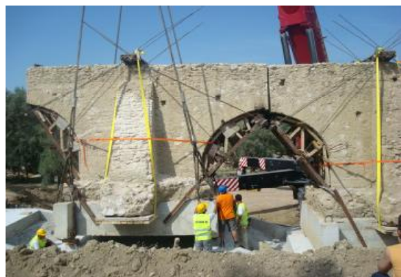
Εικόνα 5.12, 5.13, 5.14, 5.15, 5.16, 5.17, 5.18, 5.19: Μεταφορά Ρωμαϊκού Υδραγωγείου- Βίντεο ένωσης
