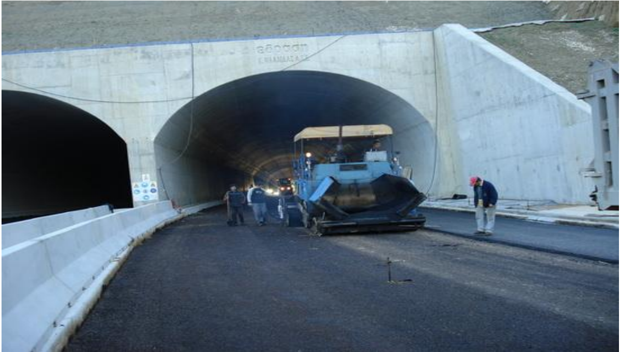
Με τη χρήση φελτέρας ασφαλτοστρώνεται ο δρόμος (Εργολαβία Έδραση)
