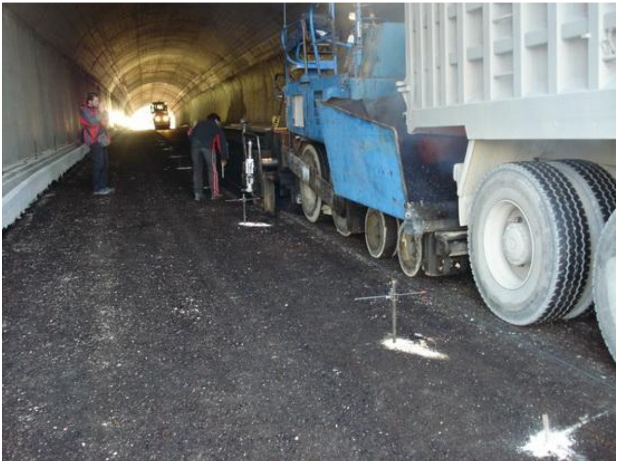
Ασφαλτόστρωση και οδοστρωσία σήραγγας (Εργολαβία Έδραση)
