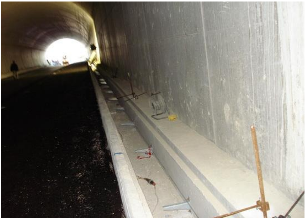
Κράσπεδα σήραγγας (Εργολαβία Έδραση)
