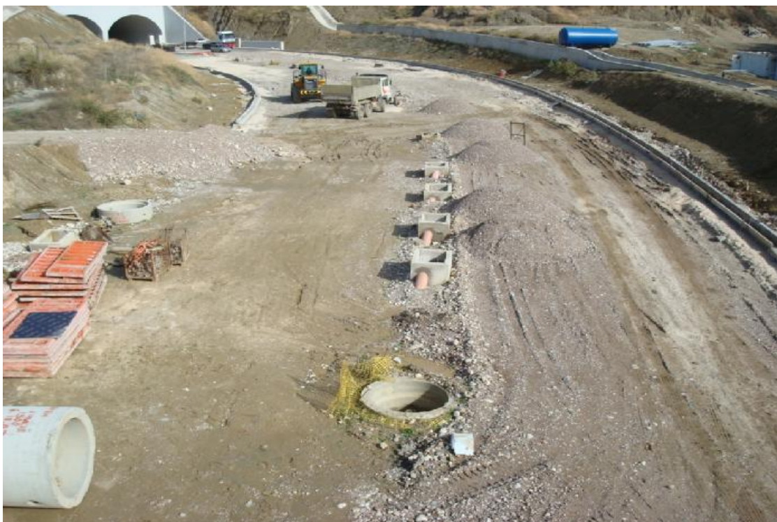
Εικόνα 3.11: Σκάμματα τοποθέτησης αγωγών ΔΕΥΑΠ
