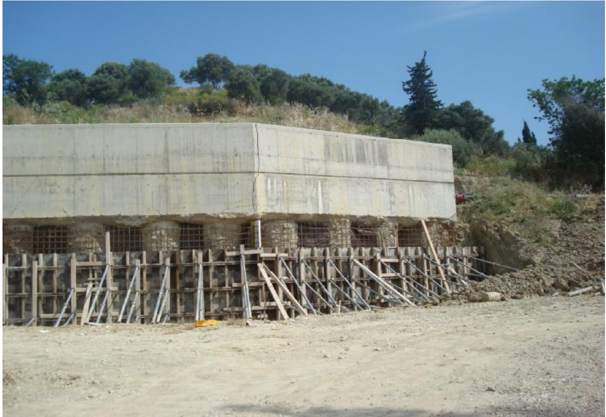
Εργασίες σκυροδέτησης του τοίχου αντιστήριξης - πασσαλότοιχος
