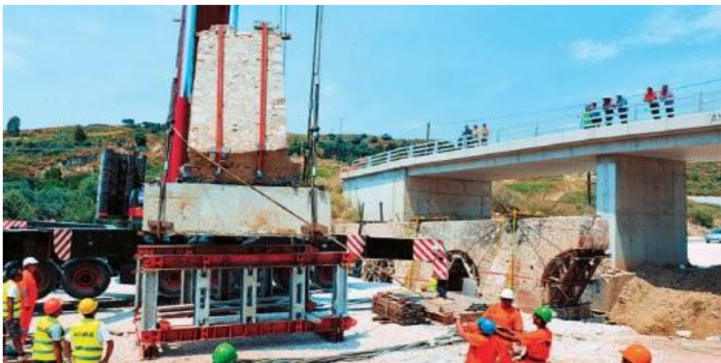
Εικόνα 5.1, 5.2, 5.3: Μεταφορά Ρωμαϊκού Υδραγωγείου
