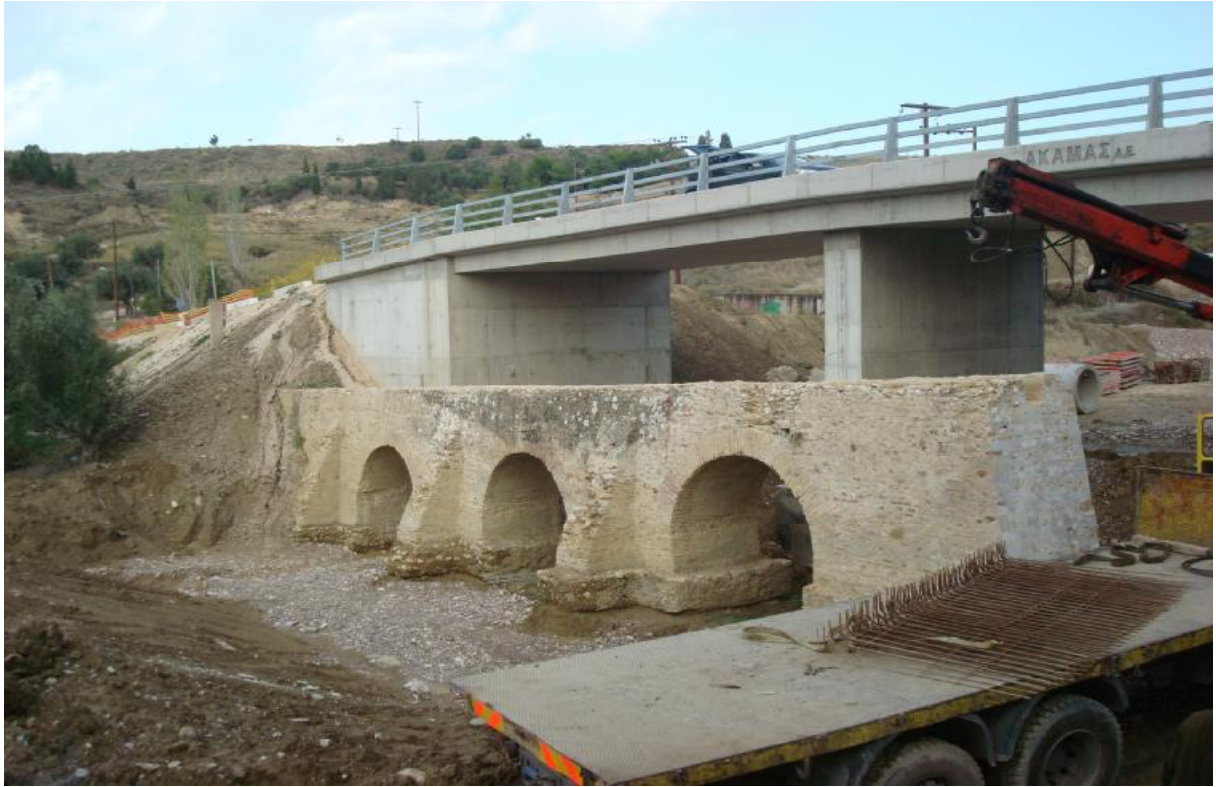
Αρχική θέση του μεσαιωνικού υδραγωγείου
