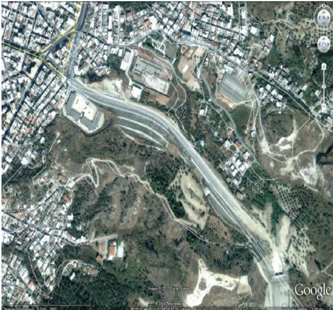
Εικόνα 4.1: Κατασκευή Μικρής Περιμετρικής Πατρών από ΧΘ 0+000 έως ΧΘ 0+900
