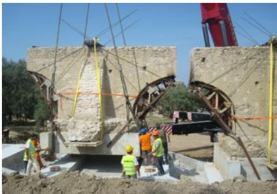
Εικόνα 5.12, 5.13, 5.14, 5.15, 5.16, 5.17, 5.18, 5.19: Μεταφορά Ρωμαϊκού Υδραγωγείου- Βίντεο ένωσης
