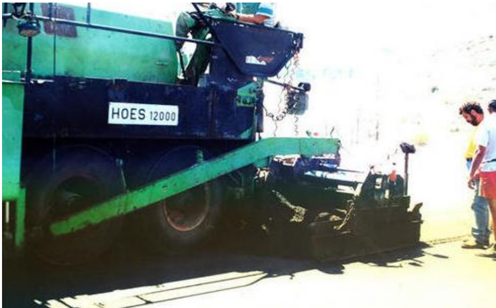
Σχήμα 4.5. : Μηχάνημα διάστρωσης ασφαλτομίγματος Slurry Seal ( www.keridis.gr ).
