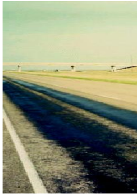
Σχήμα 2.19. : Ανάδυση της ασφάλτου (OEMK – Β.9 , 2002).
