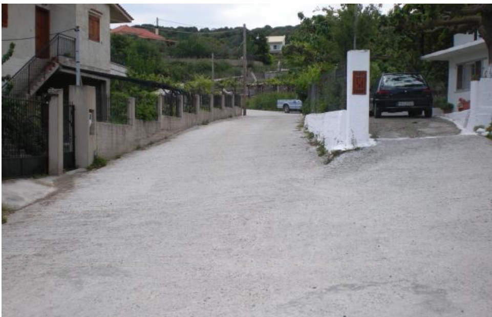
Σχήμα 1.7. : Δύσκαμπτο οδόστρωμα. (άοπλο σκυρόδεμα) στην περιοχή της Πάτρας.
