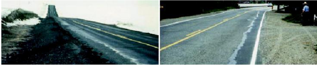
Σχήμα 2.16. : Αποκόλληση αδρανών στις ακμές του οδοστρώματος (ΟΕΜΚ – Β.9 , 2002).
