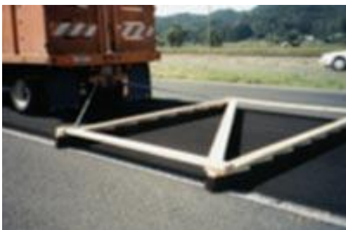
Σχήμα 4.29.ε. : Λείανση θραυστών.
