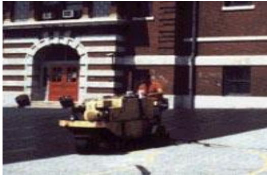
Σχήμα 4.41. : Εργασίες κατά την εφαρμογή της μεθόδου ( www.intermountainlurry.com ).
