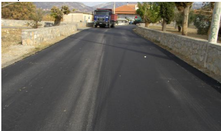
Σχήμα 1.4. : Εύκαμπτο οδοστρώμα (ασφαλτικός τάπητας 2 ημερών).
