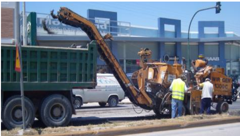
Σχήμα 4.9. : Φρεζάρισμα του παλιού ασφαλτοτάπητα.
