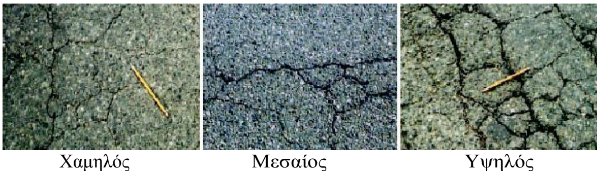
Σχήμα 2.9. : Ταξινόμηση ρωγμών τύπου αλιγάτορα βάσει βαθμού σοβαρότητας (ΟΕΜΚ – Β.9 , 2002).
