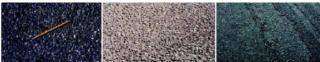
Σχήμα 2.17. : Ταξινόμηση αποκόλλησης αδρανών από το οδόστρωμα ανάλογα με το βαθμό σοβαρότητας τους (ΟΕΜΚ – Β.9 , 2002).
