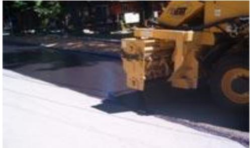
Σχήμα 4.29.δ. : Σμίλευση.
