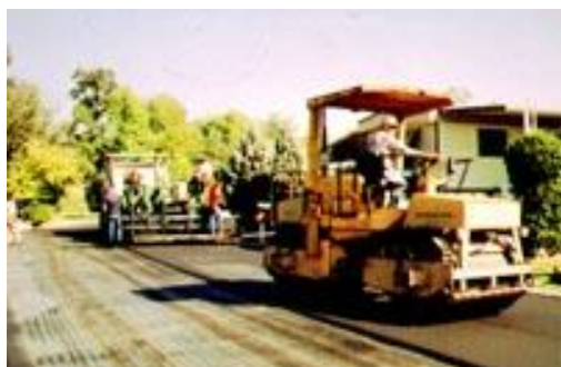
Σχήμα 4.12. : Διάστρωση νέου ασφαλτοτάπητα μετά το φρεζάρισμα του παλιού.
