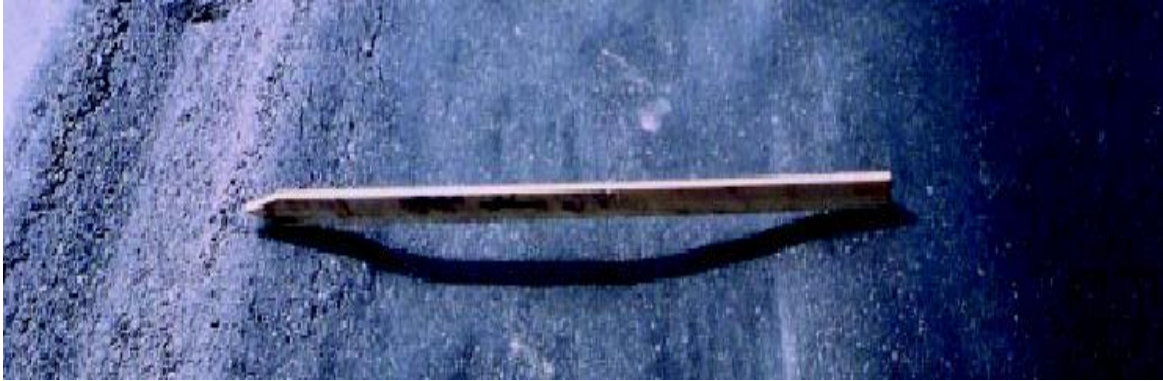
Σχήμα 2.1. : Τροχοαυλακώσεις , (ΟΕΜΚ – Β.9 , 2002).
