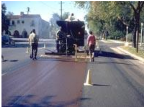
Σχήμα 4.24. : Εργασίες ψεκασμού με την τελική στρώση ασφαλτικού γαλακτώματος ( www.intermountainsslurry.com ).
