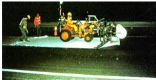
Σχήμα 4.13. : Διάστρωση του υλικού petromat με το σύστημα διάστρωσης AR4000 ( www.intermountainsslurry.com ).
