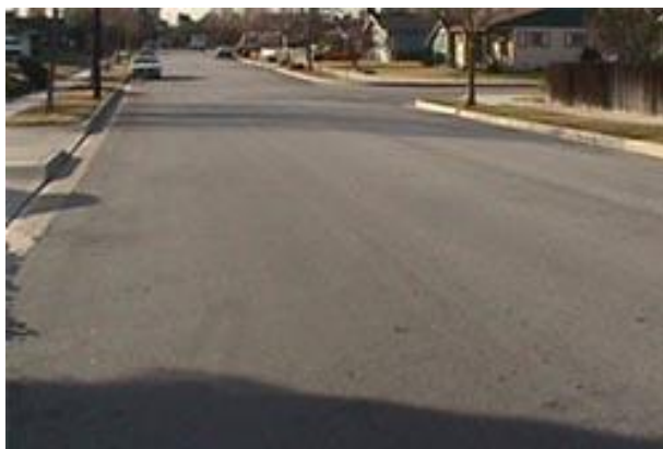
Σχήμα 4.25. : Οδόστρωμα με διάρκεια ζωής 12 χρόνια στο Los Angeles με την εφαρμογή Cape Seal ( www.intermountainsslurry.com ).
