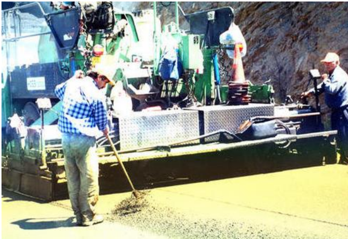
Σχήμα 4.1. : Εργασίες κατά την διάστρωση του ασφαλτομίγματος Slurry Seal ( www.keridis.gr ).
