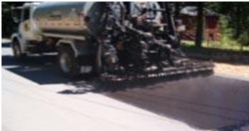
Σχήμα 4.29.α. : Ψεκασμός.
