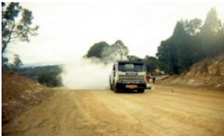
Σχήμα 4.34. : Ψεκασμός με τη μέθοδο Prime coat με το γαλάκτωμα σε θερμοκρασία 60 C o σε χαμηλή θερμοκρασία περιβάλλοντος( www.intermountainsslurry.com ).
