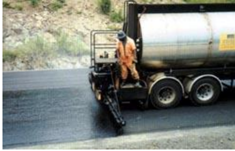
Σχήμα 4.27. : Τυποποιημένο όχημα , εξοπλισμένο με μηχανισμό ψεκασμού και δεξαμενή αποθήκευσης και μεταφοράς ασφαλτικού γαλακτώματος ( www.intermountainsslurry.com ).
