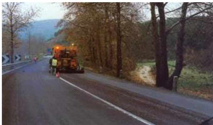
Σχήμα 4.2. : Εργασίες διάστρωσης ασφαλτομίγματος σε εθνική οδό ( www.intermountainsslurry.com ).
