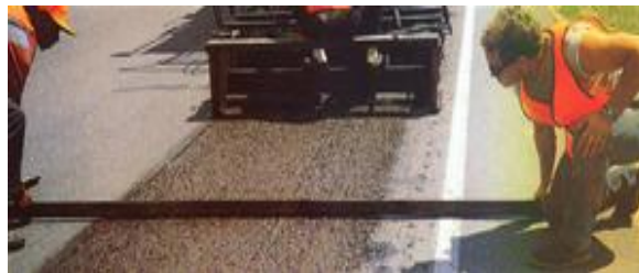
Σχήμα 4.3. : Διάστρωση ασφαλτομίγματος τύπου Slurry Seal διά χειρός ( www.keridis.gr ).
