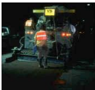
Σχήμα 4.6. : Ασφαλτικές εργασίες μικρό – επιφανειακής στρώσης κατά την διάρκεια της νύχτας ( www.slurry.com ).
