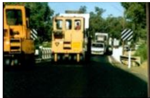
Σχήμα 4.29.στ. :Κυλίνδρωση.
