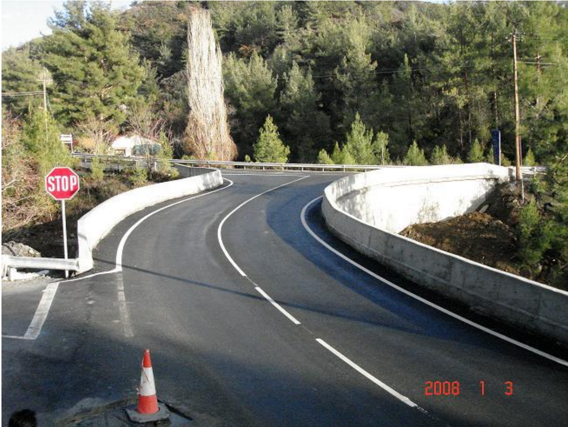
Φωτ. 7.1 Κατάστρωμα της τοξωτής Γέφυρας στο δρόμο Μανδριών-Πλατρών.
