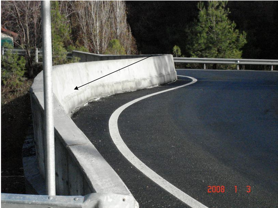
Φωτ. 7.7 Στηθαίο Γέφυρας τύπου step barrier.
