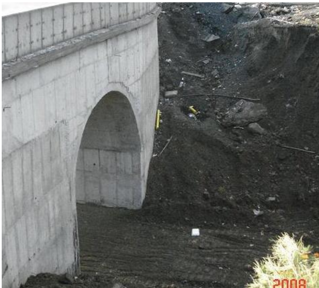
Φωτ. 7.10 Αψίδα της Γέφυρας (ανατολική πλευρά).
