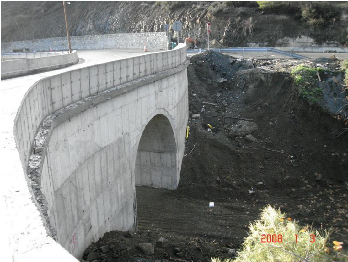
Φωτ. 7.4 Ανατολική πλευρά της Γέφυρας με τους περυγότοιχους.
