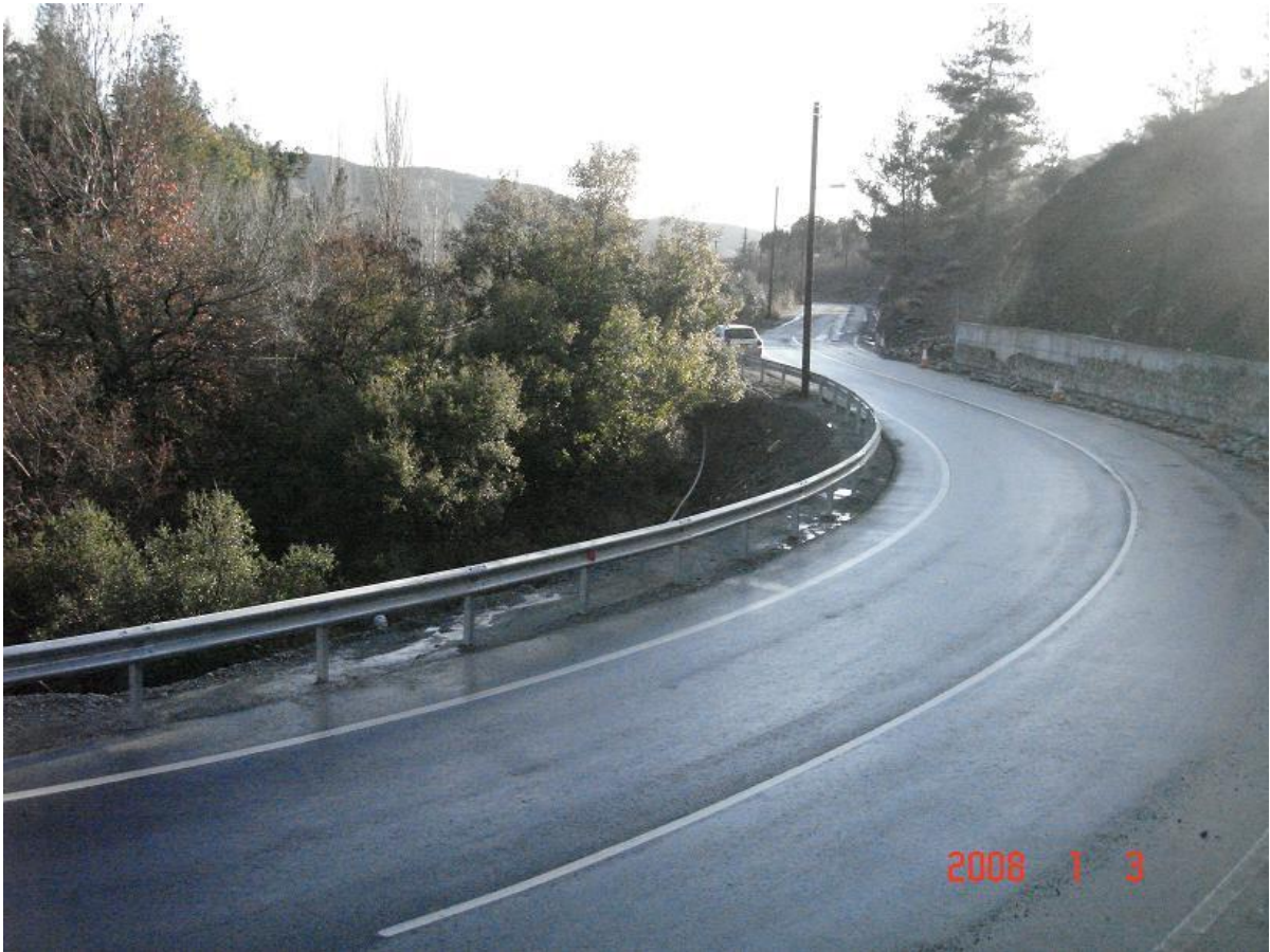
Φωτ. 7.11 Στηθαίο ασφαλείας δρόμου σε στροφή της Γέφυρας.
