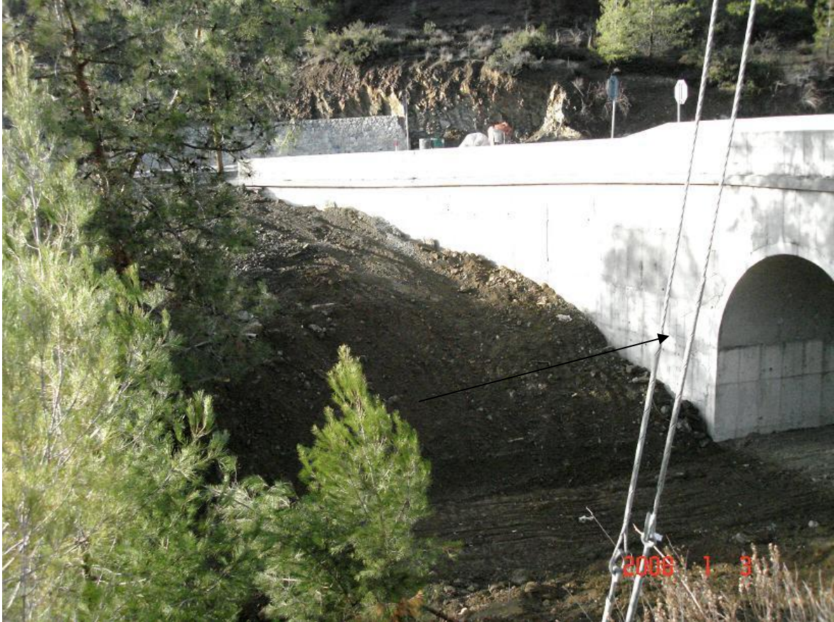
Φωτ. 7.3 Πτερυγότοιχος στην βόρεια πλευρά της Γέφυρας.
