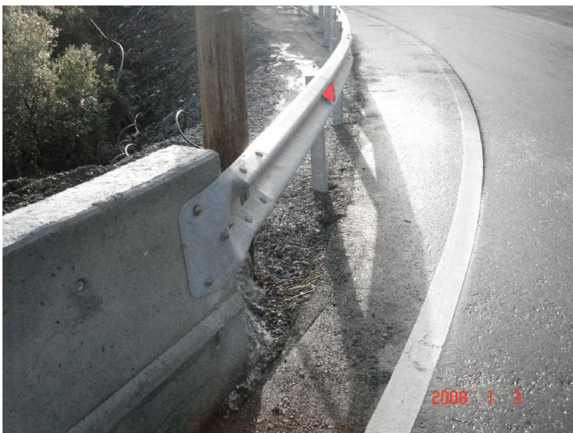
Φωτ. 7.5 Σύνδεση στηθαίων ασφαλείας της Γέφυρας και μπάρας ασφαλείας του δρόμου.
