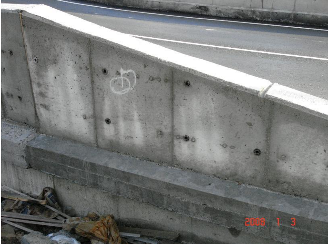
Φωτ. 7.6 Στηθαίο Γέφυρας τύπου step barrier.
