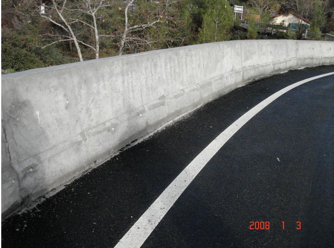
Φωτ. 7.8 Στηθαίο Γέφυρας τύπου step barrier.
