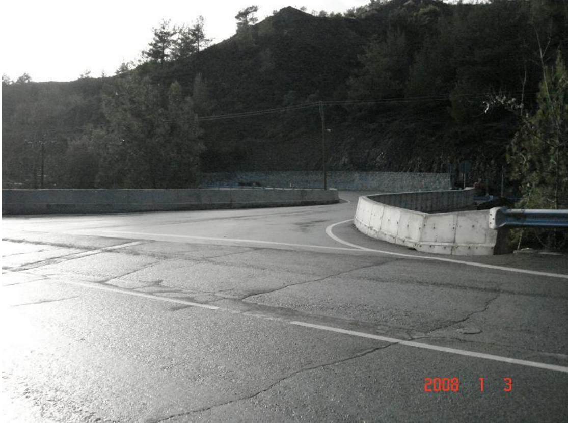
Φωτ. 7.15 Οδόστρωμα Γέφυρας.
