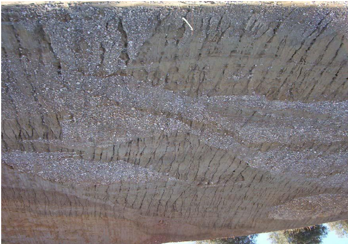
Εικόνα Πρανές 0+550 - 0+700. φακοειδείς ενστρώσεις κροκαλοπαγών πάχους έως 1,5m στον ανώτερο μαργαϊκό ορίζοντα. Μήκος φωτογραφίας 15m.
