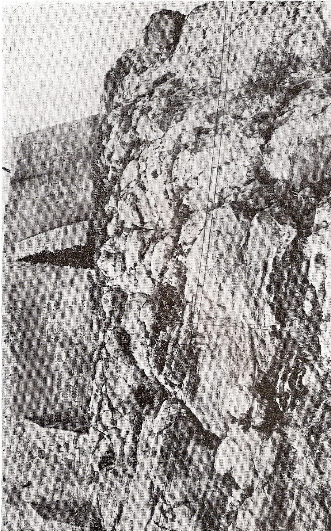
Εικόνα 18 Ζώνη χαλαρώσεως και κερματισμού του ασβεστολιθικού πετρώματος λόγω της έντονης διάρρηξης και της ισχυρής δράσης των αποσαθρωτικών παραγόντων.
