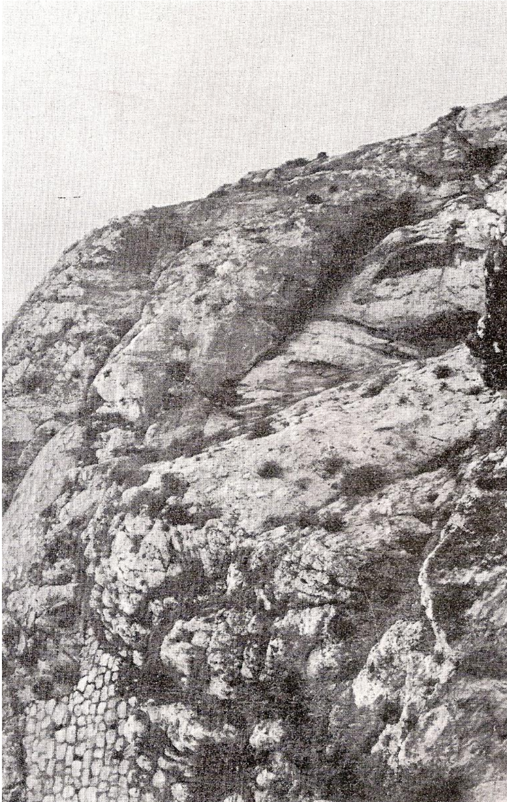
Εικόνα 17 Βόρεια πλευρά της Ακρόπολης. Αστρωτος, συμπαγής ασβεστόλιθος, ασθενώς διερρηγμένος αλλά με σαφή τα ίχνη της διαβρώσεως και με διεύρυνση των ρωγμών κατά μήκος των επιφανειών ασυνεχίας.
