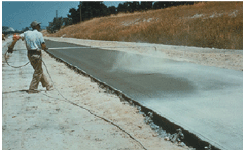
Εικόνα 4. Συντήρηση σκυροδέματος με αντιεξατμιστικές επιφάνειες
