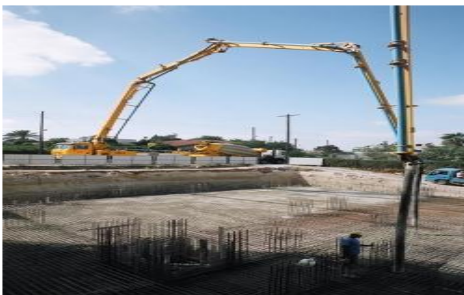
Εικόνα 3. Αντλία μεταφοράς σκυροδέματος
