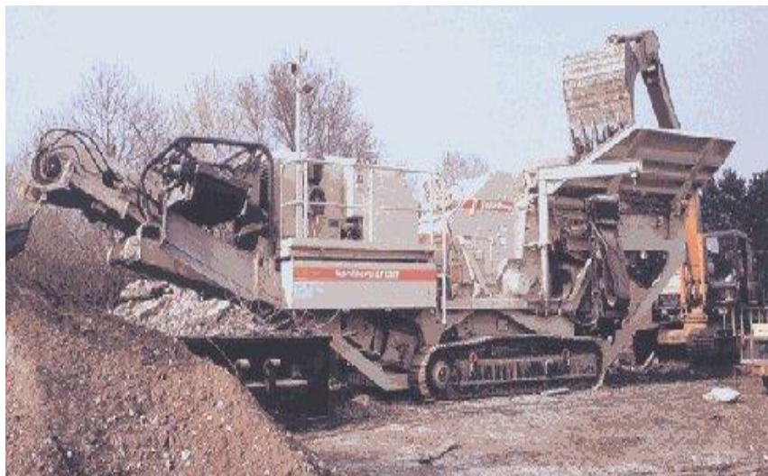
Εικόνα 9. Τυπική μορφή παραγωγικής μονάδας ολοκληρωμένου συστήματος παραγωγής αδρανών σε πραγματική λειτουργία.
