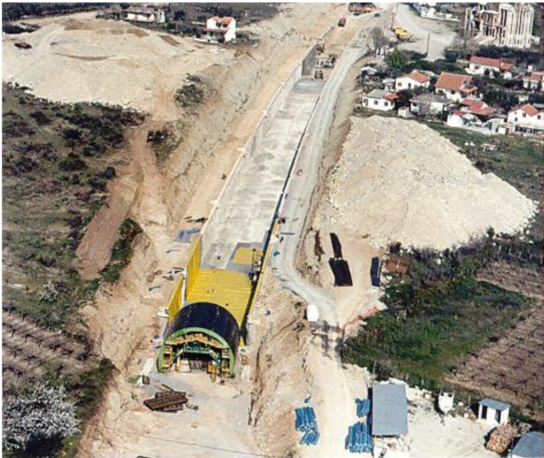
Εφαρμογή της μεθόδου ανοικτού ορύγματος για την κατασκευή τμήματος της σιδηροδρομικής σήραγγας στην περιοχή του Πλαταμώνα (ΕΡΓΟΣΕ).
