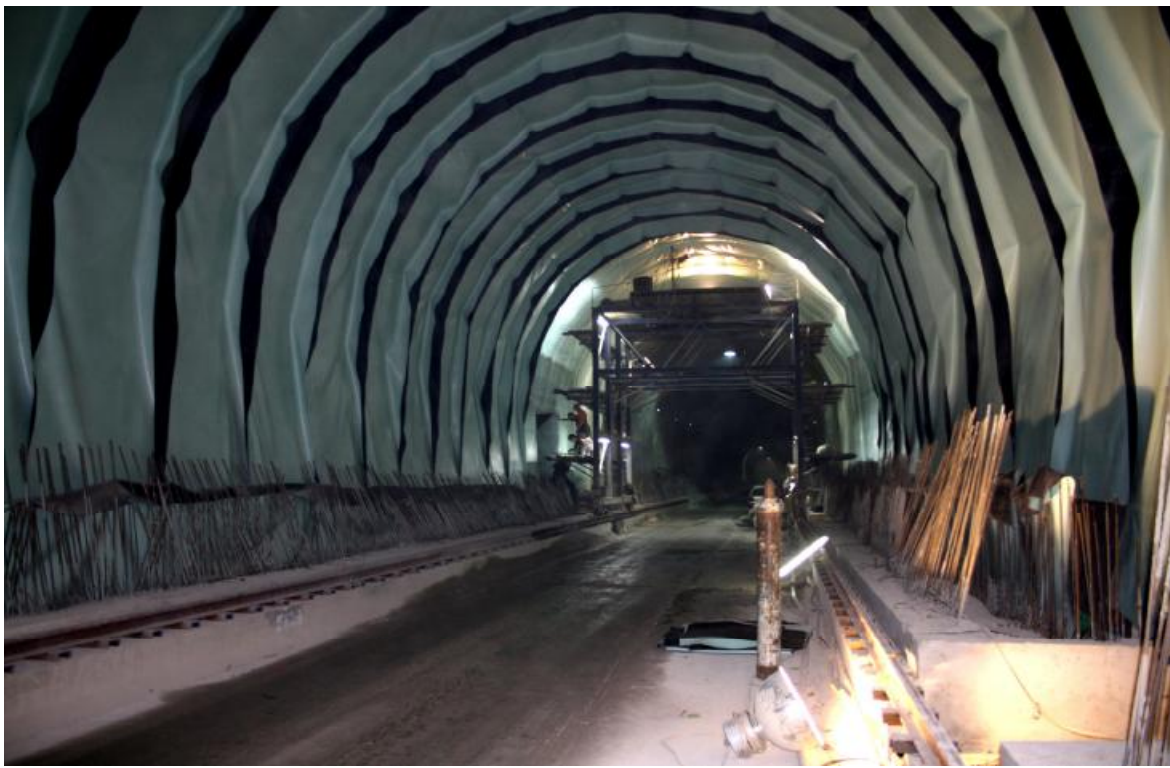
Φωτογραφία από σήραγγα Καλλιδρόμου
