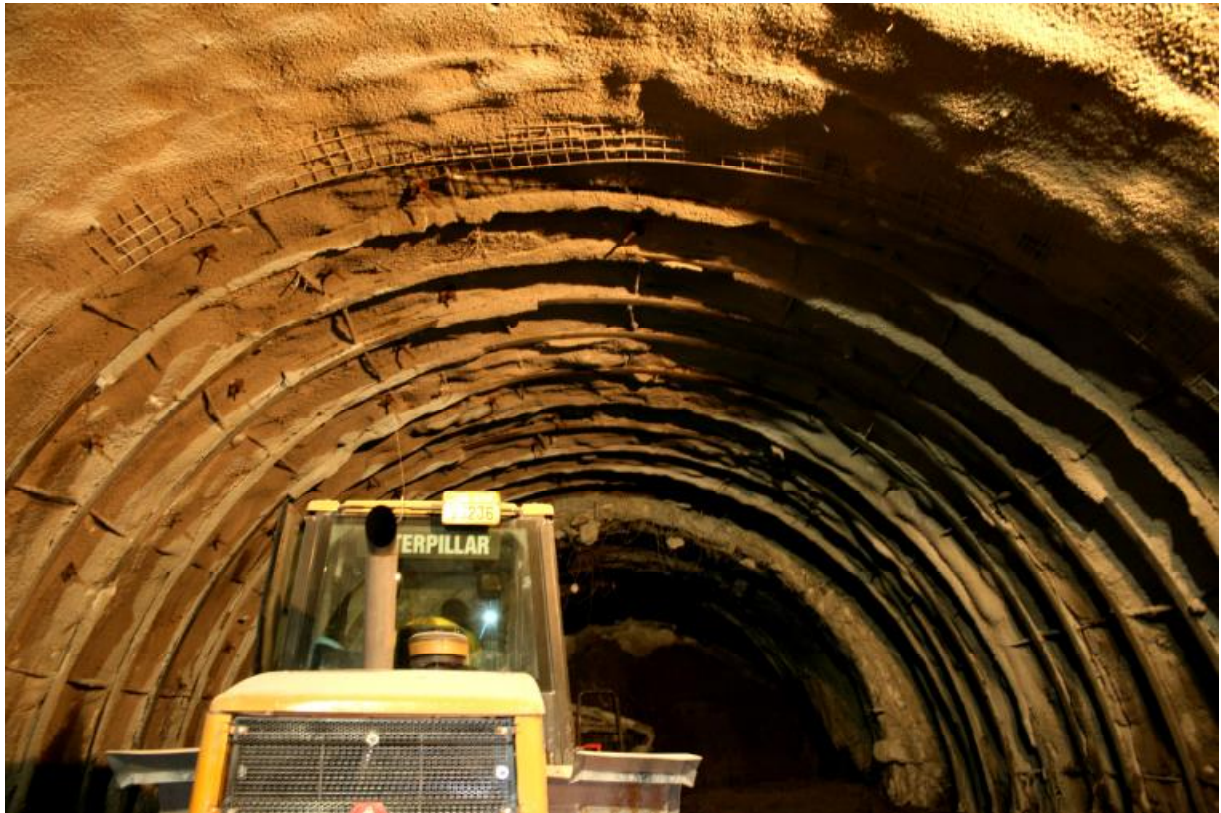
Φωτογραφία από σήραγγα Καλλιδρόμου
