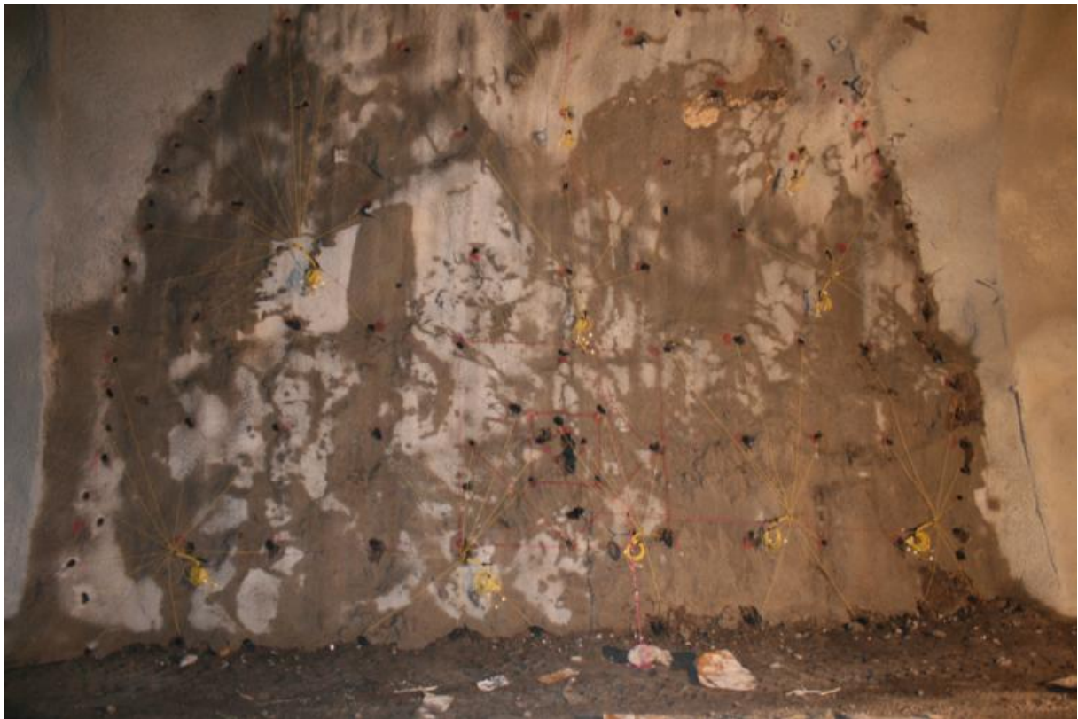
Φωτογραφία από σήραγγα Καλλιδρόμου
