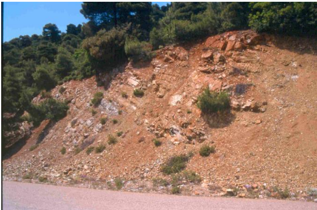
ΦΩΤ 4 Τεκτονικό διάγραμμα (ΤΔ-4) σε σερπεντινωμένους χαρτζβουργίτες με φλέβες ροδιγκίτη (ha.r), στη Χ.Θ. 9+800.
