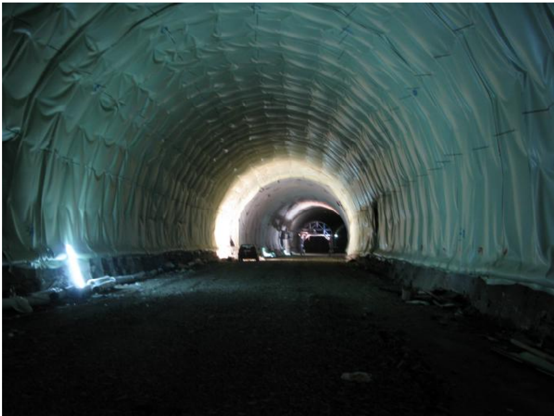
Φωτογραφίες σήραγγας Καλλίδρομου: Τοποθέτηση μεμβράνης αποστράγγισης
