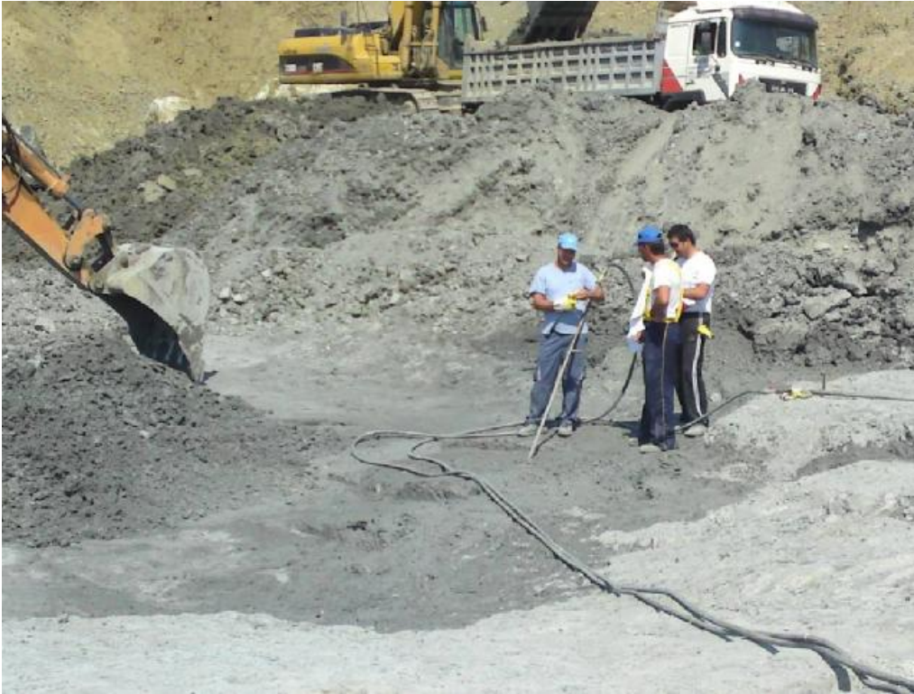
Σχήμα 5.8 Ακροφύσιο πεπιεσμένου αέρα και ομάδα χειριστών
