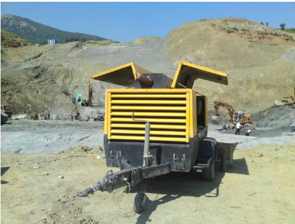
Σχήμα 5.7 Αεροσυμπιεστής που χρησιμοποιείται για τον καθαρισμό της επιφάνειας θεμελίωσης
