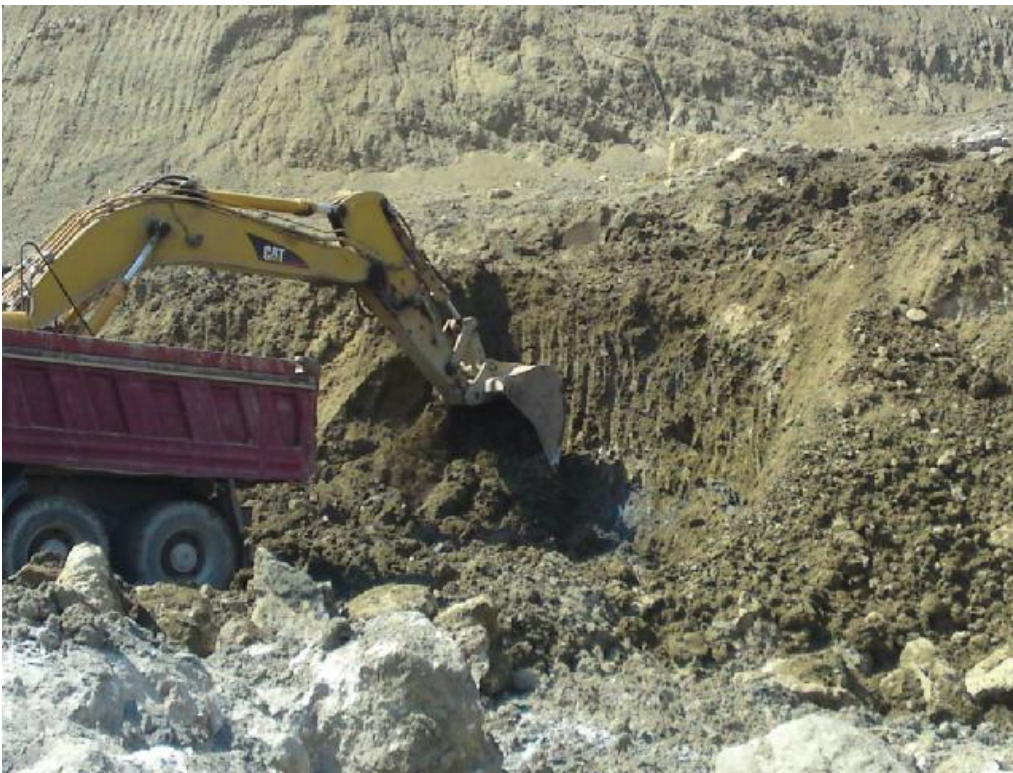
Σχήμα 5.5 Λεπτομέρεια εργασιών εκσκαφής
