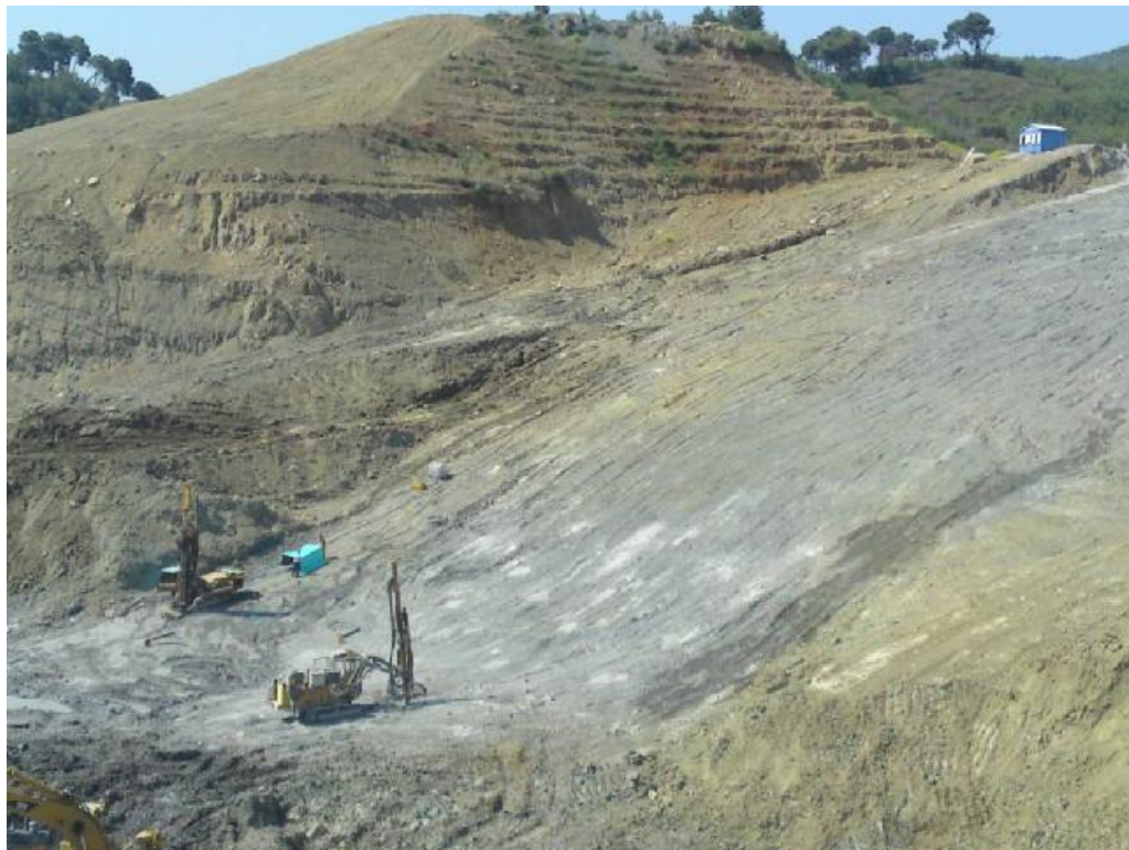
Σχήμα 5.14 Εκτέλεση τσιμεντενέσεων στο δεξί αντέρισμα του φράγματος.
