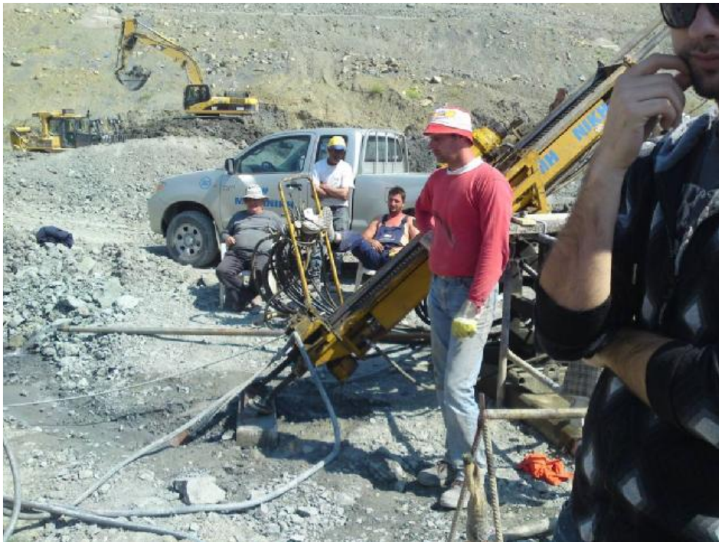
Σχήμα 5.22 Εκτέλεση δοκιμή Lugeon σε κεκλιμένη γεώτρηση
