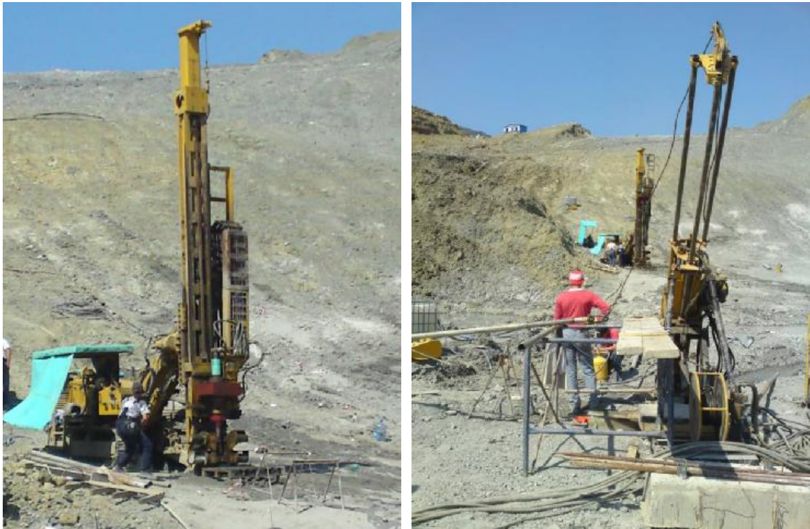
Σχήμα 5.12 Κοντινή λήψη του εξοπλισμού διάνοιξης και πλήρωσης οπών τσιμεντενέσεων
