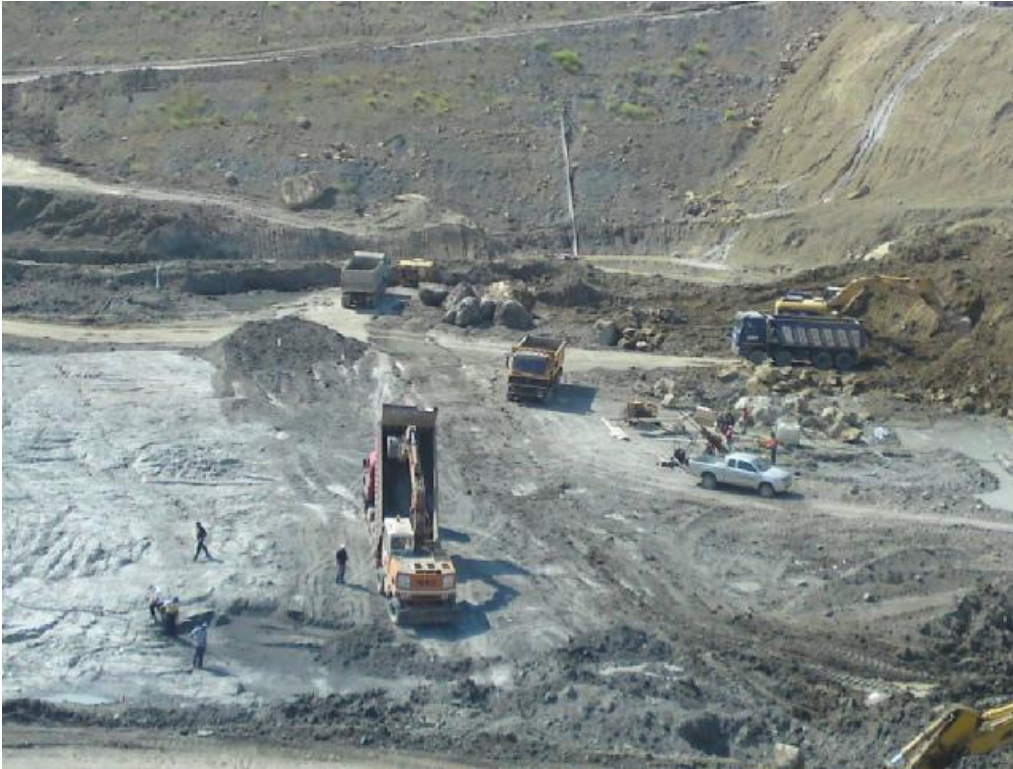
Σχήμα 5.4 Εργασίες εκσκαφών και απομάκρυνσης των υπερκείμενων χαλαρών εδαφικών υλικών
