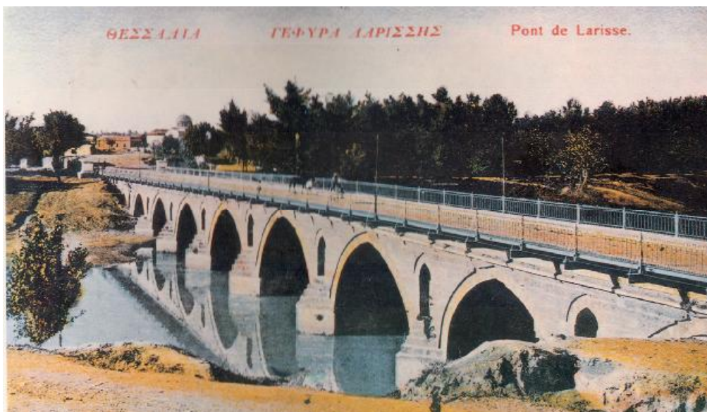
Εικ .3.2: Καρτ-ποσταλ έκδοσης Στουρνάρα γύρω στα 1910. Είναι μια από τις λίγες υπάρχουσες φωτογραφίες που διακρίνονται και τα εννέα ανοίγματα της γέφυρας. Οξυκόρυφο κλείδωμα τόξων, μεγάλο πάχος λευκών αρμών, χρησιμοποίηση μεγάλων ορθογωνικών πετρών και πέτρινα στηθαία.
