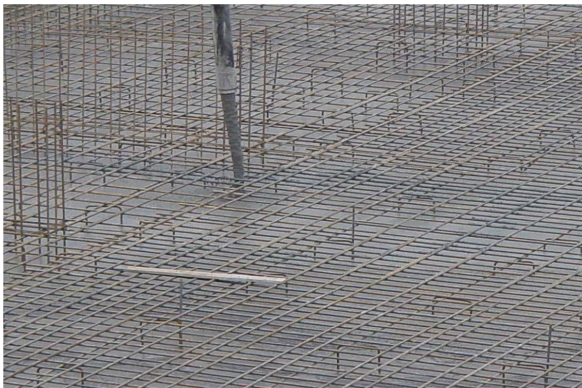
Εικόνες 3.17-3.18: Τοποθέτηση Αυτοσυμπυκνούμενου σκυροδέματος
