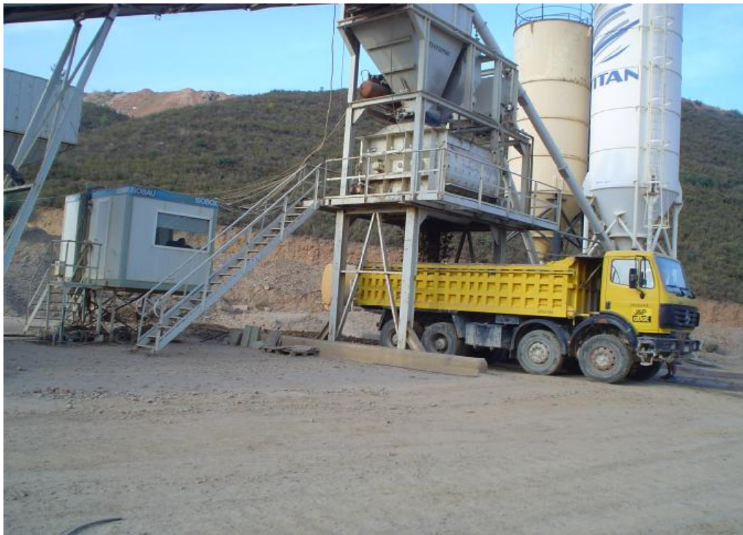
Εικόνα 4.6: Φόρτωση RCC
