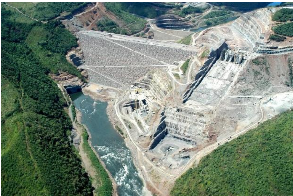
Εικόνα 4.1. Φράγμα Barra Grande στην Βραζιλία
