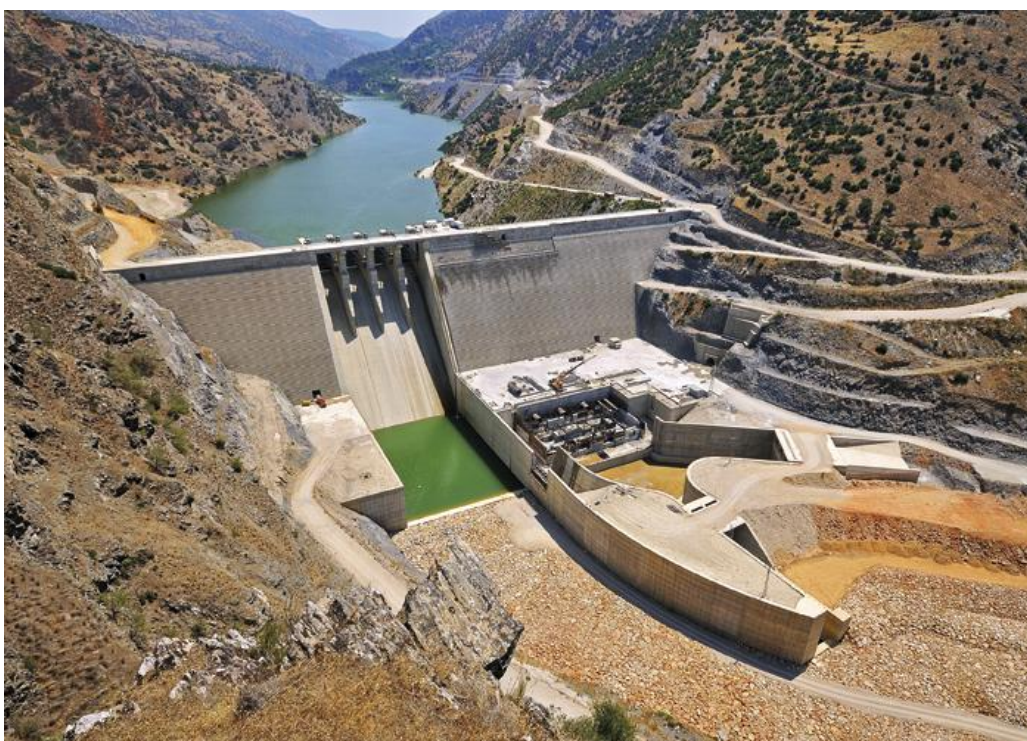
Εικόνα 4.2. Φράγμα Cindere στην Τουρκία
