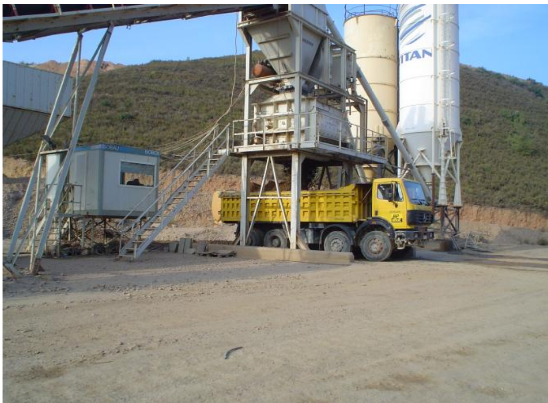
Εικόνα 4.7: Φόρτωση RCC πριν την μεταφορά.
