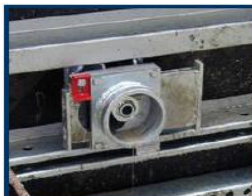
Εικόνα 3.15: Σκυροδέτηση μέσω εισπίεσης από το κατώτατο τμήμα των ξυλοτύπων.
