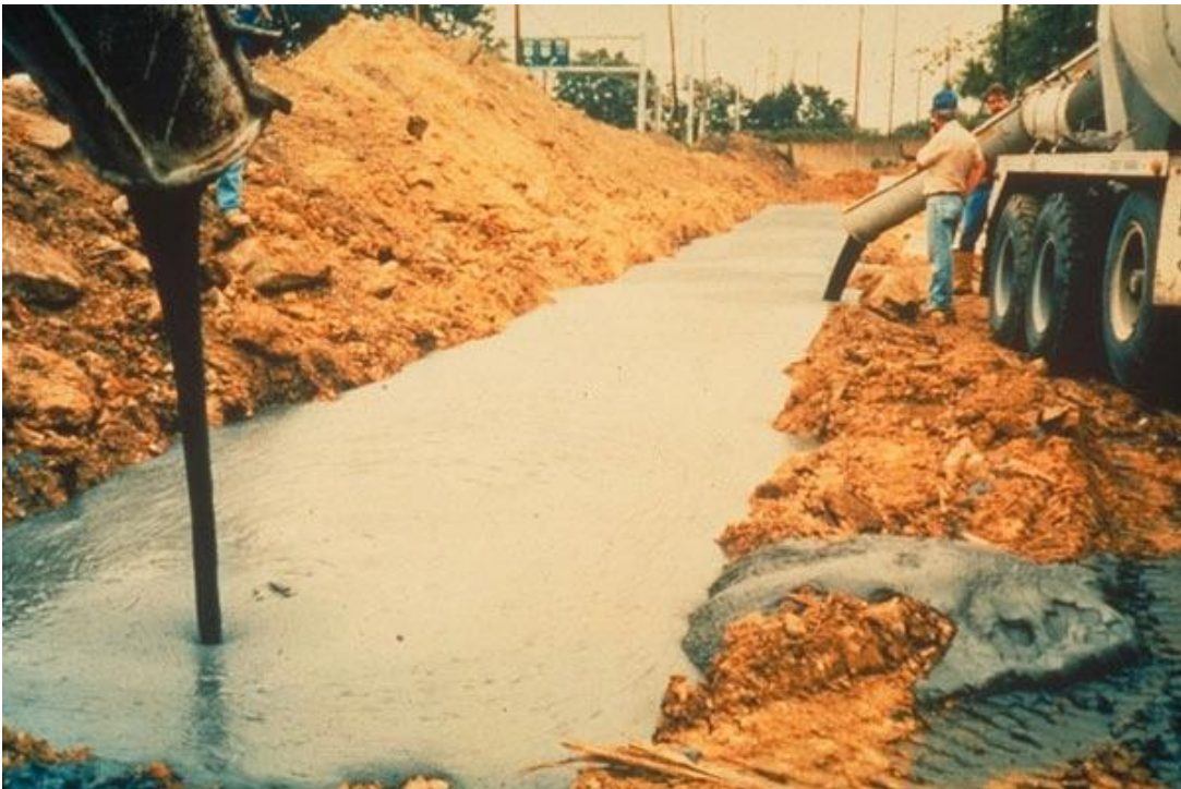
Εικόνες 3.4-3.5: Ρεολογική ικανότητα του Αυτοσυμπυκνούμενου σκυροδέματος
