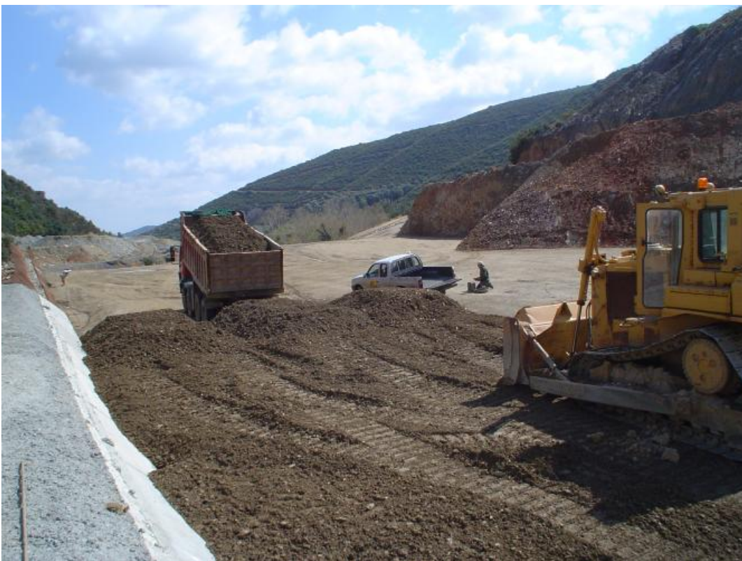
Εικόνα 4.9: Διάστρωση RCC λίγο πριν την διαδικασία συμπίκνωσης.
