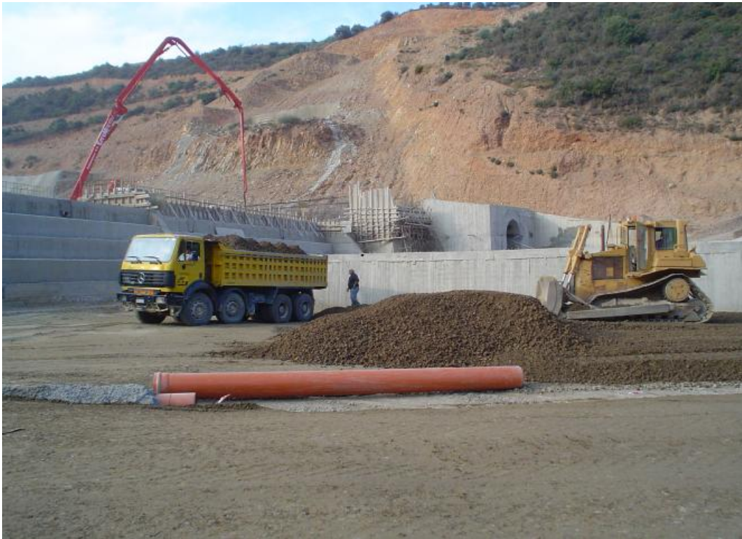
Εικόνα 4.8: Μεταφορά Εναπόθεση και Διάστρωση RCC
