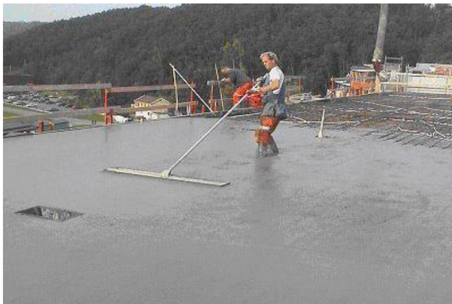
Εικόνα 3.19: Ολοκλήρωση πλακών-διάστρωση σκυροδέματος
