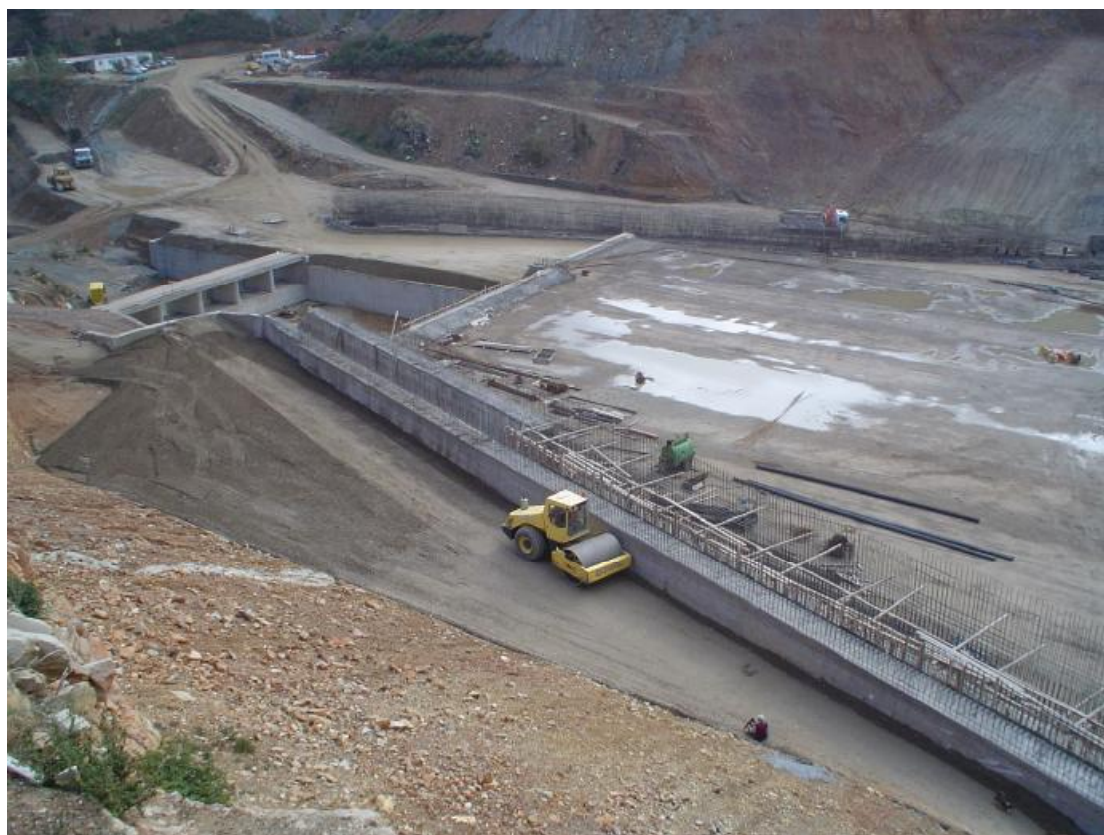
Εικόνα 4.11: Συμπύκνωση RCC
