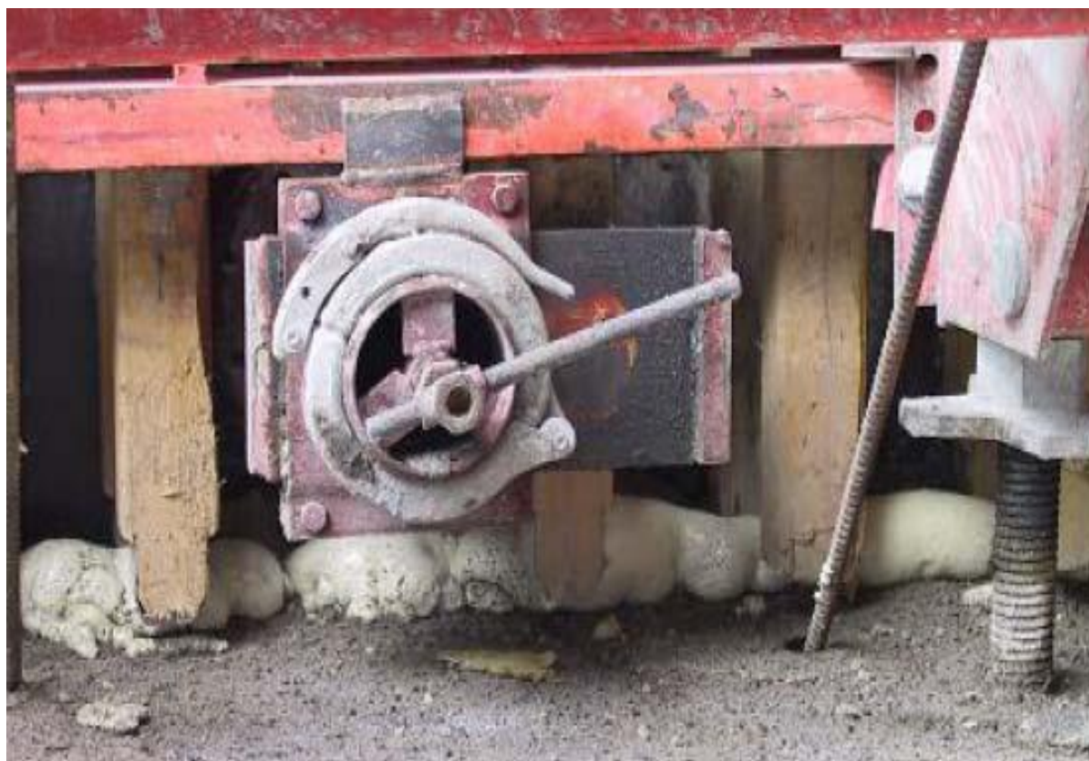
Εικόνα 3.14: Χύτευση Αυτοσυμπκνούμενου σκυροδέματος από τον πυθμένα του καλουπιού (EFNARC et al. 2005).
