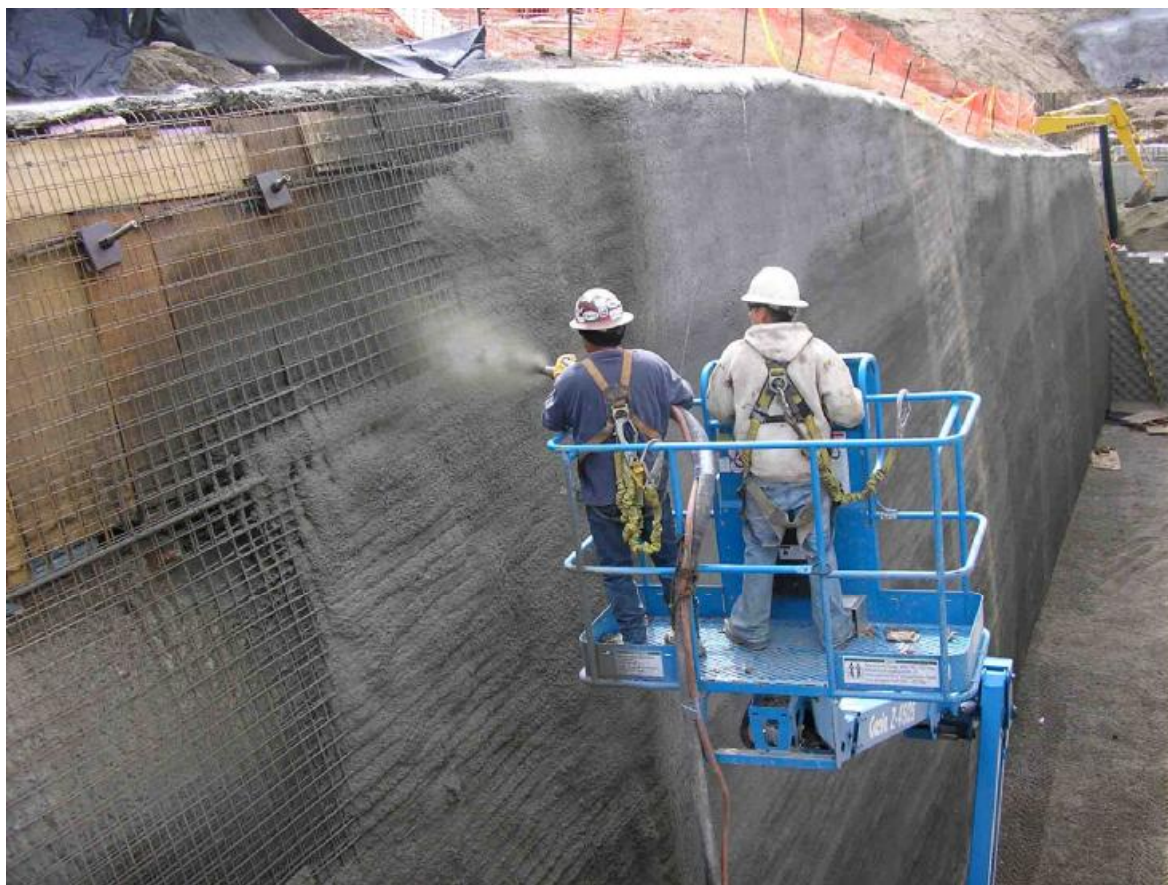
Εικόνα 2.10. Εκτόξευση χωρίς την χρήση robot
