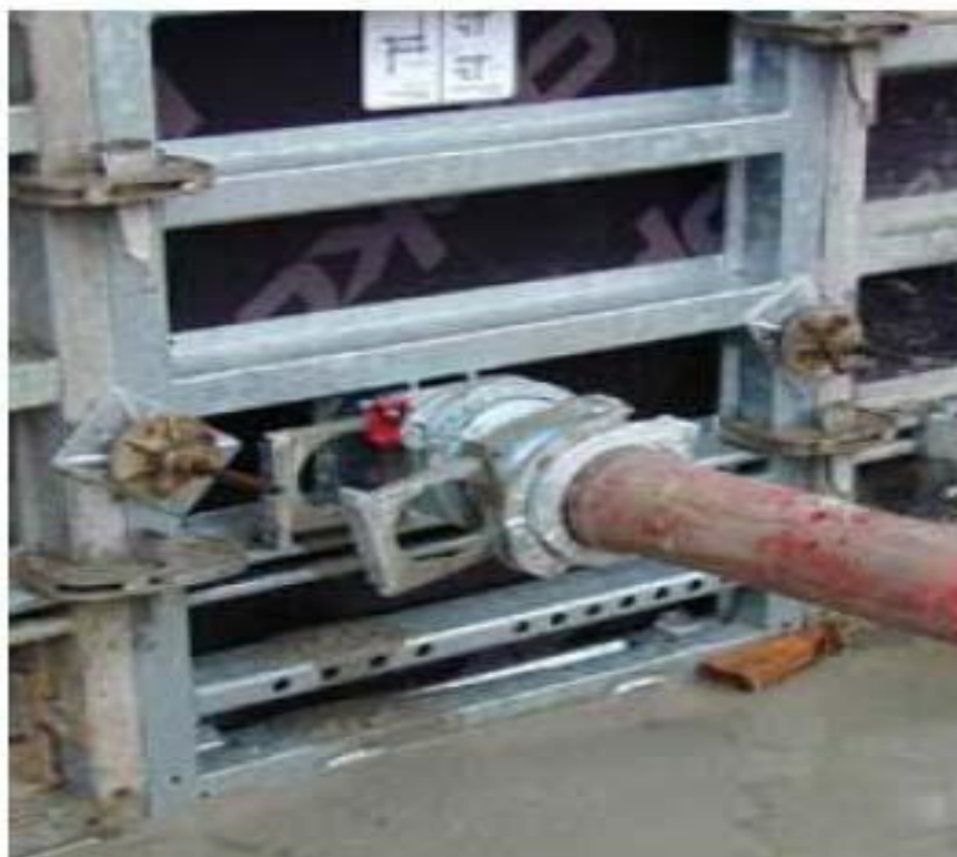
Εικόνα 3.16: Σύνδεση σωλήνα με το κατώτατο τμήμα του ξυλοτύπου.
