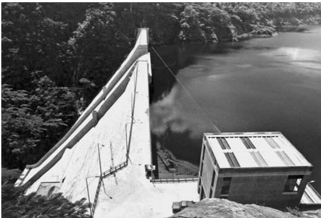
Εικόνα 4.3. Φράγμα Miel I Dam στην Κολομβία
