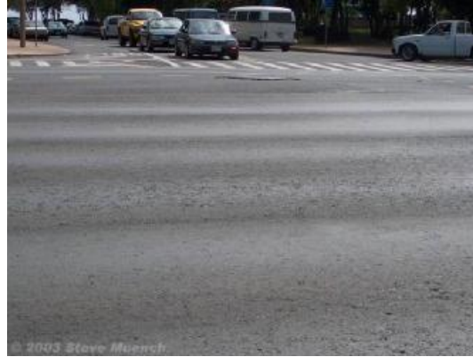
Σχήμα 33. Αυλακώσεις στις τροχιές των τροχών
