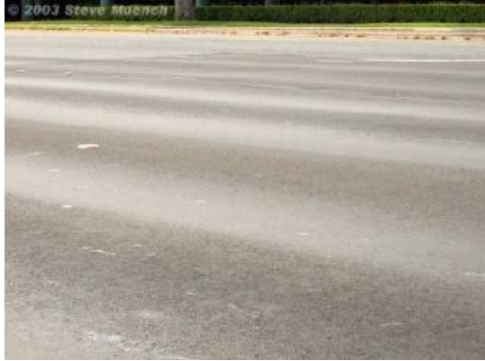
Σχήμα 33. Αυλακώσεις στις τροχιές των τροχών
