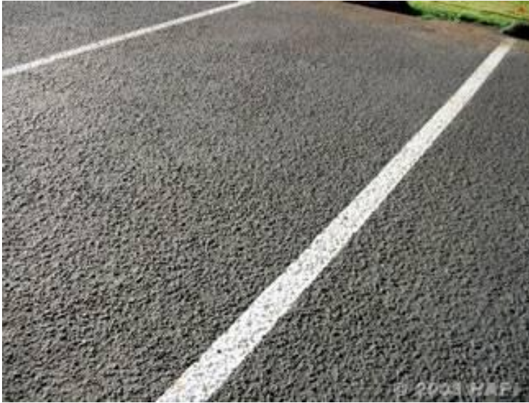
Σχήμα 46. Τάπητας slurry seal
