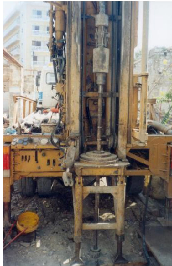
Γεώτρηση στη θέση 1 και το μηχάνημα έτοιμο να εκτελέσει δοκιμή STP.
