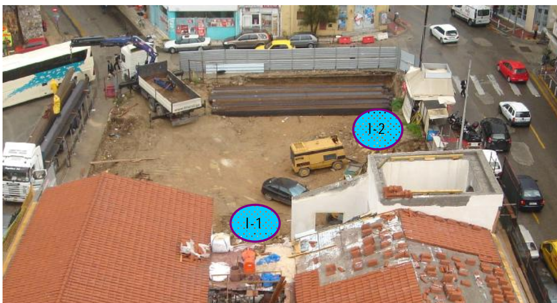
Σχ.7-1 Θέσεις των 2 αποκλισιομετρικών σωλήνων (I-1, I-2)
