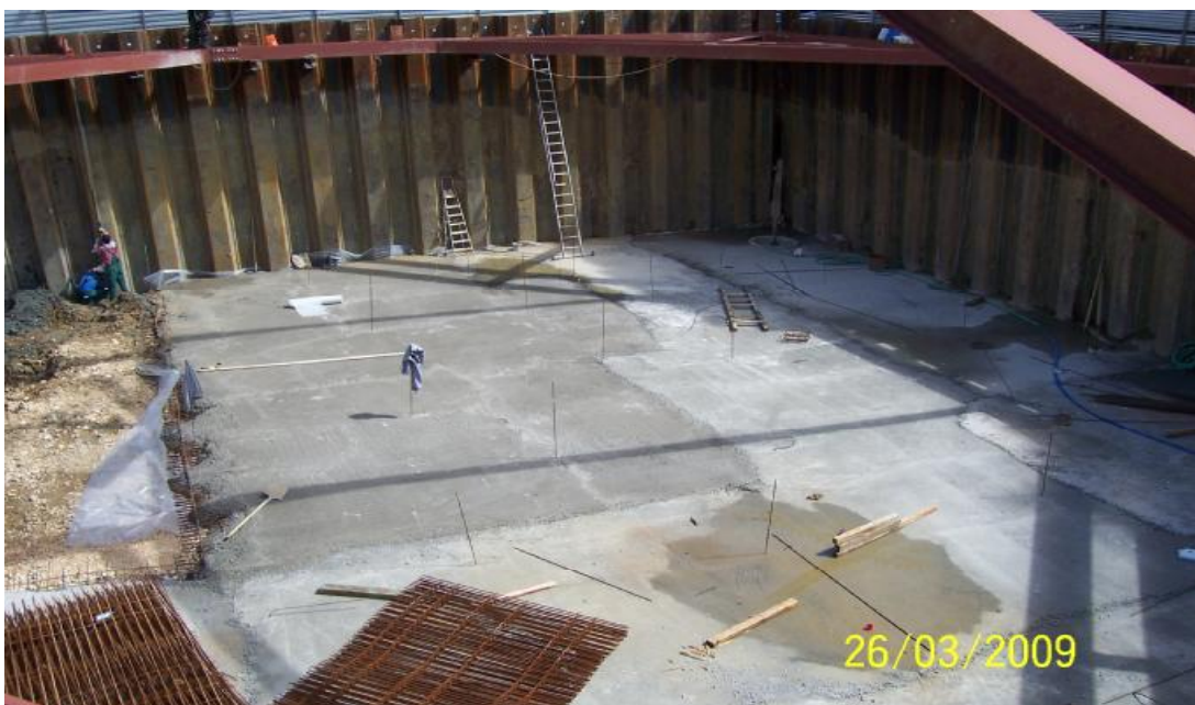
Σχ 4-12 Τμηματική σκυροδέτηση πρόπλακας
