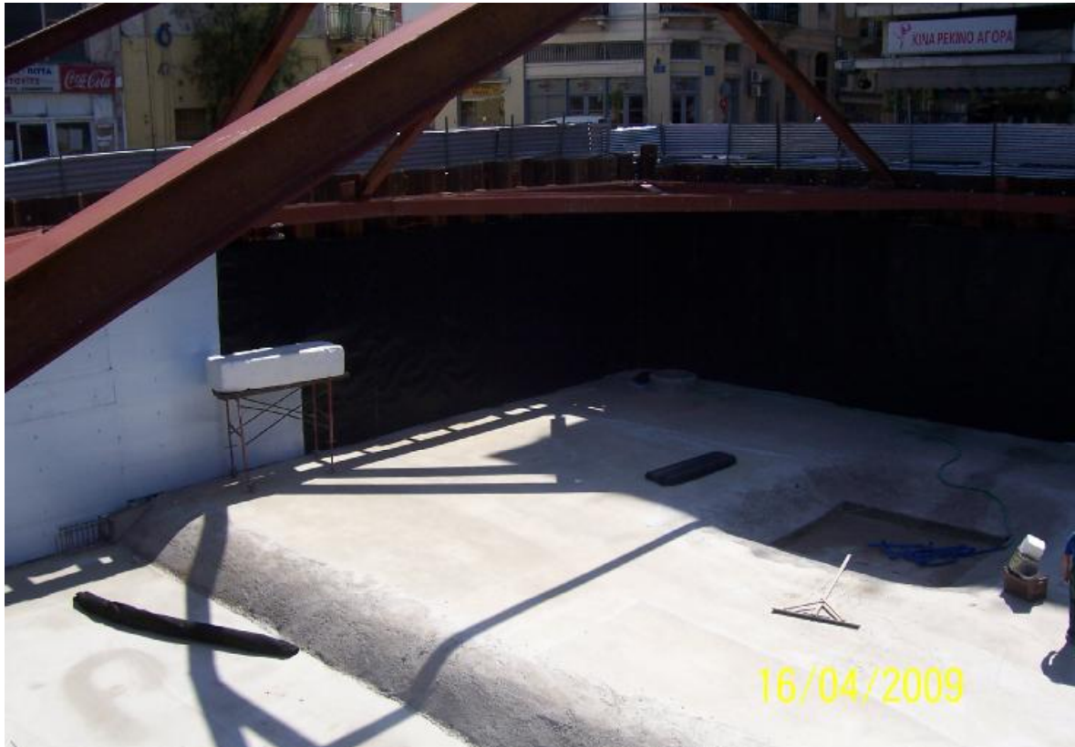
Σχ.6-5 Σκυροδέτηση μιας πλευράς
