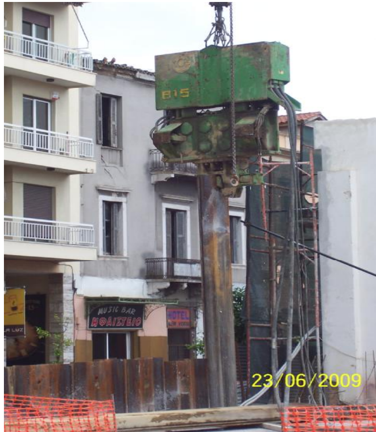
Σχ.5-4 Εξόλκυση πασσαλοσανίδας
