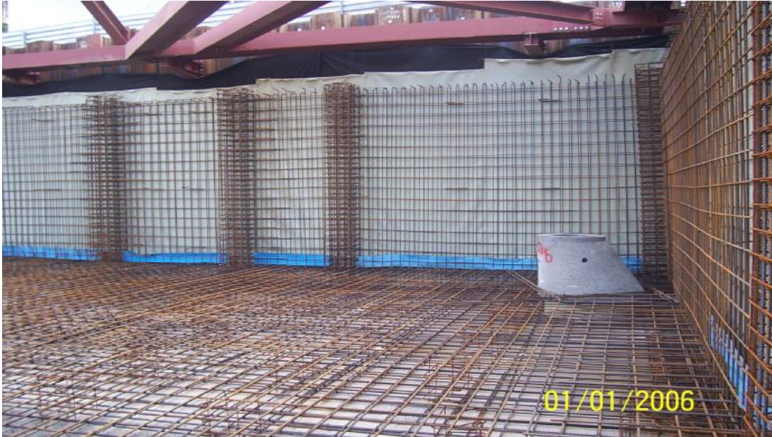
Σχ.4-11 Όπλιση τοιχείων υπογείου
