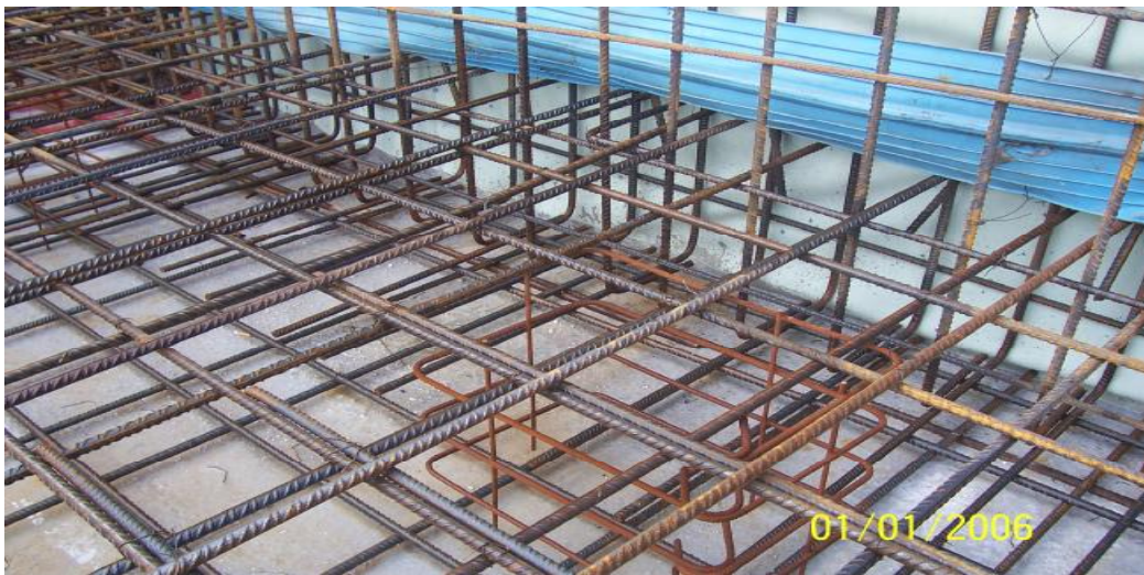
Σχ.4-9 Οπλισμός πλάκας με διπλή εσχάρα Φ12/20
