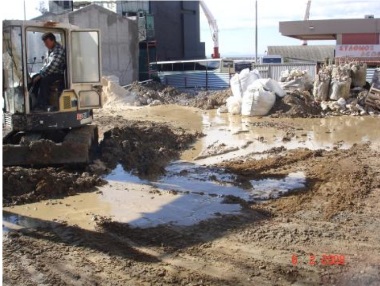
Αρχική κατάσταση στο έργο και ξεκίνημα εκτέλεσης εργασιών
