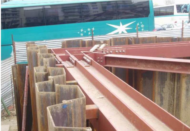
Συναρμολόγηση μεταλλικού σκελετού
