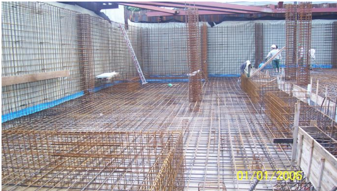
Σχ.6-9 Όπλιση πλάκας και υπόγειων τοιχείων
