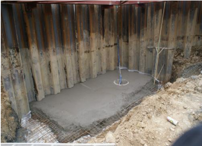
Τμηματική εκσκαφή και σκυροδέτηση
