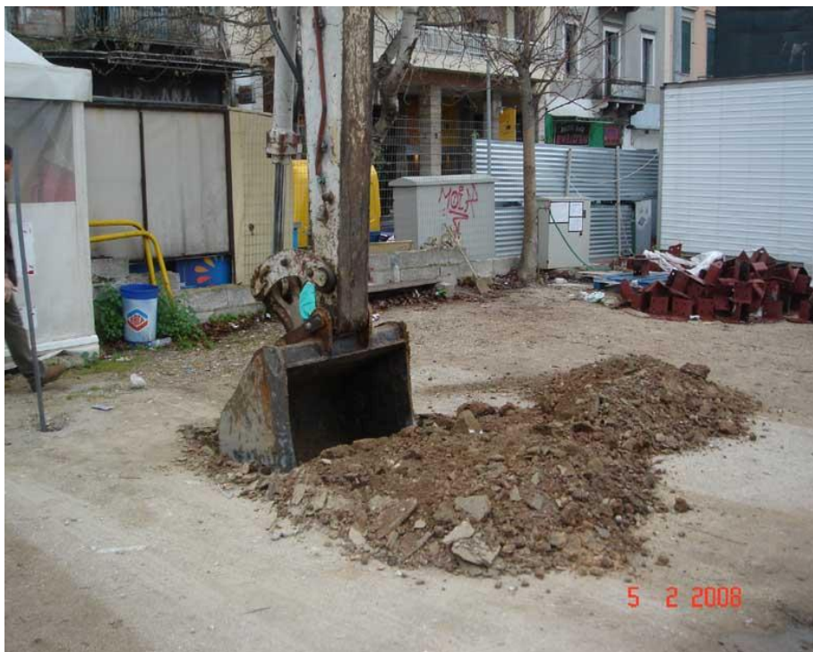
Εκτέλεση των δύο Δοκιμαστικών Ορυγμάτων ΔΟ-1 και ΔΟ-2, αντίστοιχα
