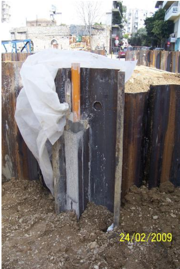
Τοποθέτηση αποκλισιομέτρου
