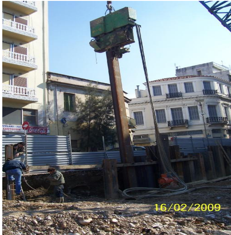
Σχ.5-3 Έμπηξη πασσαλοσανίδας
