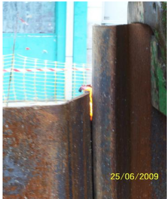
Λιώσιμο των πασσαλοσανίδων κατά την εξόλκηση λόγω μεγάλων τριβών που αναπτύσσονται
