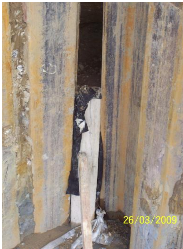
Σχ.5-5 Κενά μεταξύ πασσαλοσανίδων
