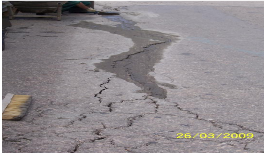
Σχ 8-3 Πλήρωση ρωγμών
