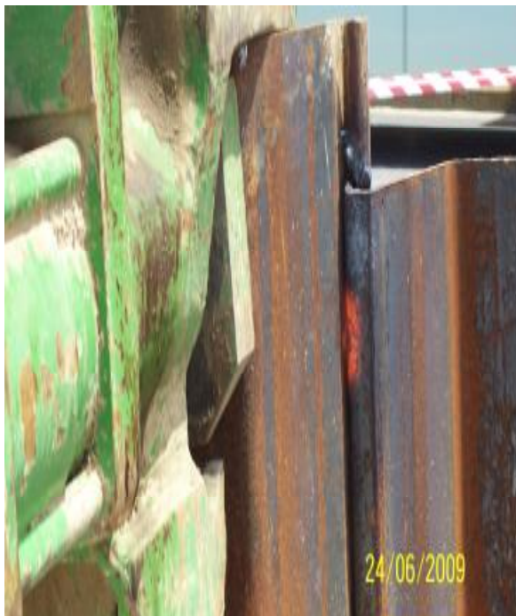
Λιώσιμο των πασσαλοσανίδων κατά την εξόλκηση λόγω μεγάλων τριβών που αναπτύσσονται
