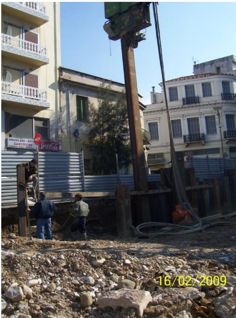
Διαδικασία έμψηξης πασσαλοσανίδων
