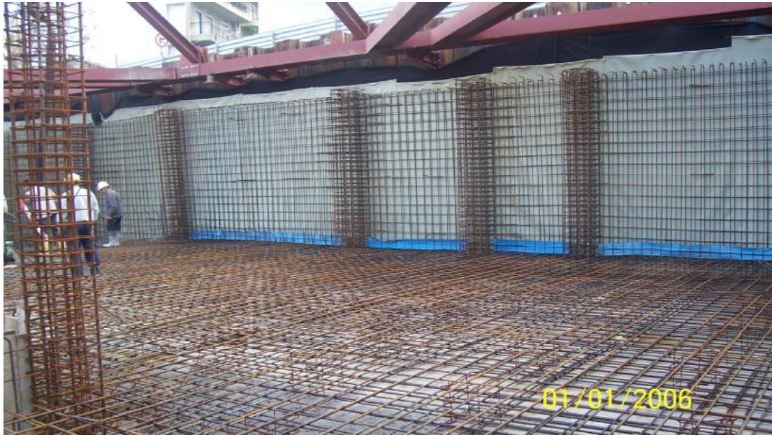
Σχ.6-8 Όπλιση πλάκας και υπόγειων τοιχείων
