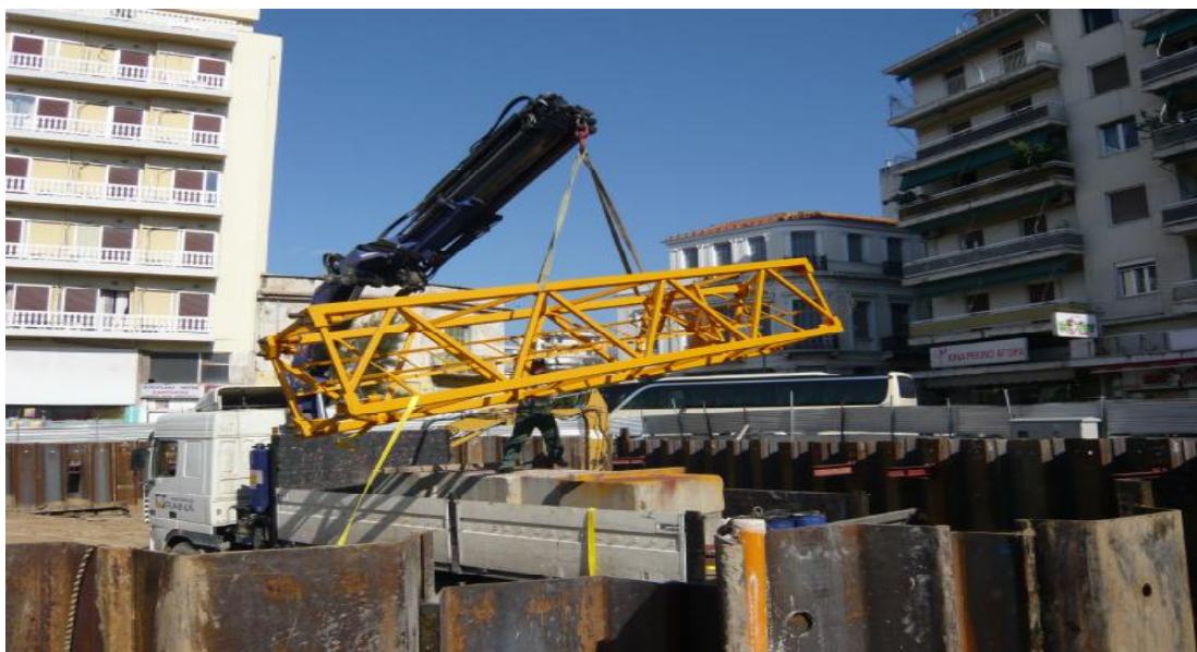
Σχ 8-8 Συναρμολόγηση πυργογερανού
