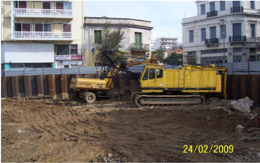
Εκσκαφές εντός του σκάμματος
