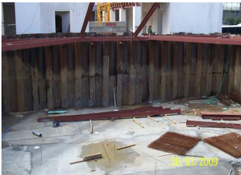
Τμηματική σκυροδέτηση της πρόπλακας που την υποδηλώνουν οι χαλύβδινες ράβδοι
