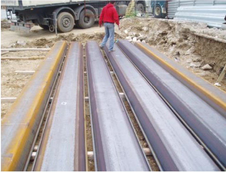
Μεταφορά πασσάλων στο εργοτάξιο
