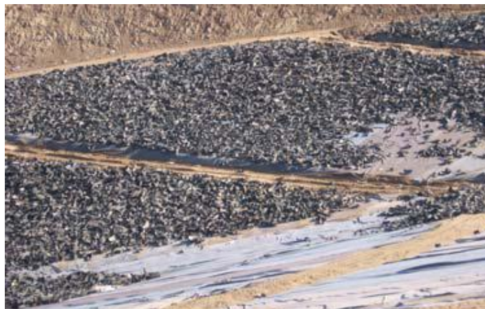
Εικόνα 14: Εφαρμογή τεμαχισμένων ελαστικών ως αποστραγγιστικό υλικό στον ΧΥΤΑ Αίγειρος.
