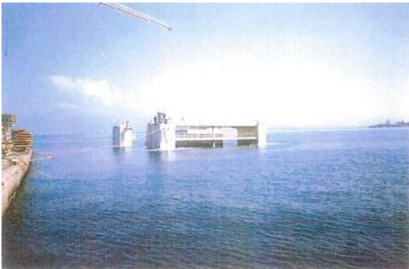
Κατασκευή προκατασκευασμένων κιβωτιών (caissons)
