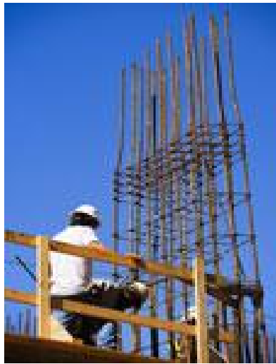
Φωτογραφία εργαζόμενου σε εργασίες μόρφωσης ξυλοτύπου οικοδομής
