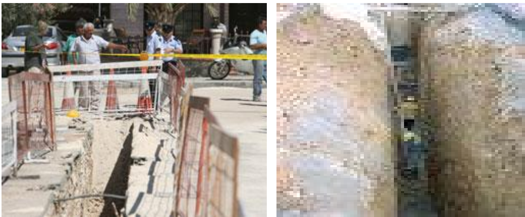
Φωτογραφίες από φρεάτιο και τάφρο αντίστοιχα.
