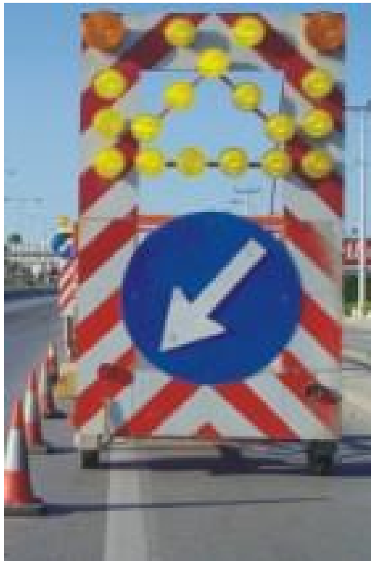
Προειδοποιητική μετακινούμενη πινακίδα υποχρεωτικής αριστερής πορείας, για τη διευθέτηση κυκλοφορίας οχημάτων εξαιτίας έργων οδοποιίας
