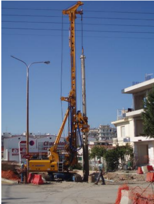
εικ. Τοποθέτηση πασσάλων
