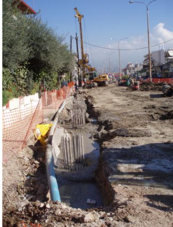
εικ. Σκυροδέτηση πασσάλων
