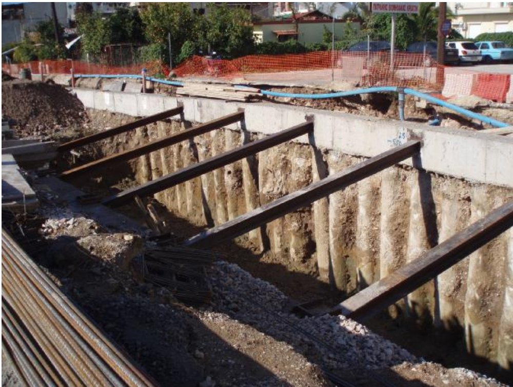
εικ. Πασσαλοστοιχίες και αντιρίδες
