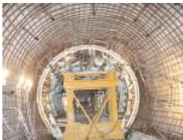
Χρήση μεταλλικού πλέγματος
