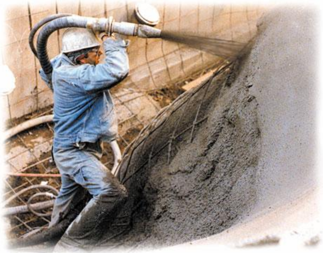
Εκτοξευόμενο Σκυρόδεμα
