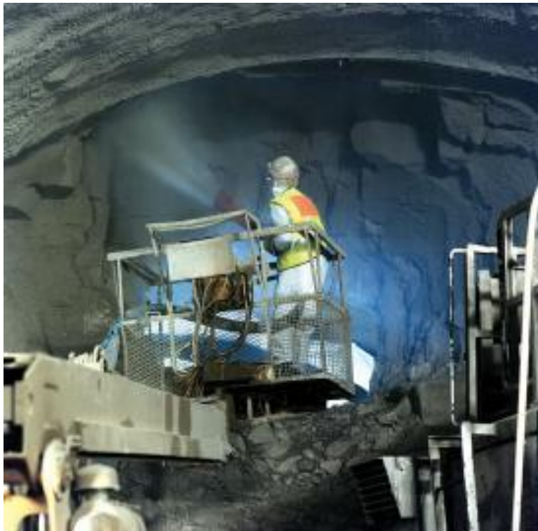
Εκτοξευόμενο Σκυρόδεμα
