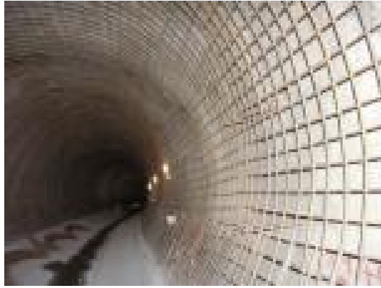
Χρήση μεταλλικού πλέγματος
