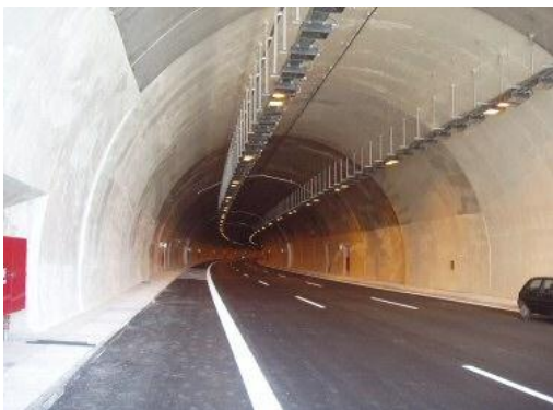
Σήραγγα Οδικού Δικτύου
