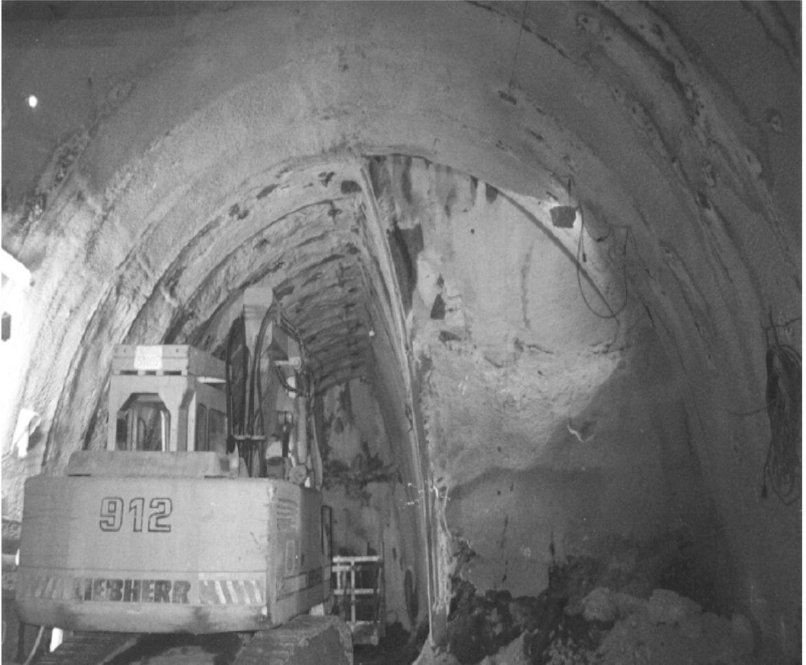
Υποστήριξη με χαλύβδινα πλαίσια.
