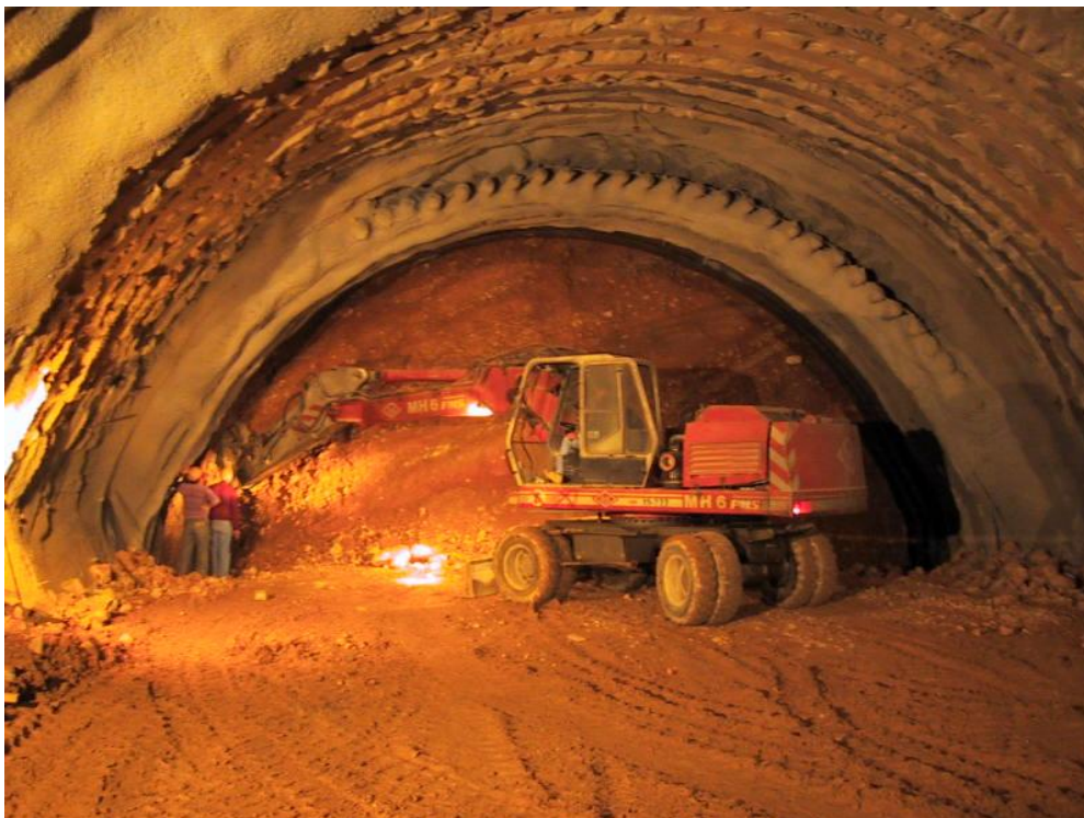
Διάνοιξη τμήματος σήραγγας με χρήση υδραυλικής σφύρας
