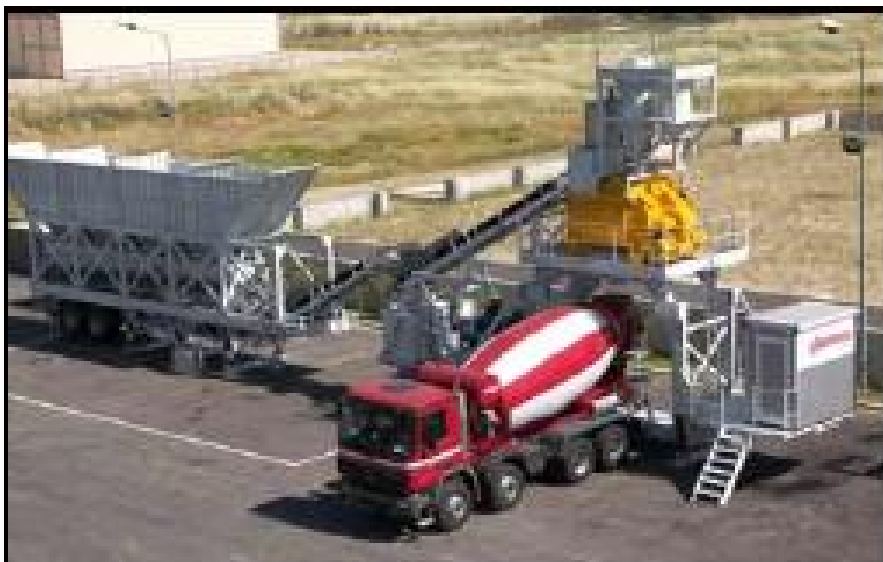
Κινητό συγκρότημα παραγωγής έτοιμου σκυροδέματος σε λειτουργία
