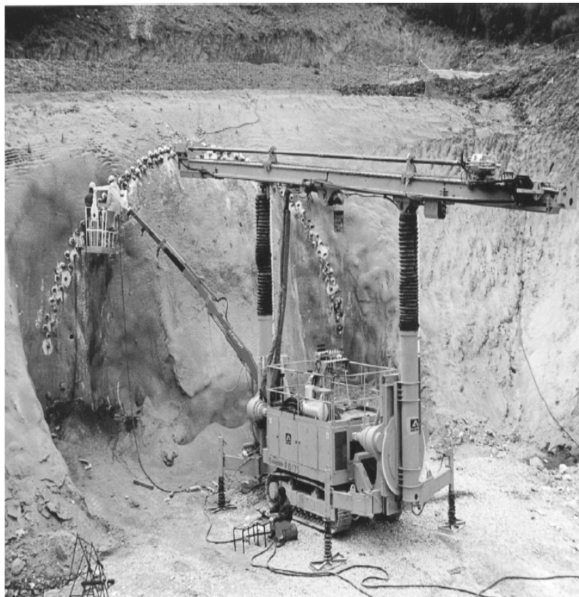
Διέλευση κάτω από κτίρια με τη μέθοδο των δοκών προπορείας
