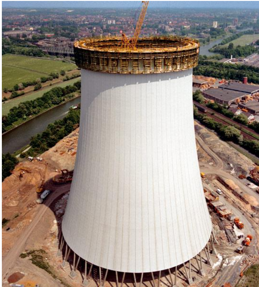
Ξυλότυπος SK175 για πύργους ψύξεως της εταιρείας Doka.
