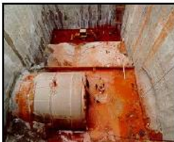
Μετρό της Αθήνας - το μηχάνημα ΕΡΒ στο Φρέαρ Αγ. Παρασκευής
