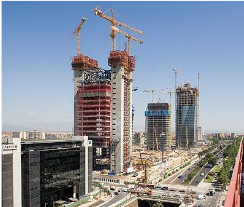
Κατασκευή ουρανοξύστη με χρήση αναρριχόμενου ξυλότυπου
