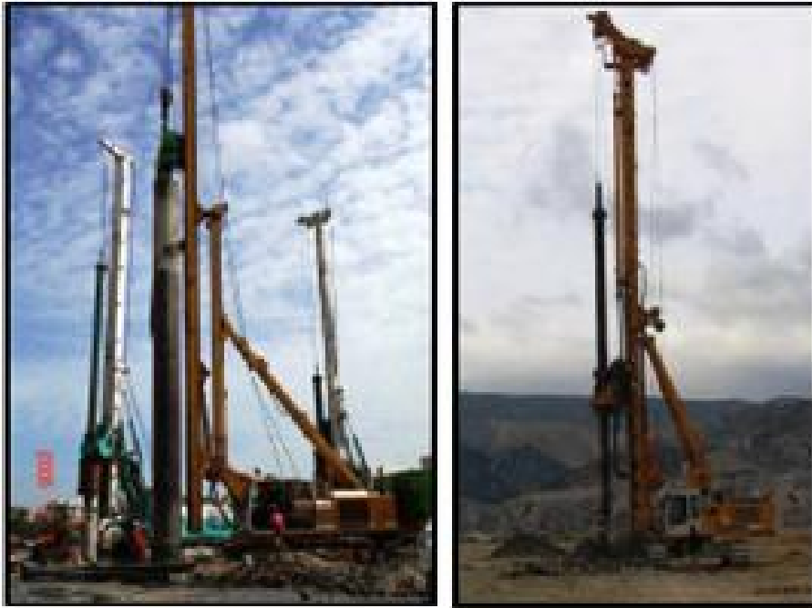
Διατρητικά Μηχανήματα Έμμηξης πασσάλων
