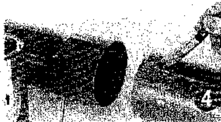
5. Εισαγωγή του ευθείου άκρου στη μούφα
