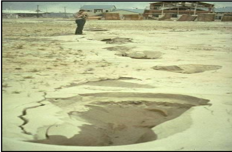
Εδαφικές βαθύνσεις στη Niigata της Ιαπωνίας που παρατηρήθηκαν αμέσως μετά το σεισμό της 16ης Ιουνίου 1964 (Steinbrugge Collection, E.E.R.C., University of California, Berkeley)
