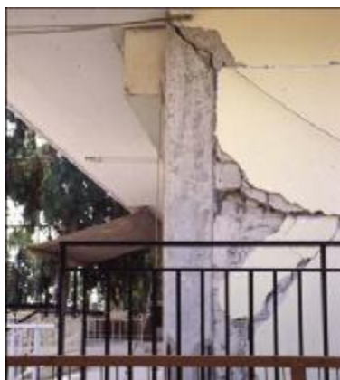
Διαγώνια ρηγμάτωση εξωτερικού κόμβου με μείωση ακαμψίας του
