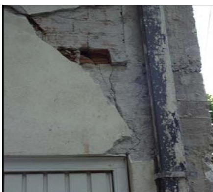
Ανεπαρκής αγκύρωση πάνω & κάτω ράβδων δοκού
