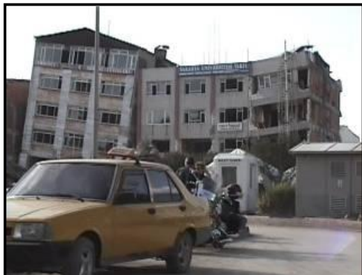
Βλάβες σε κτίρια λόγω ρευστοποίησης εδάφους από τους σεισμούς του Kobe (αριστερά) στην Ιαπωνία (17.1.1995, M=6.9 ) και του Izmit (δεξιά) στη Τουρκία (17.8.1999, M=7.5 ) (System and Data Research Co.,Ltd.).
