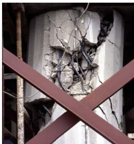
Οι διατμητικές αστοχίες οφείλονται σε ανεπάρκεια των συνδετήρων / εγκάρσιων συνδέσμων σε μέγεθος διαμέτρου, πυκνότητα και αντοχή
