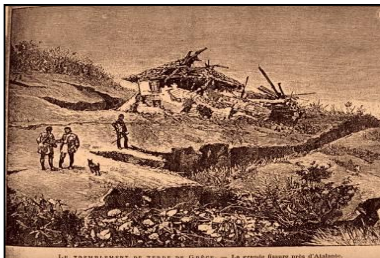
LE TREMBLEMENT DE TERRE DE GRÈCE. — La grande fissure près d'Atalante.
