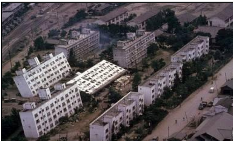
Αποτελέσματα της ρευστοποίησης του εδάφους σε κατασκευές της πόλης Niigata της Ιαπωνίας, λόγω του σεισμού της 16ης Ιουνίου 1964 με μέγεθος M=7.5 (Steinbrugge Collection, E.E.R.C., University of California, Berkeley).
