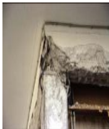
Διαγώνια ρηγμάτωση εξωτερικού κόμβου με μείωση ακαμψίας του
