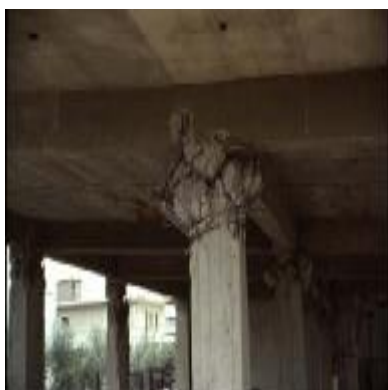
Διατμητική αστοχία πάνω άκρου υποστυλωμάτων λόγω απουσίας συνδετήρων. Ο μανδύας συνδετήρων έφτανε μέχρι 0.50 m κάτω από τις δοκούς
