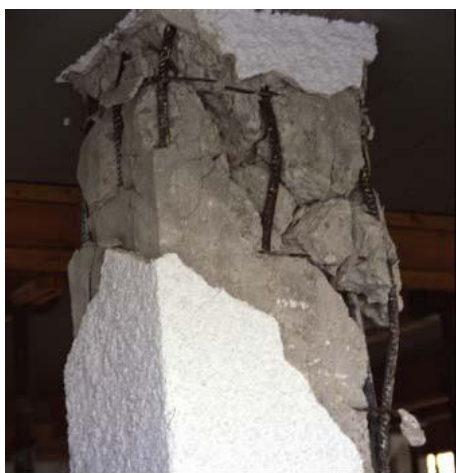
Οι διατμητικές αστοχίες οφείλονται σε ανεπάρκεια των συνδετήρων / εγκάρσιων συνδέσμων σε μέγεθος διαμέτρου, πυκνότητα και αντοχή
