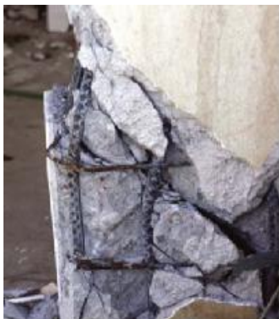
Άνοιγμα συνδετήρων με κάμψη άκρων κατά 90^\circ μετά την αποφλοίωση της επικάλυψης των οπλισμών.
