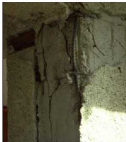
Άνοιγμα συνδετήρων με κάμψη άκρων κατά 90^\circ μετά την αποφλοίωση της επικάλυψης των οπλισμών.
