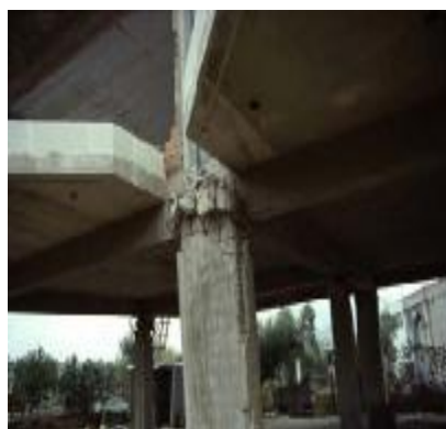
Διατμητική αστοχία πάνω άκρου υποστυλωμάτων λόγω απουσίας συνδετήρων. Ο μανδύας συνδετήρων έφτανε μέχρι 0.50 m κάτω από τις δοκούς
