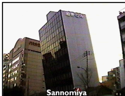
Βλάβες σε κτίρια λόγω ρευστοποίησης εδάφους από τους σεισμούς του Kobe (αριστερά) στην Ιαπωνία (17.1.1995, M=6.9 ) και του Izmit (δεξιά) στη Τουρκία (17.8.1999, M=7.5 ) (System and Data Research Co.,Ltd.).
