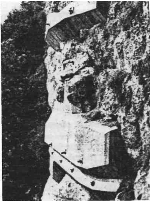
Φωτ.5 Βελτίωση της ευστάθειας κατακόρυφου πρανούς με σύστημα προεντεταμενων αγκυριών εφαρμοσμένων σε στοιχεία οπλισμένου σκυροδέματος, περιοχή Αμβούργου Γερμανίας. (Muller, 1963)
