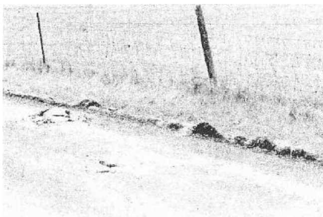
Σχήμα 3.38.: Μικρή διόγκωση παγετού σε εύκαμπτο οδόστρωμα.
