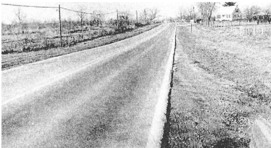
Σχήμα 3.41.: Εφίδρωση μιας ασφαλτικής επιφάνειας (δεξιά λωρίδα). Η συνθήκη αυτή είναι επικίνδυνη και μπορεί να προκαλέσει ολίσθηση.
