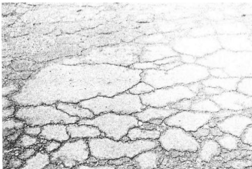
Σχήμα 3.33.: Ρωγμές με μορφή χάρτη ή αλλιγάτορα σε εύκαμπτο οδόστρωμα
