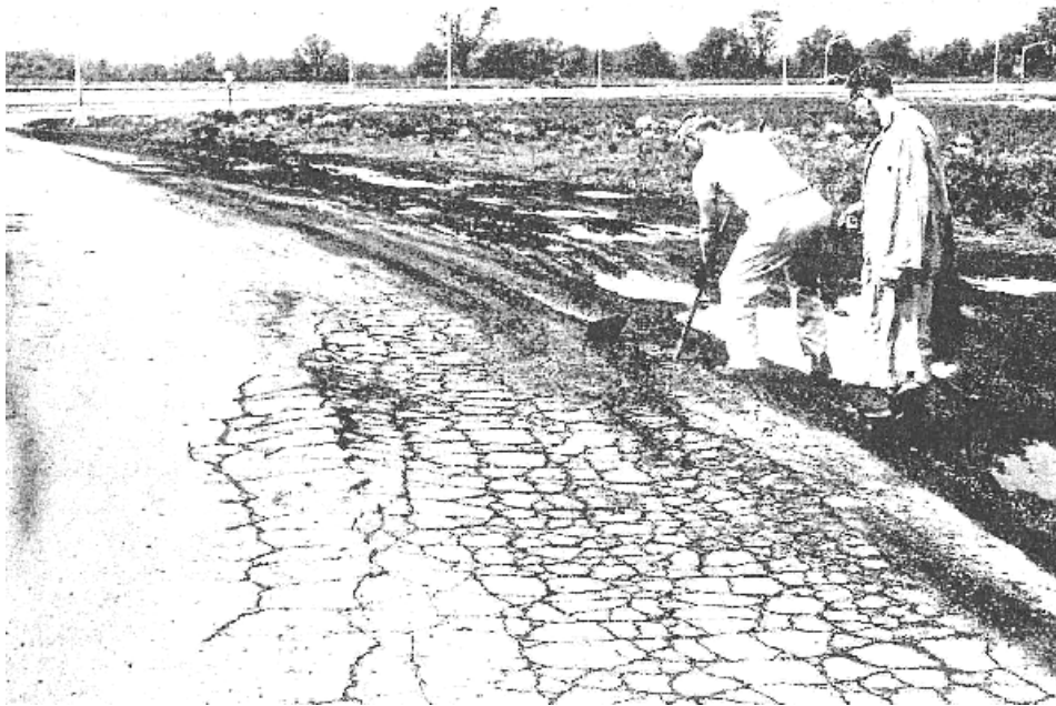
Σχήμα 3.36.: Αποτυχία σε διάτμηση στο άκρο οδοστρώματος. Αυτό το εύκαμπτο οδόστρωμα είναι έξοδος φορτηγών και στάση φορτηγών σε ένα κύριο αυτοκινητόδρομο. Σημειώνεται η σοβαρή ρηγμάτωση μορφής χάρτη
