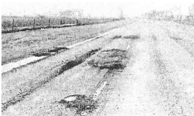
Σχήμα 3.39.: Αποτυχία εδάφους από ανοιξιάτικη τήξη.
