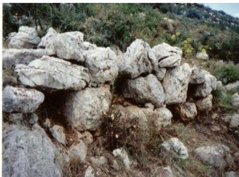
ΕΙΚΟΝΑ 3.ΣΤ-35,36 Μυκηναϊκή γέφυρα.
