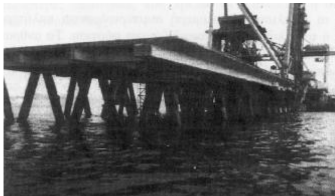
Ενίσχυση πασσάλων με σύνθετα υλικά ανθρακονημάτων στο Lamma Island Jetty του Χονγκ Κονγκ.
