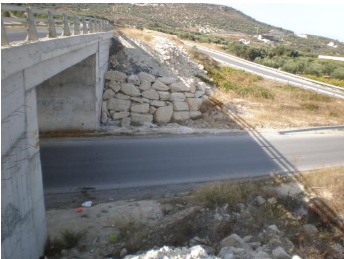
Φωτ. 6.10 Ανατολική πλευρά γέφυρας.
