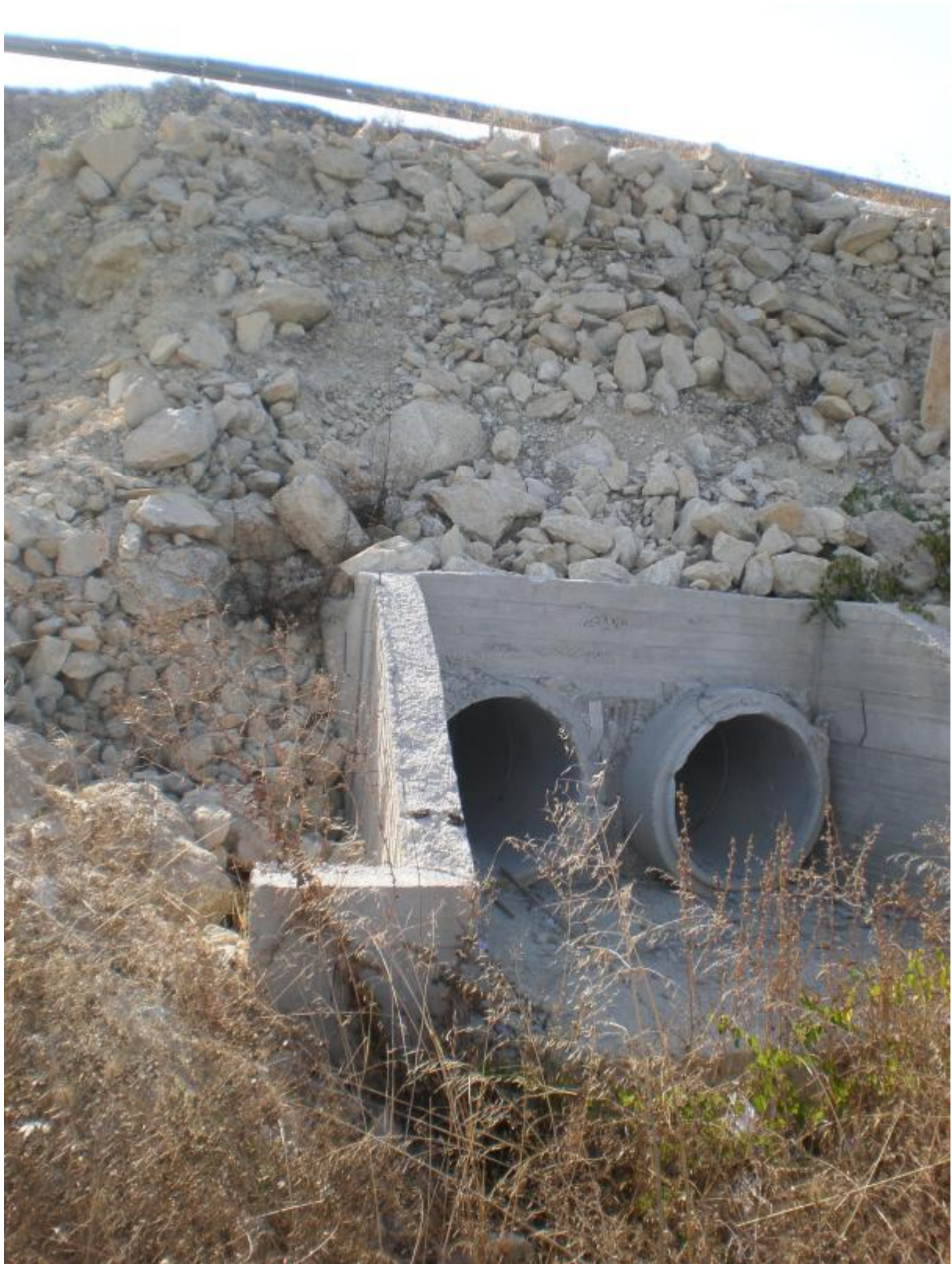
Φωτ. 6.23 Είσοδος δίδυμου σωληνωτού οχετού Φ100.
