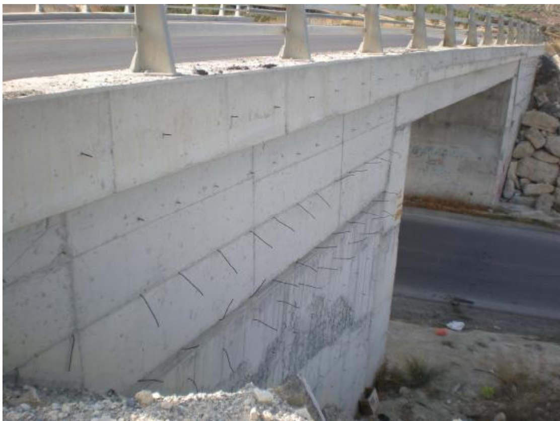
Φωτ. 6.9 Τοίχιο αντιστήριξης και φορέας γέφυρας από ανατολική πλευρά.
