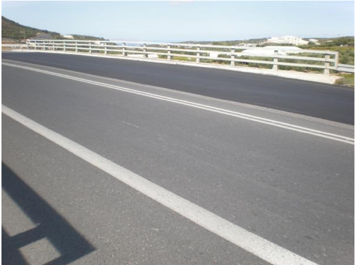
Φωτ. 6.22 Κατάστρωμα οδού πάνω από τη γέφυρα.
