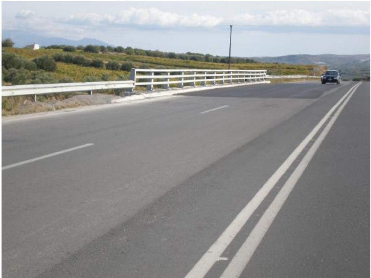
Φωτ. 6.22 Κατάστρωμα οδού πάνω από τη γέφυρα.
