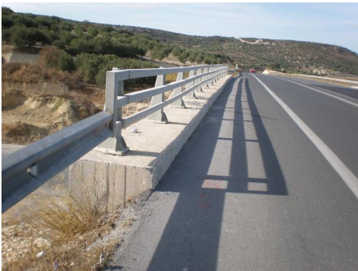
Φωτ. 6.20 Κατάστρωμα οδού πάνω από τη γέφυρα και μεταλλικά στηθαία ασφαλείας.
