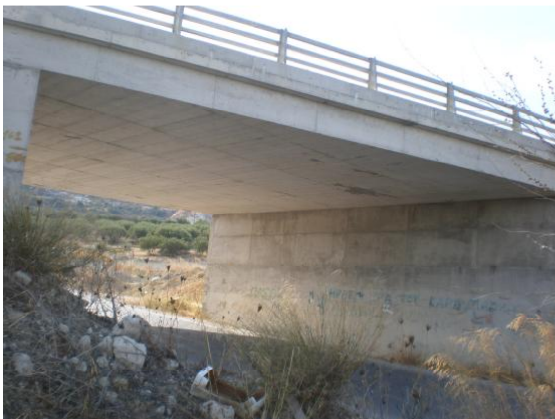
Φωτ. 6.8 Νότιο βάθρο και πλάκα (φορέας) της γέφυρας.
