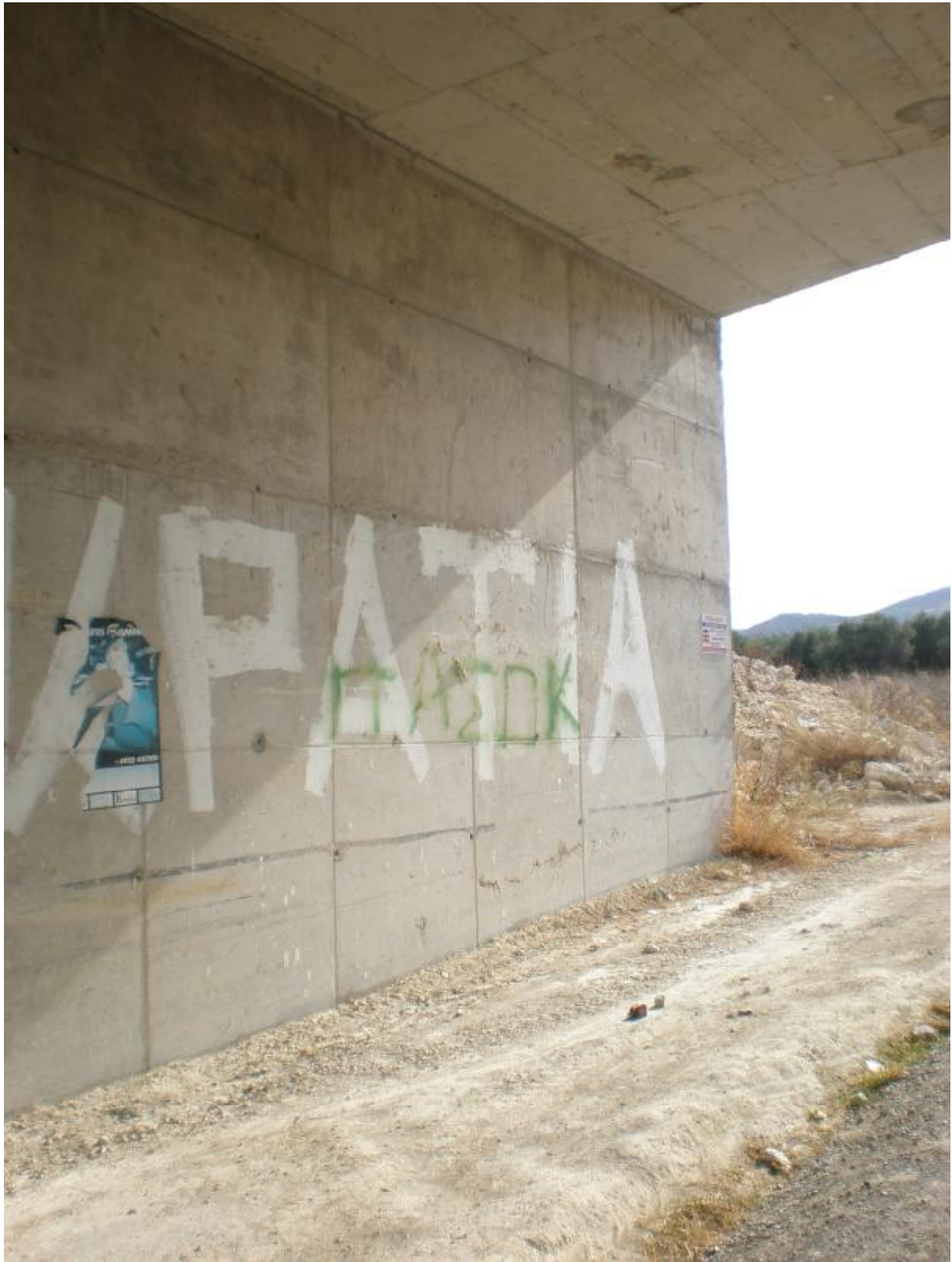
Φωτ. 6.9 Βάθρο της γέφυρας.
