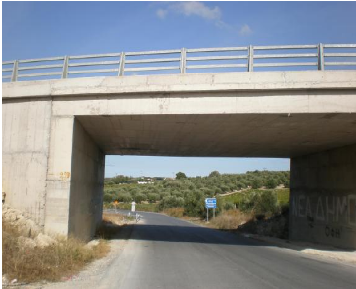
Φωτ. 6.1 Δυτική όψη γέφυρας.
