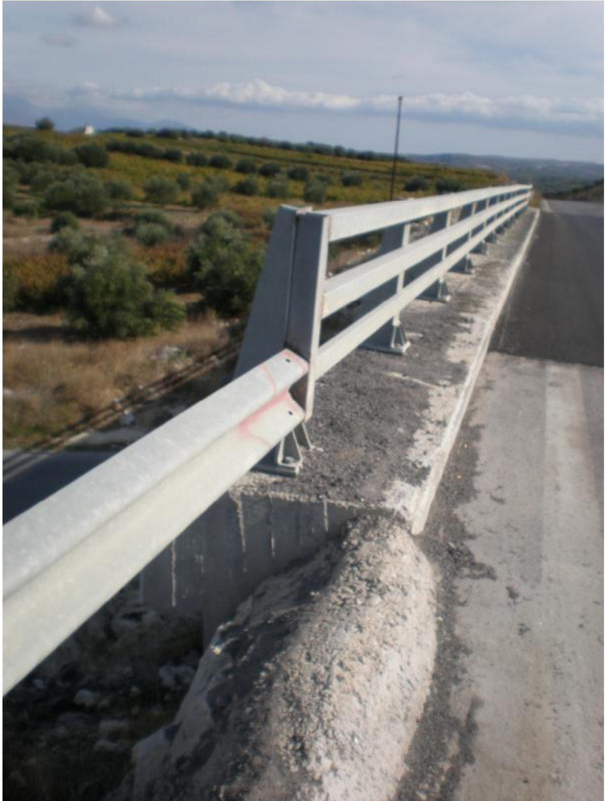
Φωτ. 6.18 Δυτική όψη στέψης γέφυρας με μεταλλικά στηθαία ασφαλείας.
