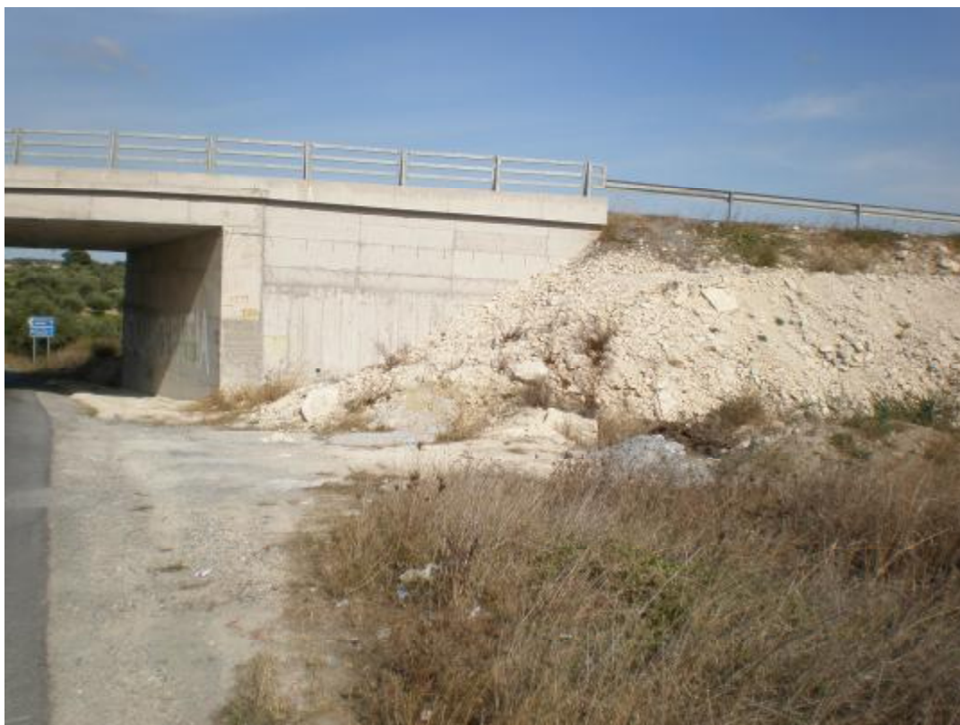
Φωτ. 6.7 Νοτιοδυτικό τοίχιο και νότιο βάθρο γέφυρας.
