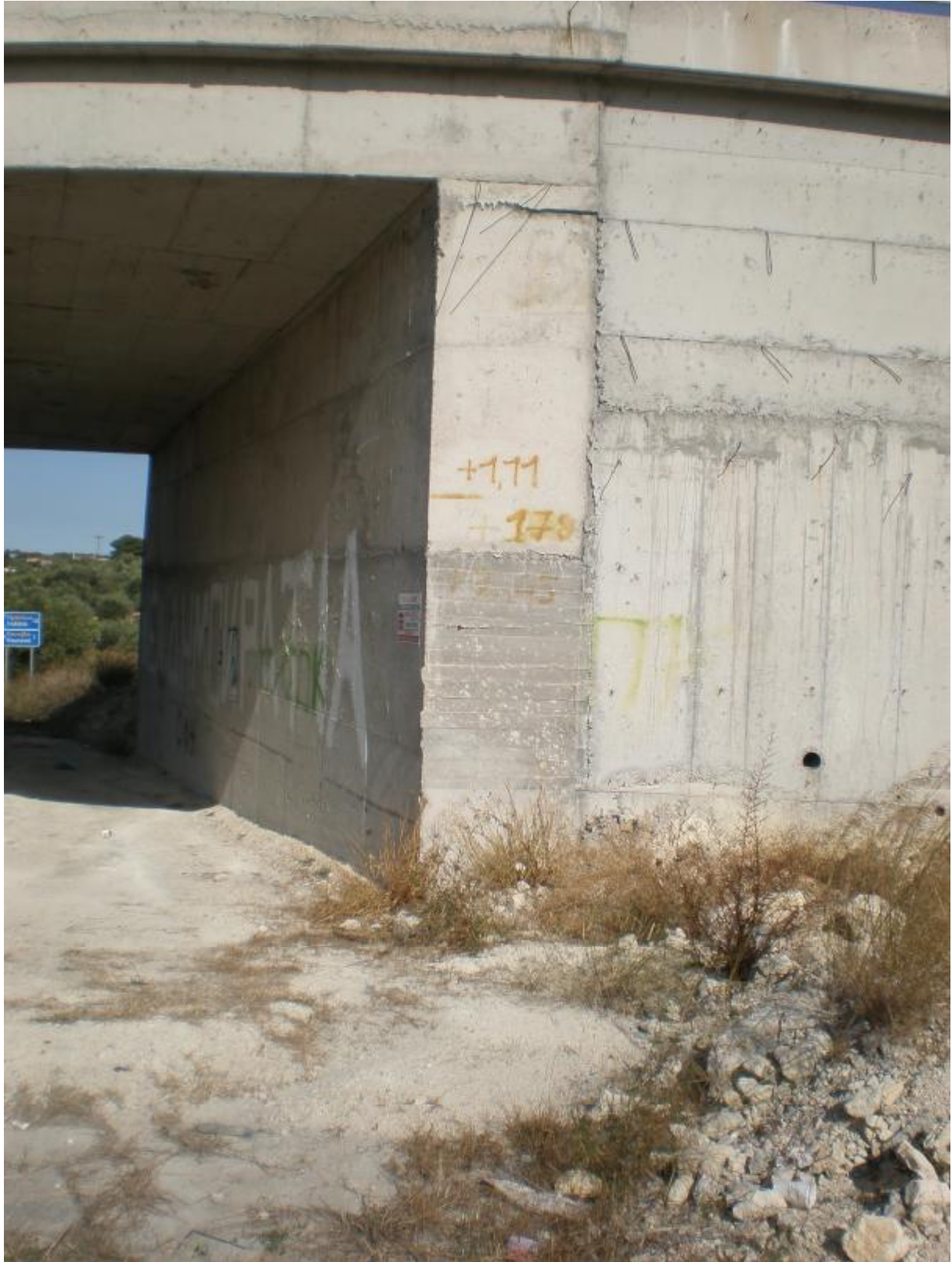
Φωτ. 6.6 Νοτιοδυτικό Τοιχίο Αντιστήριξης.
