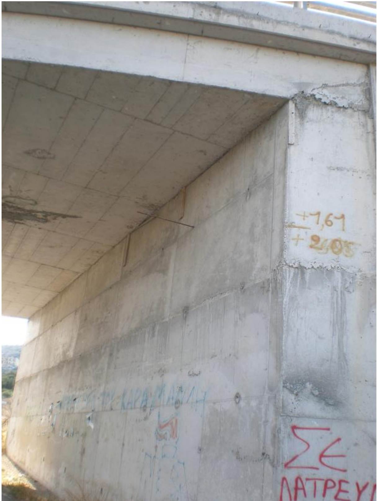
Φωτ. 6.13 Βόρειο ακρόβαθρο και πλάκα γέφυρας.
