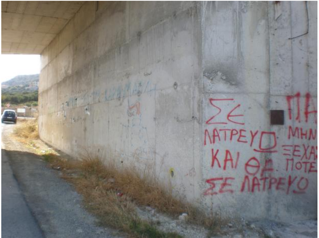
Φωτ. 6.12 Βόρειο βάθρο γέφυρας.
