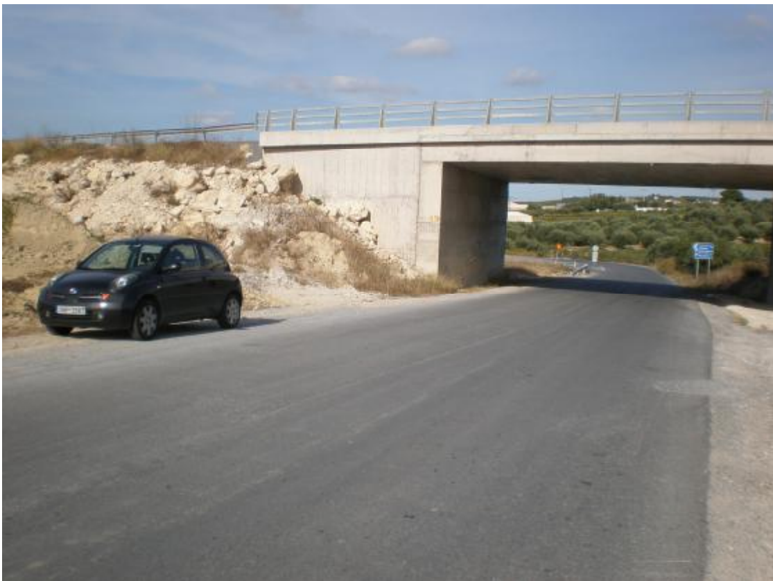
Φωτ. 6.3 Δυτική όψη γέφυρας.
