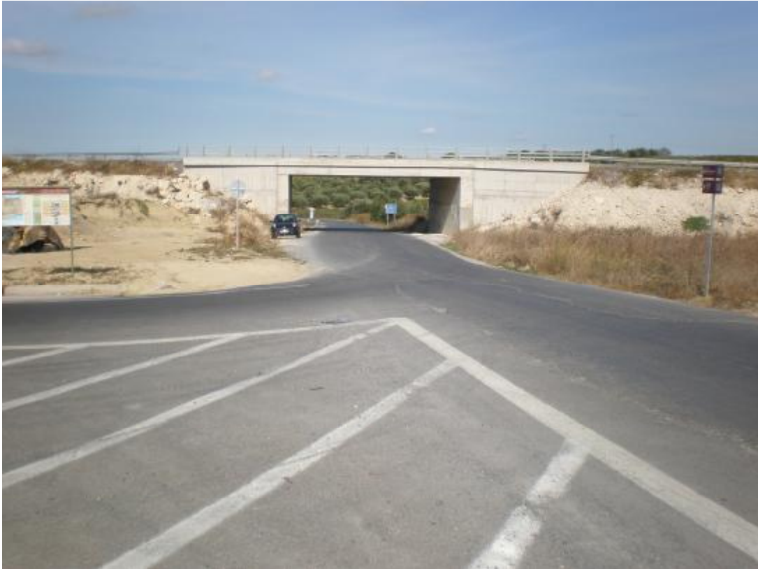
Φωτ. 6.2 Δυτική όψη γέφυρας.
