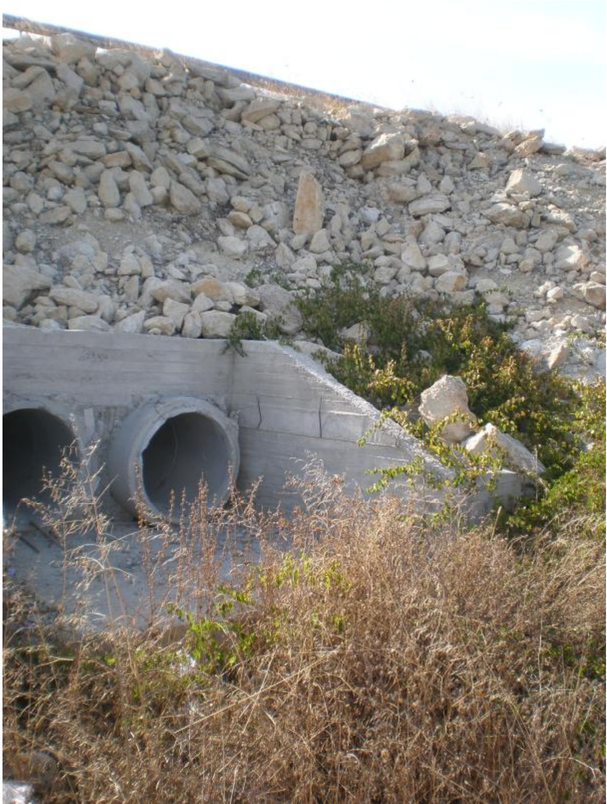
Φωτ. 6.24 Είσοδος δίδυμου σωληνωτού οχετού Φ100.
