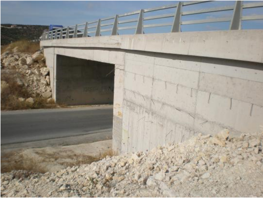
6.4 Δυτική όψη γέφυρας.
