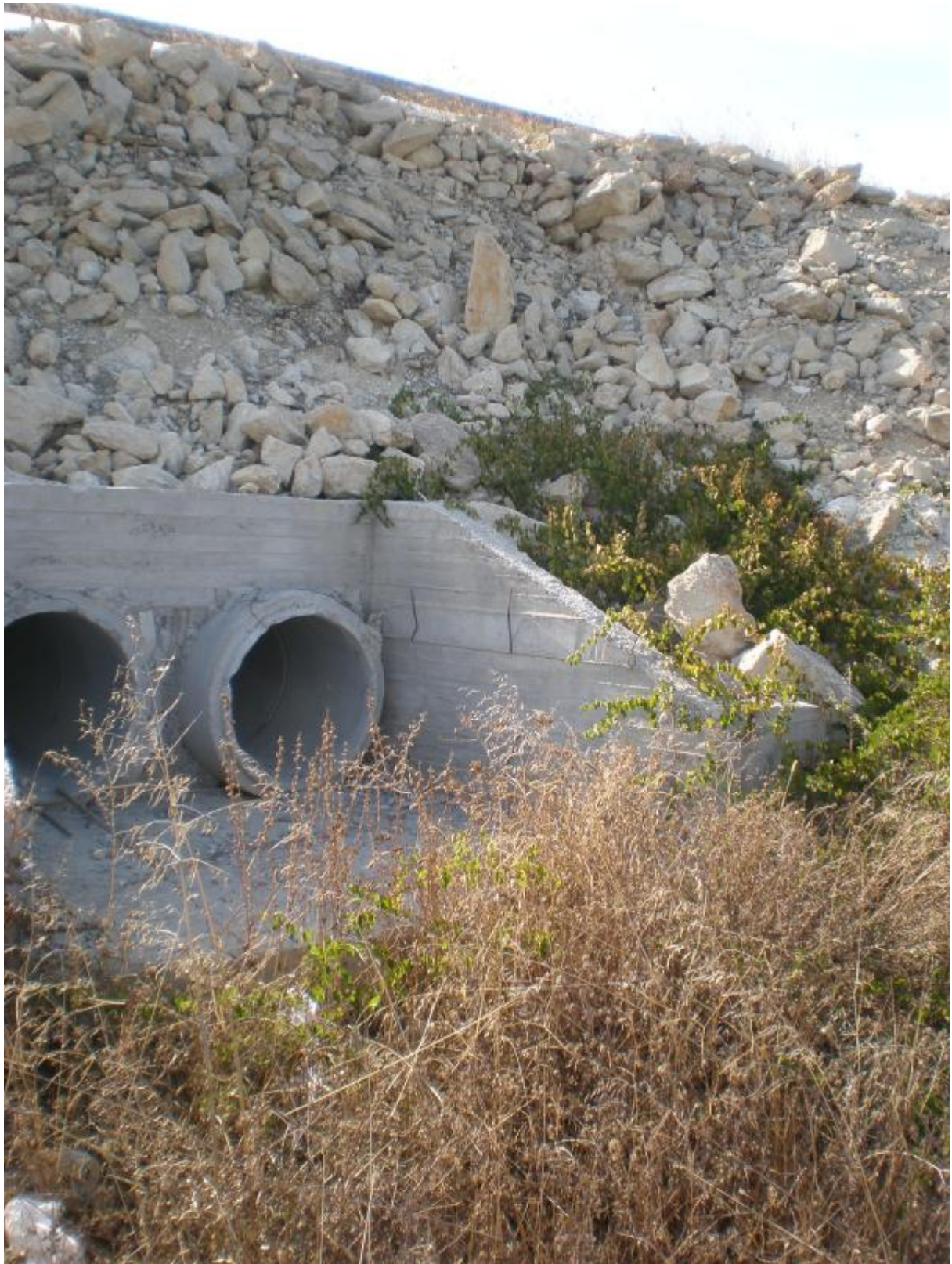
Φωτ. 6.25 Είσοδος δίδυμου σωληνωτού οχετού Φ100.
