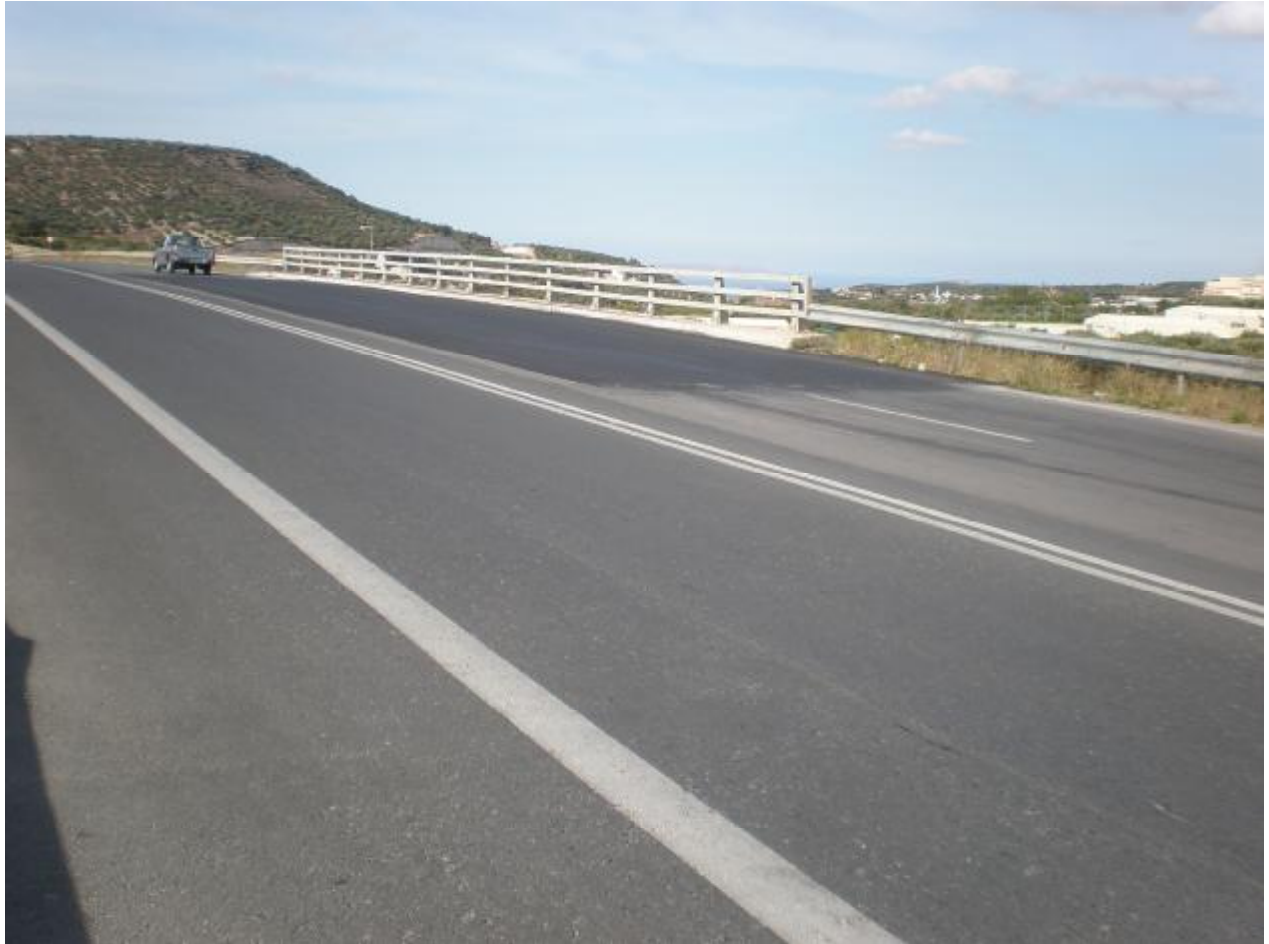
Φωτ. 6.21 Κατάστρωμα οδού πάνω από τη γέφυρα και μεταλλικά στηθαία ασφαλείας.
