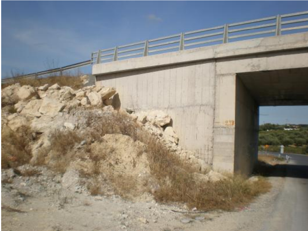
Φωτ. 6.15 Βορειοδυτικό τοίχιο αντιστήριξης.
