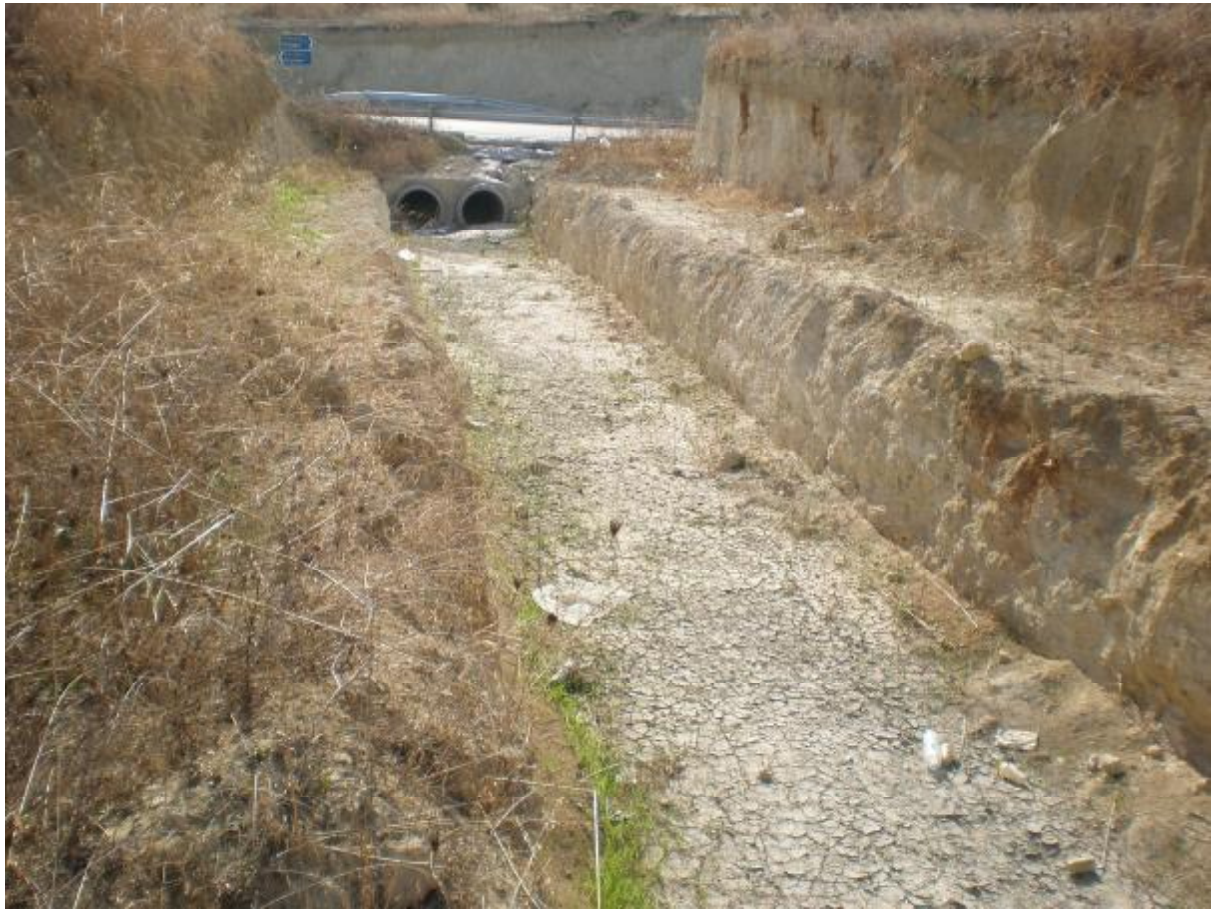
Φωτ. 6.28 Έξοδος-απορροή δίδυμου σωληνωτού οχετού Φ100.
