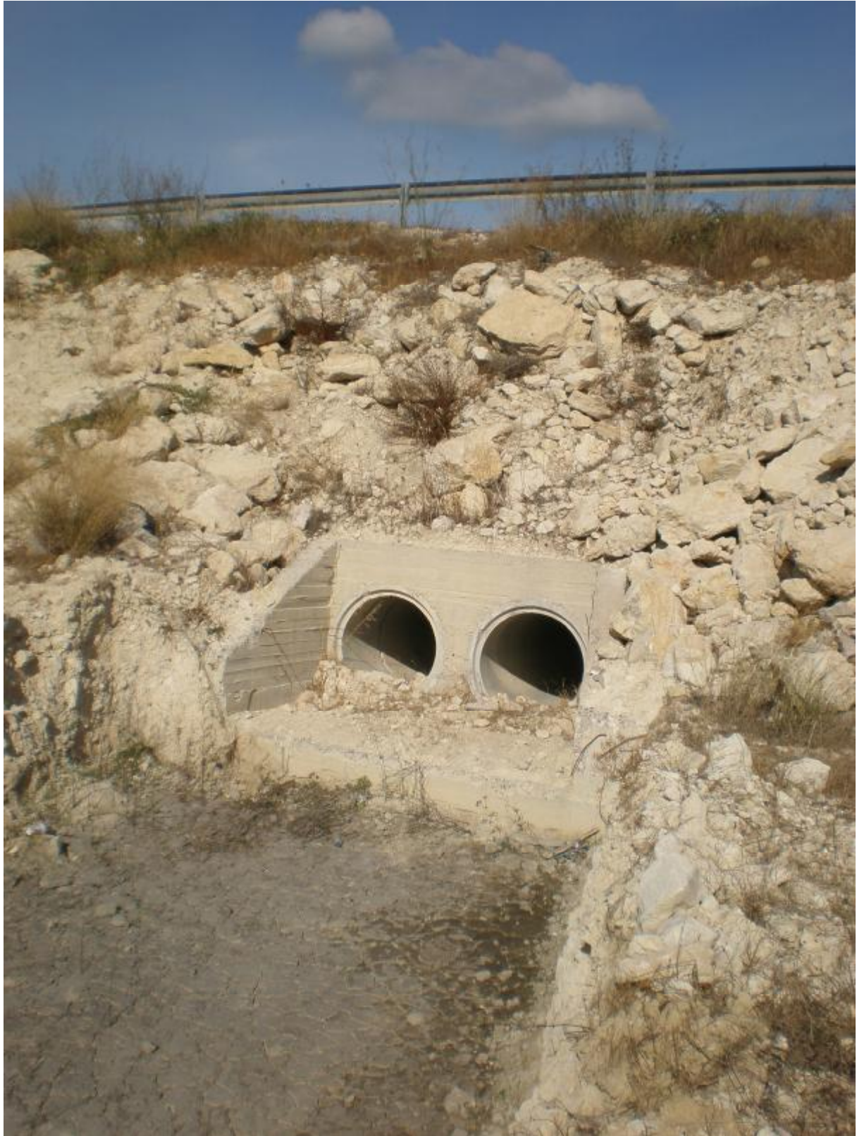
Φωτ. 6.27 Έξοδος-απορροή δίδυμου σωληνωτού οχετού Φ100.
