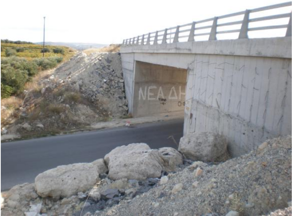
Φωτ. 6.8 Ανατολική όψη γέφυρας.
