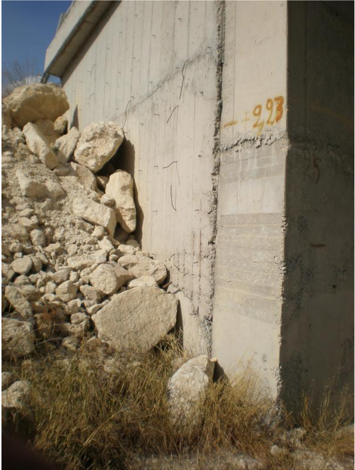
Φωτ. 6.14 Βόρειο βάθρο γέφυρας και βορειοδυτικό τοίχιο αντιστήριξης.
