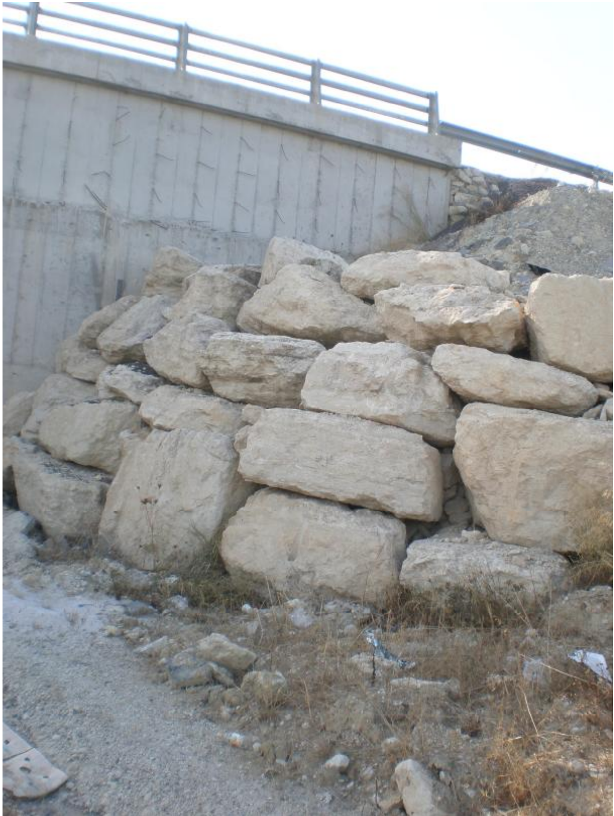
Φωτ. 6.17 Προστατευτική ξηρολιθοδομή με ογκόλιθους για στήριξη πρανούς.
