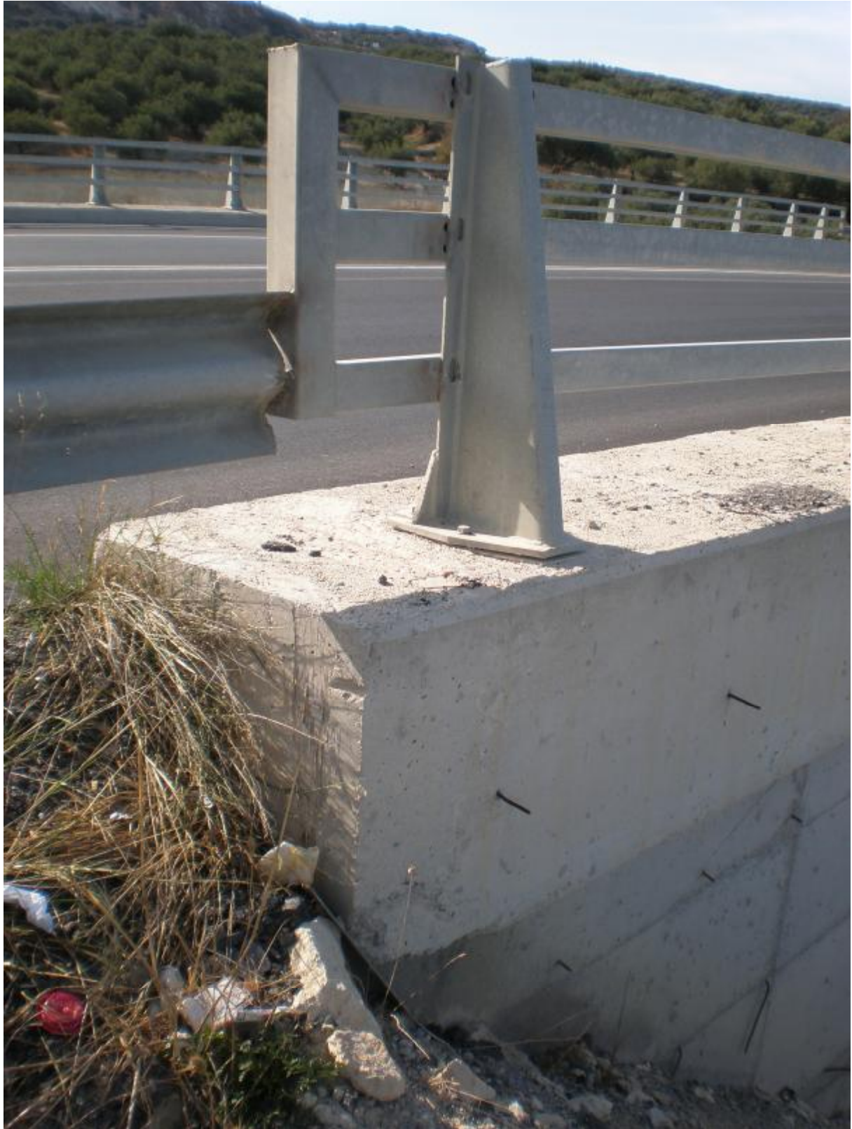
Φωτ. 6.19 Στέψη νοτιοανατολικού τοιχίου γέφυρας και μεταλλικά στηθαία ασφαλείας.
