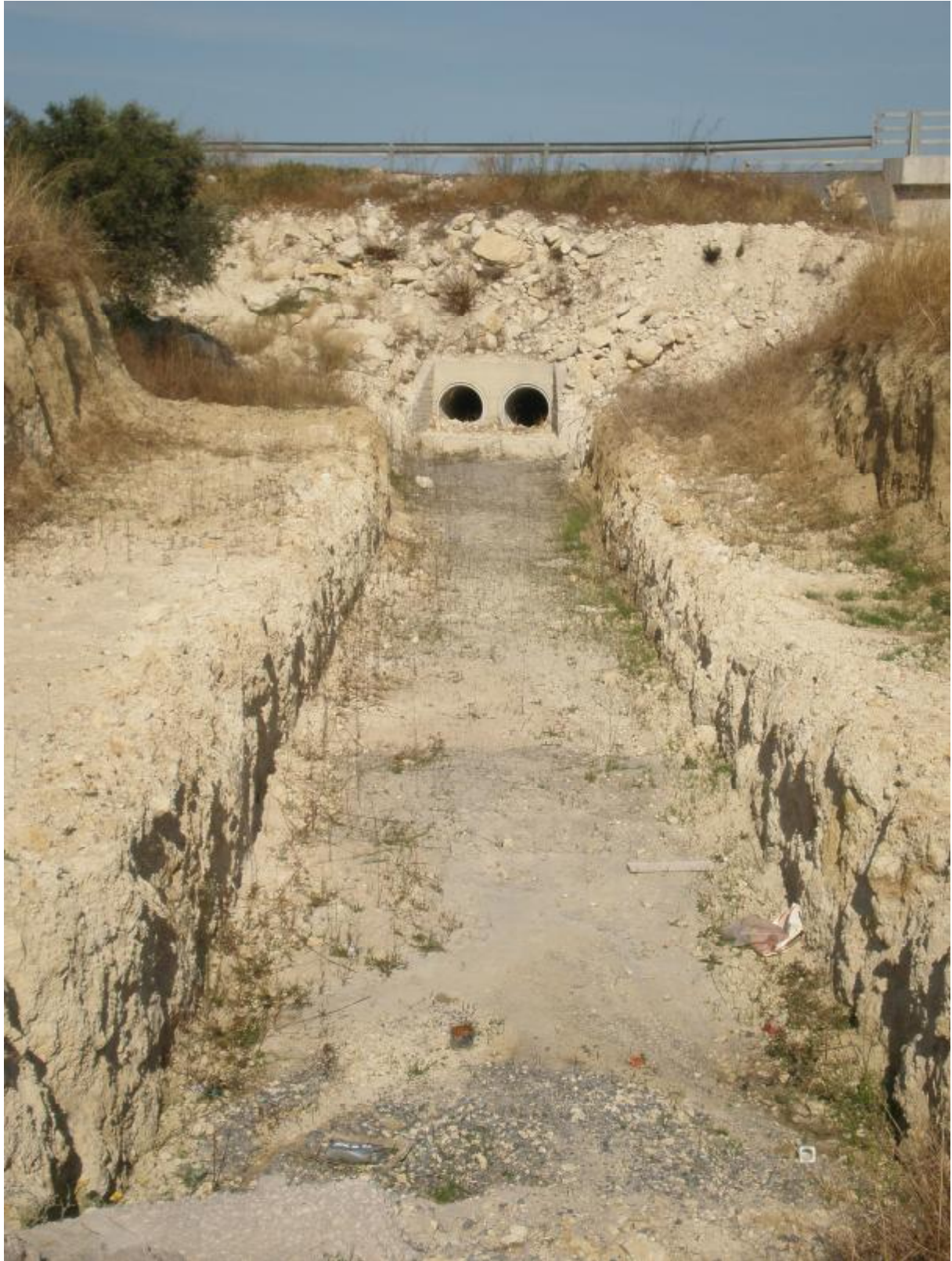
Φωτ. 6.26 Έξοδος-απορροή δίδυμου σωληνωτού οχετού Φ100.
